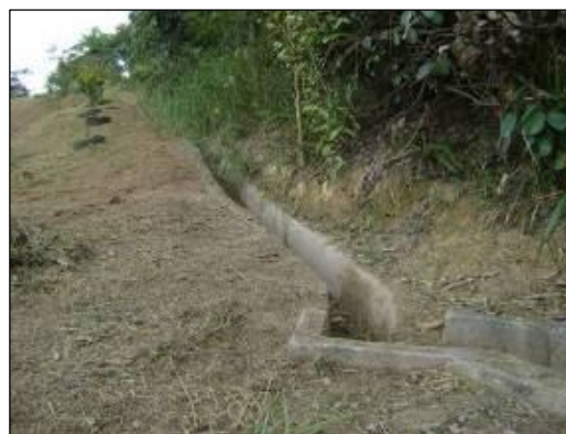
Figura 18: Drenagem pluvial próximo à área de tratamento de percolados.
