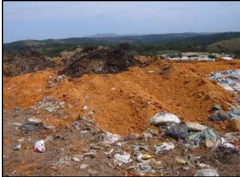
Figura 14: Cobertura dos resíduos com argila e resíduos de poda e capina.
