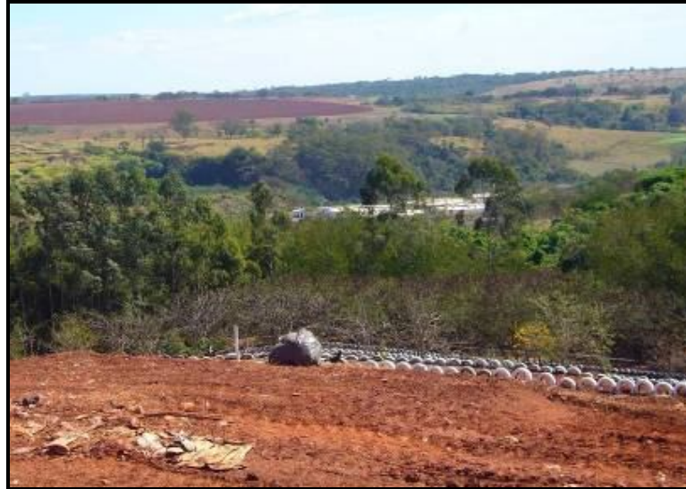
Figura 39: Vista da ETE Uberabinha localizada próxima ao aterro.
