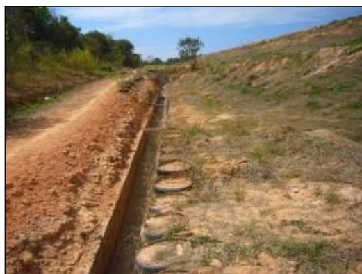
Figura 17: Drenagem pluvial no entorno do aterro.
