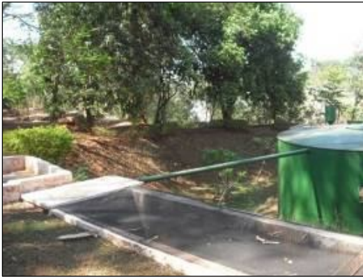
Figura 42: Tratamento de percolado.
