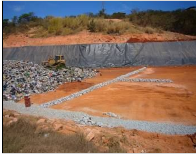
Figura 27: Vista do sistema de impermeabilização de base do aterro.
