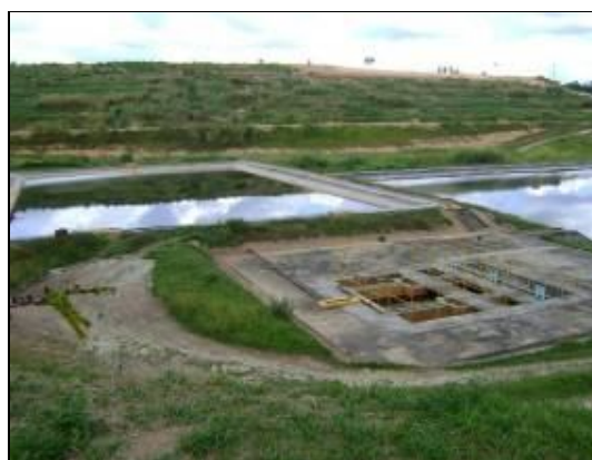
Figura 16: Estação de tratamento de percolado.
