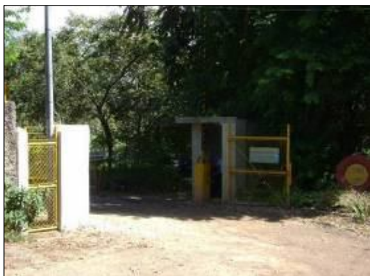
Figura 9: Portão de acesso da CTRS.
