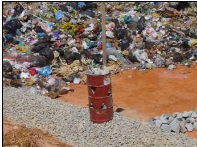
Figura29: Vista da construção de um dreno de biogás interligado ao dreno principal de lixiviado.
