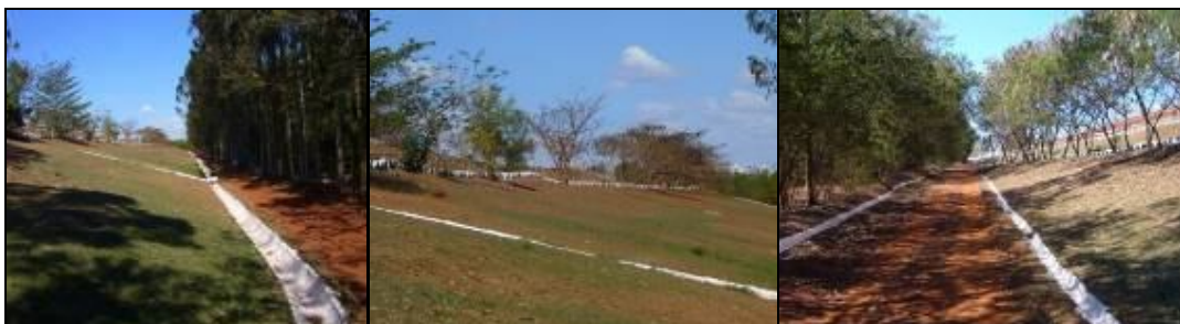
Figura 40: Caneletas para drenagem pluvial.
