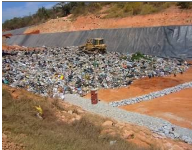
Figura 29: Drenos de líquidos percolados executados sobre a camada de argila da base.
