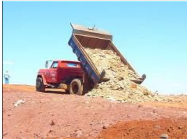
Figura 39: Execução da camada de cobertura intermediária de argila e resíduos de construção civil.
