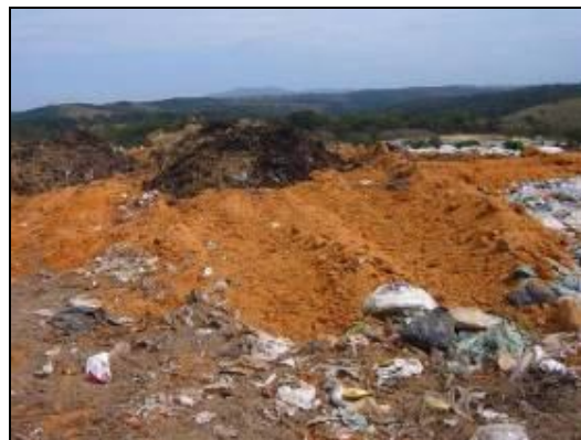
Figura 12: Cobertura dos resíduos com solo e material verde.
