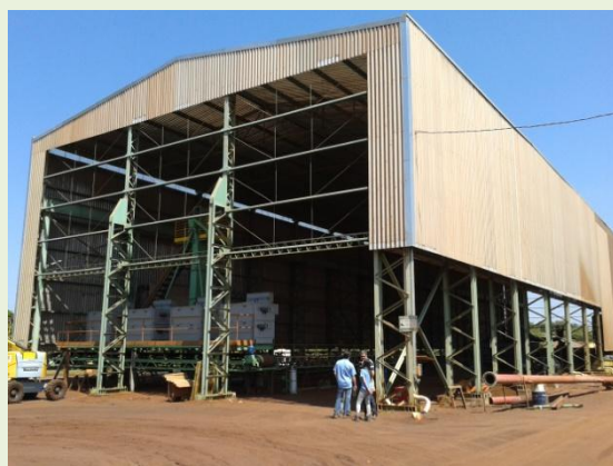
Foto 10 - Vista do Galpão da BLOCOITA.
