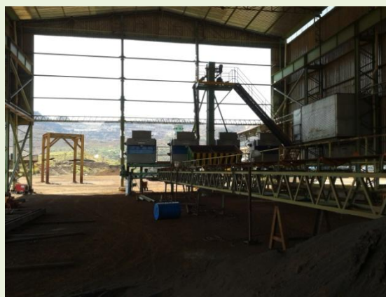
Foto 08 - Correia Transportadora da BLOCOITA.
