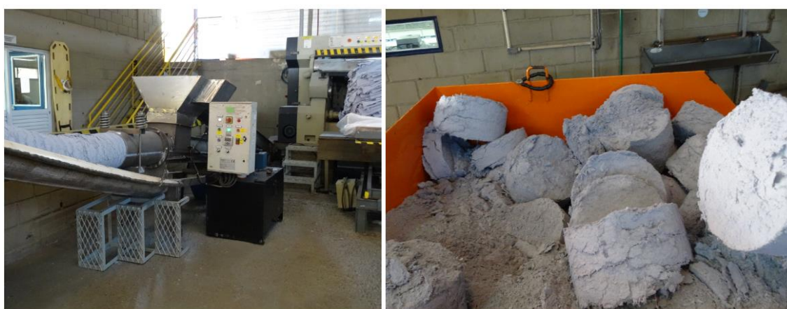
Figura 11 – Lixadeira acoplada com compactador de pó, à esquerda e pó compactado em caçamba, à direita
