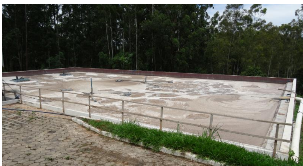
Figura 7 – Reator de lodos ativados tratando efluente líquido de curtume
