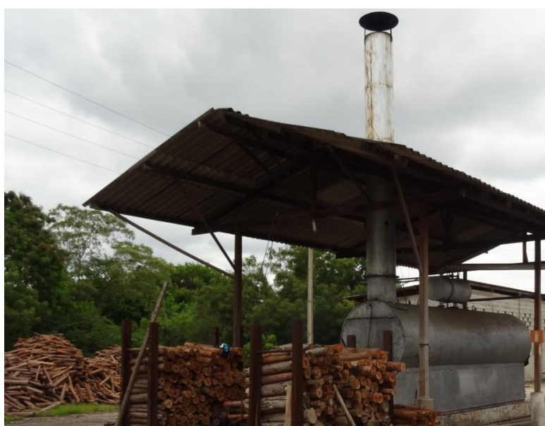
Figura 13 – Caldeira queimando lenha de eucalipto
