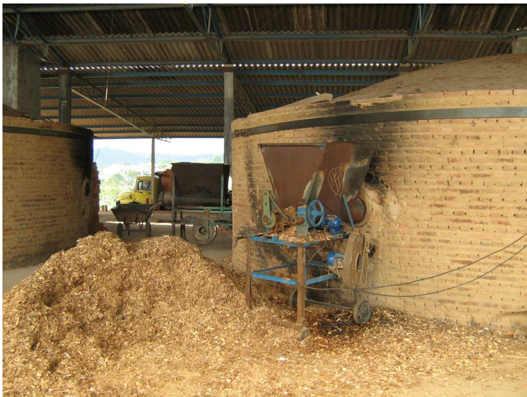
Figura 3-4 - Forno Abóboda com alimentador para queima de serragem.
