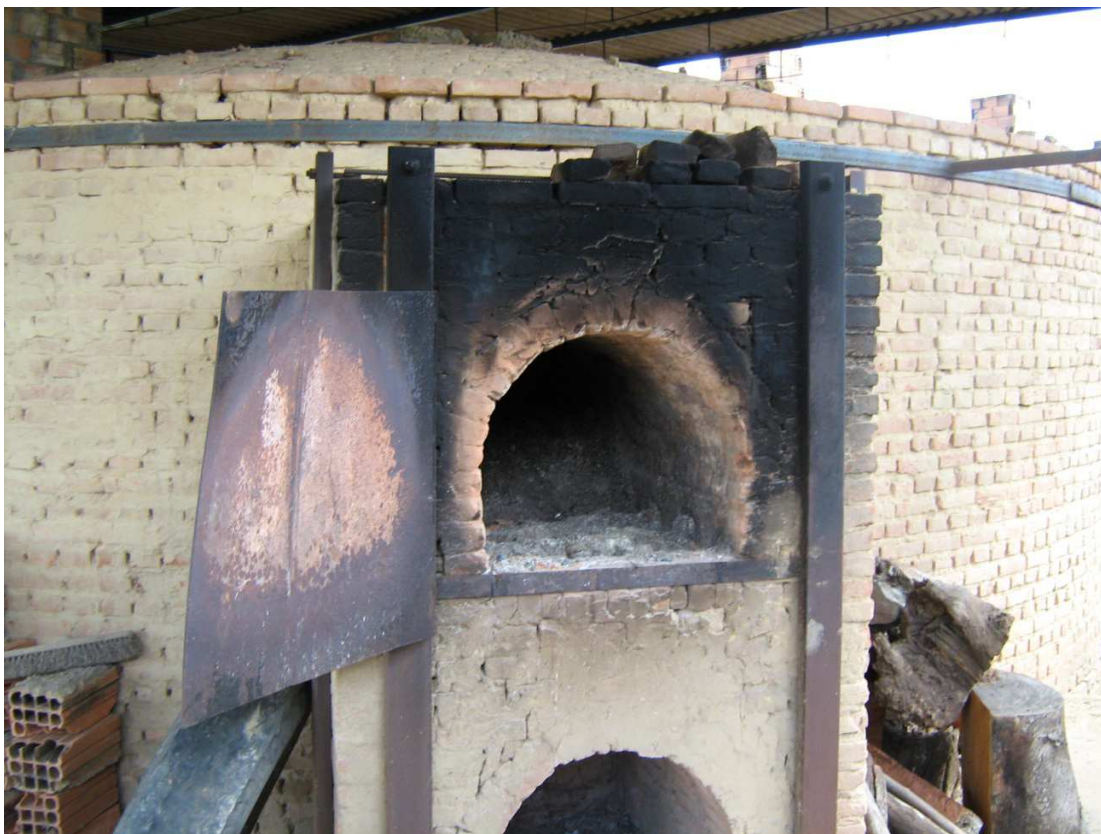
Figura 3-6 - Detalhe do queimador lateral de um forno abóboda
