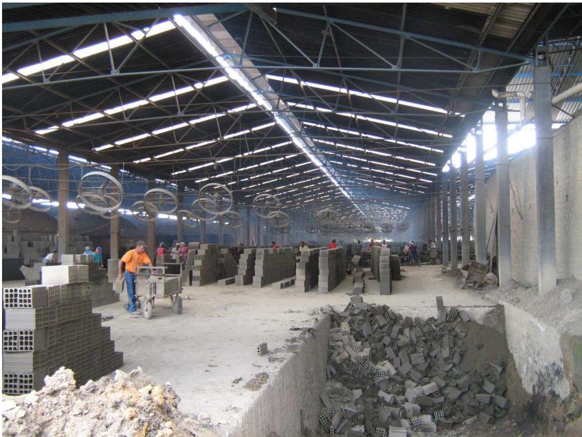
Figura 3-8 - Secagem forçada com ventiladores em galpão
