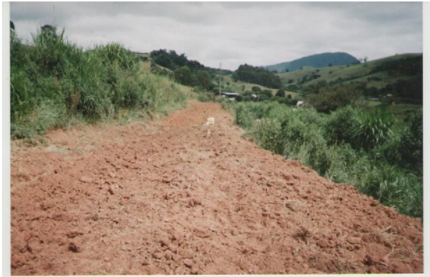
Figura 5. 1 - Vala de efluentes à direita.
