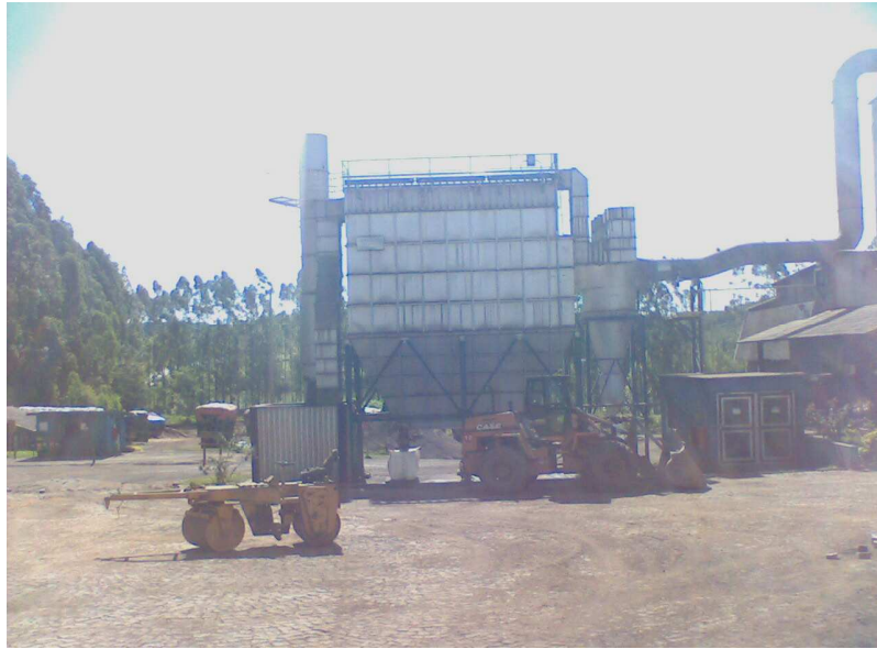
Figura 3.7 - Sistema de despoeiramento de um forno de ferro-manganês composto de ciclone defagulhador e filtro de mangas
