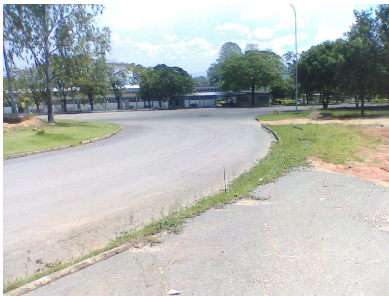
Figura 3.1 - Via de tráfego de veículos asfaltada
