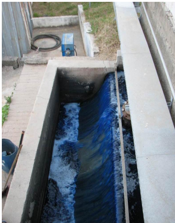
Figura 14 – Peneiras da ETE, efluente industrial
