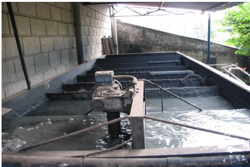
Figura 12 – Tanque de flotação e decantação, vista superior
