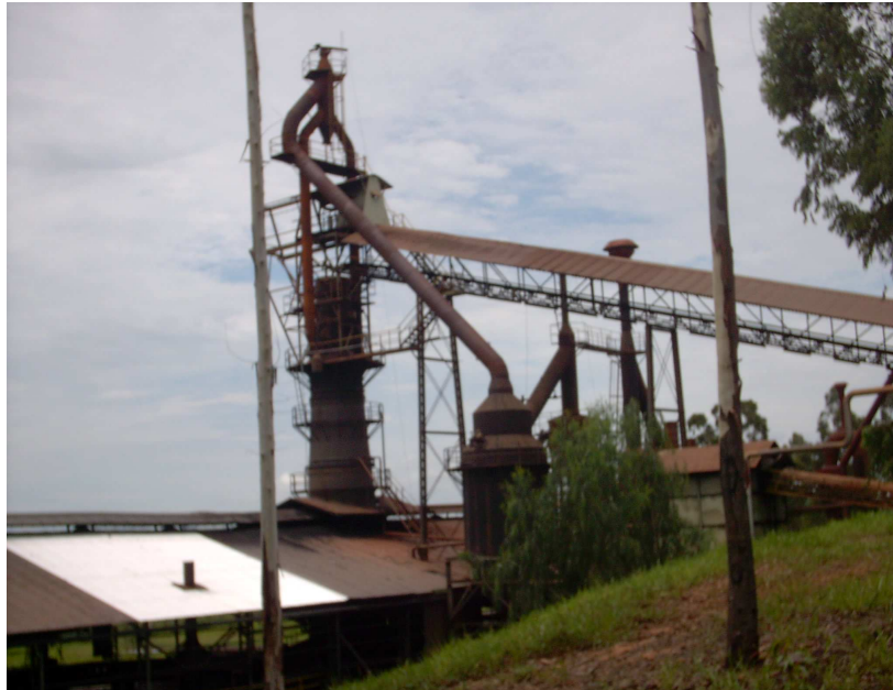
Vista da parte superior de um alto-forno a carvão vegetal
