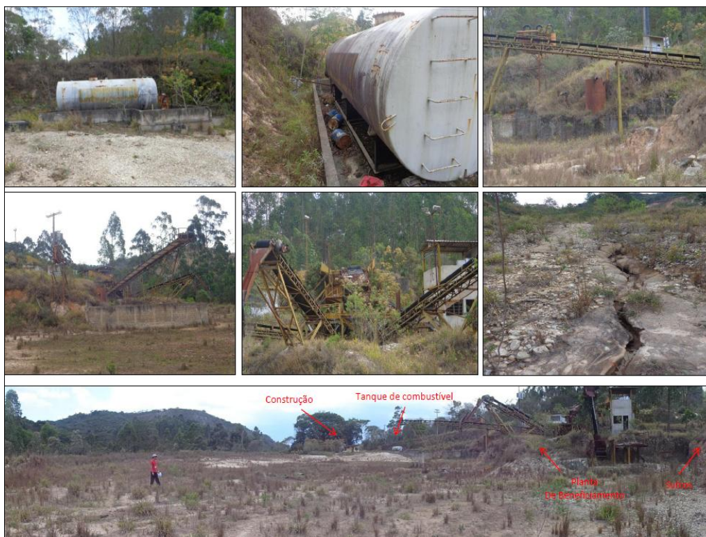
Figura 10 - Mina abandonada com diversos equipamentos abandonados.
