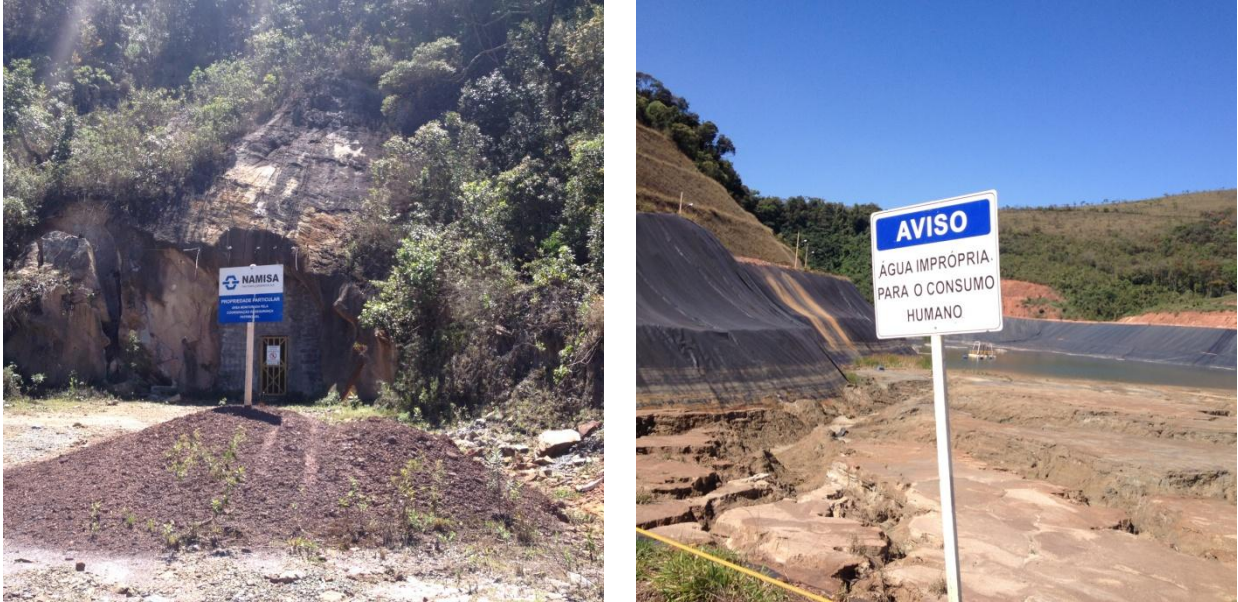
Figura 2 - Minas paralisadas com controle ambiental – Sinalização e controles ambientais implementados.
