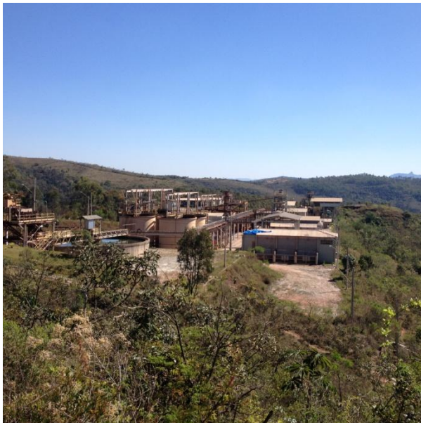
Figura 3 - Planta de beneficiamento com a correta manutenção em mina paralisada com controle.
