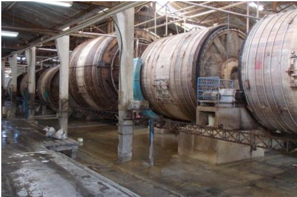
Figura 3: Vista de uma bateria de fulões
