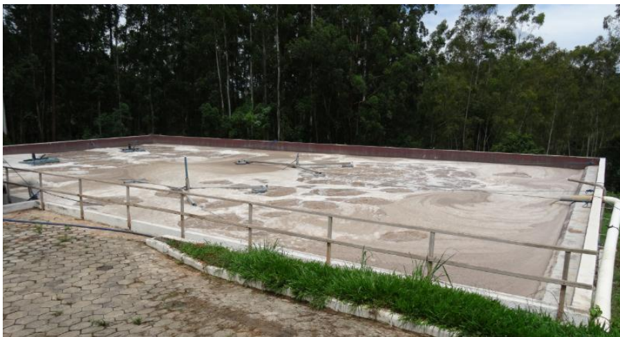
Figura 10: Reator de lodos ativados tratando efluente líquido de curtume
