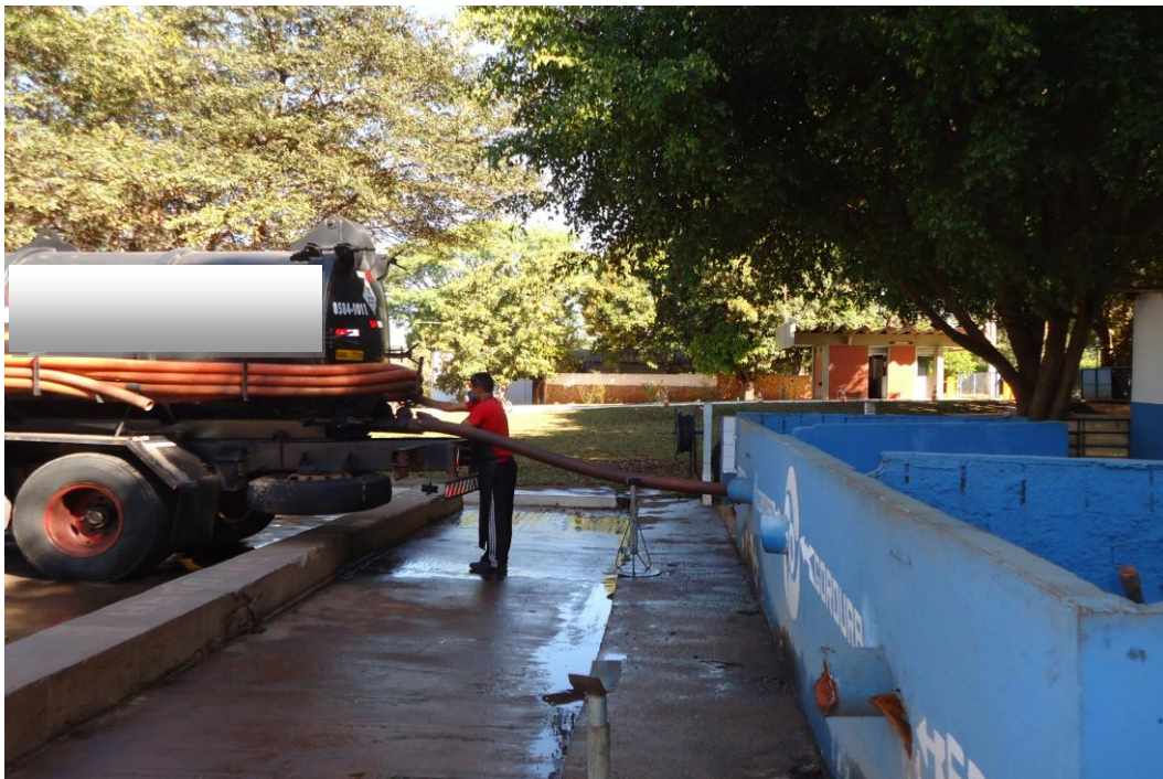
Figura 7-2 – Operador realizando a operação de deságue do lodo em ETE.
