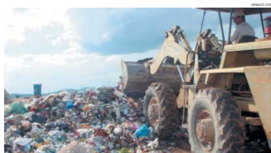
Início do trabalho de remediação
