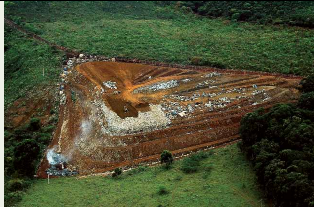
Relleno sanitario de la región de Barreiro, en la Grande Belo Horizonte.
