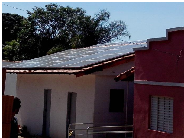
Vista frontal dos painéis superpostos ao telhado – Água norte da Casa fraldário.
