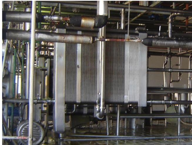
**Figura 4 – Trocador de calor**
