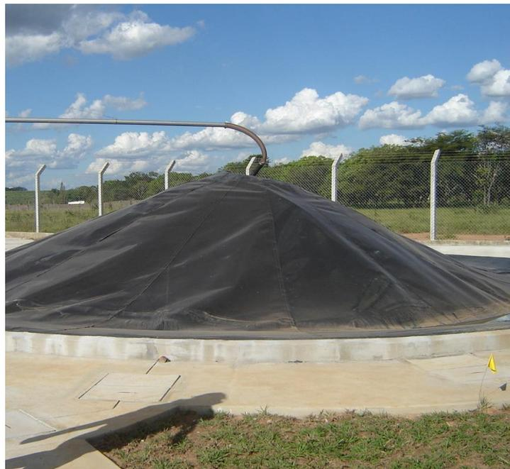
**Figura 17 – Biodigestor**
