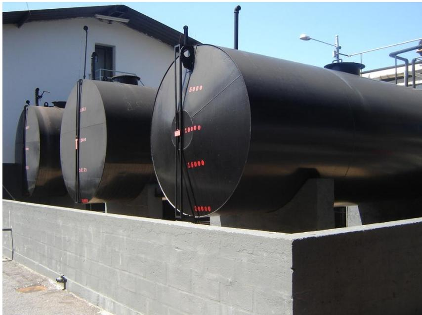
**Figura 22 – Tanques de combustível e bacia de contenção**
