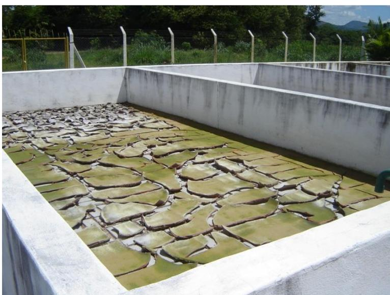
**Figura 32 – Leitos de secagem de lodo**
