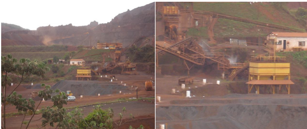
Figura 30: Instalação de Tratamento de minério da Minas Itatiaiuçu. Fonte: FEAM, 2006.
