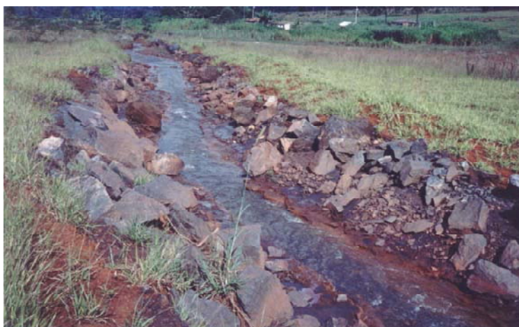
Figura 54: Córrego Samambaia após a conclusão das obras de reabilitação. Fonte: FEAM, 2006.
