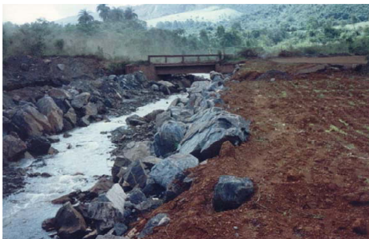
Figura 53: Córrego Samambaia durante os trabalhos de reabilitação ambiental. Fonte: FEAM, 2006.
