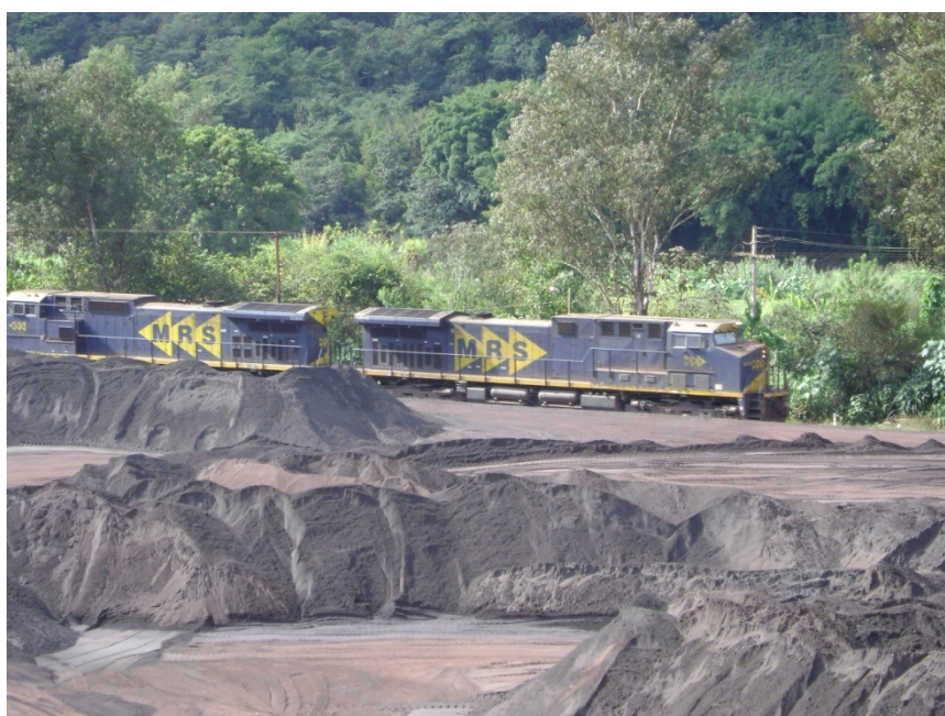
Figura 44: Situação Atual do Terminal Serra Azul - TSA Fonte: YKS, 2011
