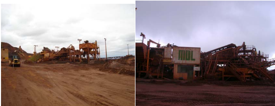
Figura 33: Instalação de Tratamento de Minério – UTM e canal de desaguamento de rejeitos Fonte: FEAM, 2006 / YKS 2011.
