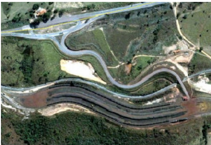
Figura 41: Terminal Rodo-ferroviário Modal de Itaúna. Fonte: VIVEIROS, 2009.
