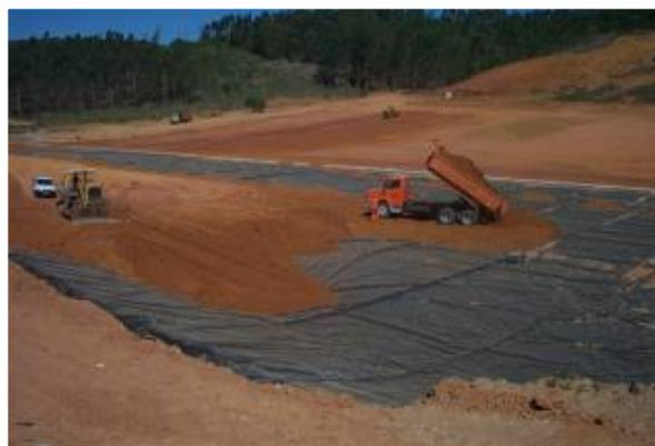
**Figura 6 - Camada Base - Geomembrana**
