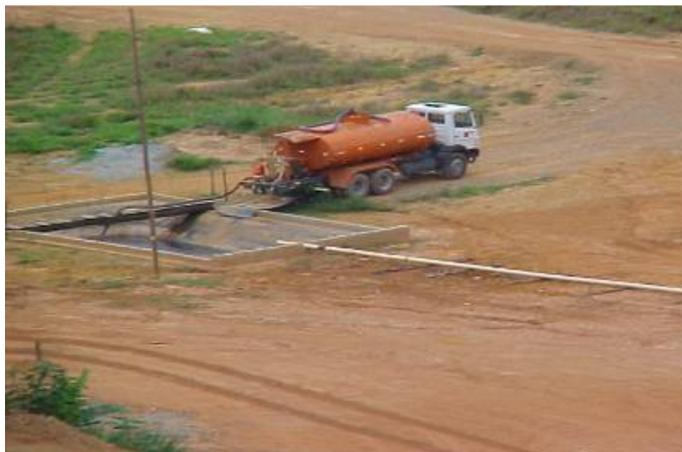
**Figura 7 - Reservatório de Coleta de Chorume**
