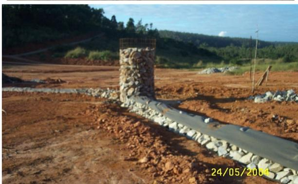
**Figura 5 - Drenos de Chorume / Poços de Dreno da Camada Base**
