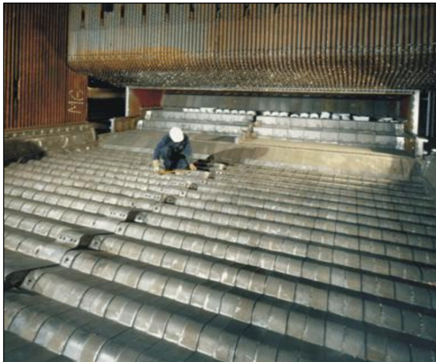
Figura 64 - Grelha Horizontal
