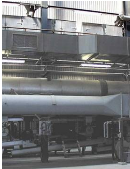
Figura 65 - Sistema de recirculação de gases
