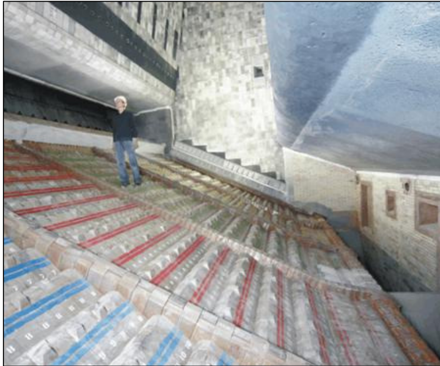
Figura 63 - Grelha de Ação Reversa
