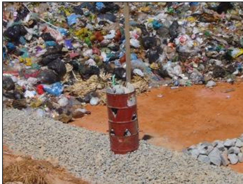
Figura 4: Vista da construção de um dreno de biogás interligado ao dreno principal de lixiviado.
