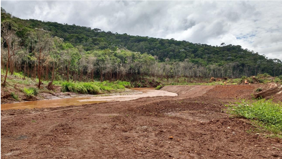
Figura 3: Trecho com retaludamento na margem direita e sem intervenções na margem esquerda.
