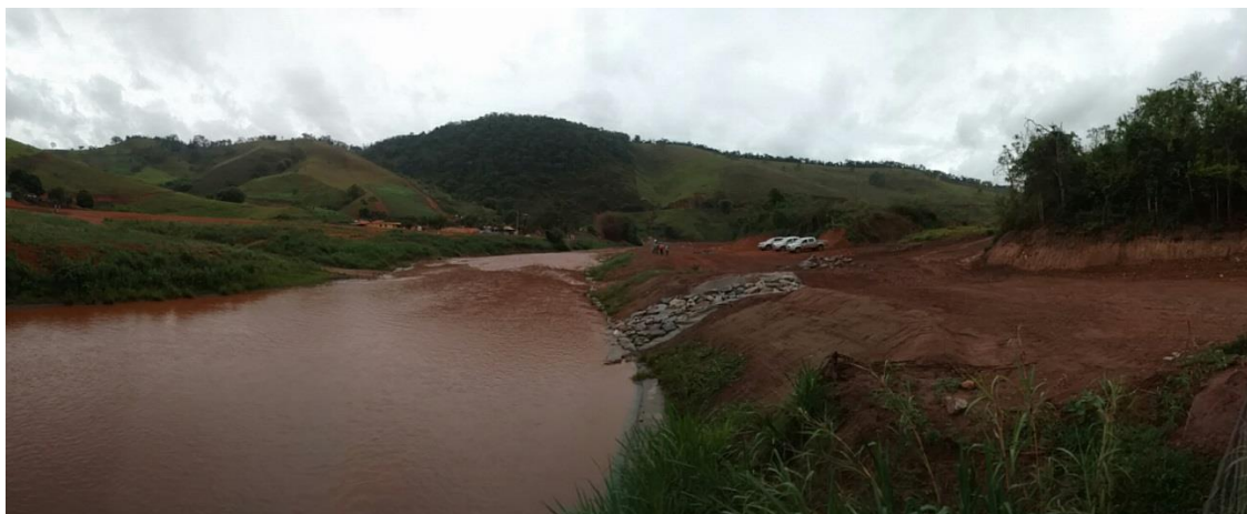
Figura 2: Visão geral da área 400 com taludes e canais de drenagem
