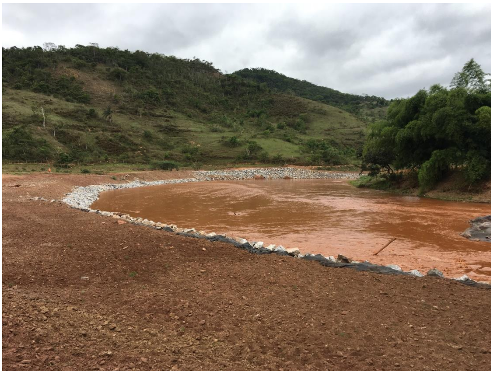
Foto 05: Ponto 02_TR 15. Trecho do rio do Carmo que a margem esquerda foi enrocada com blocos de rochas e solo com pequenos coveamentos que foram plantados o mix de vegetação.
