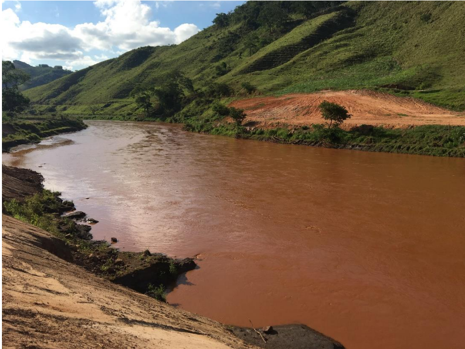
Foto 26: Ponto 12 _TR 15. Vista geral do talude reconformado.
