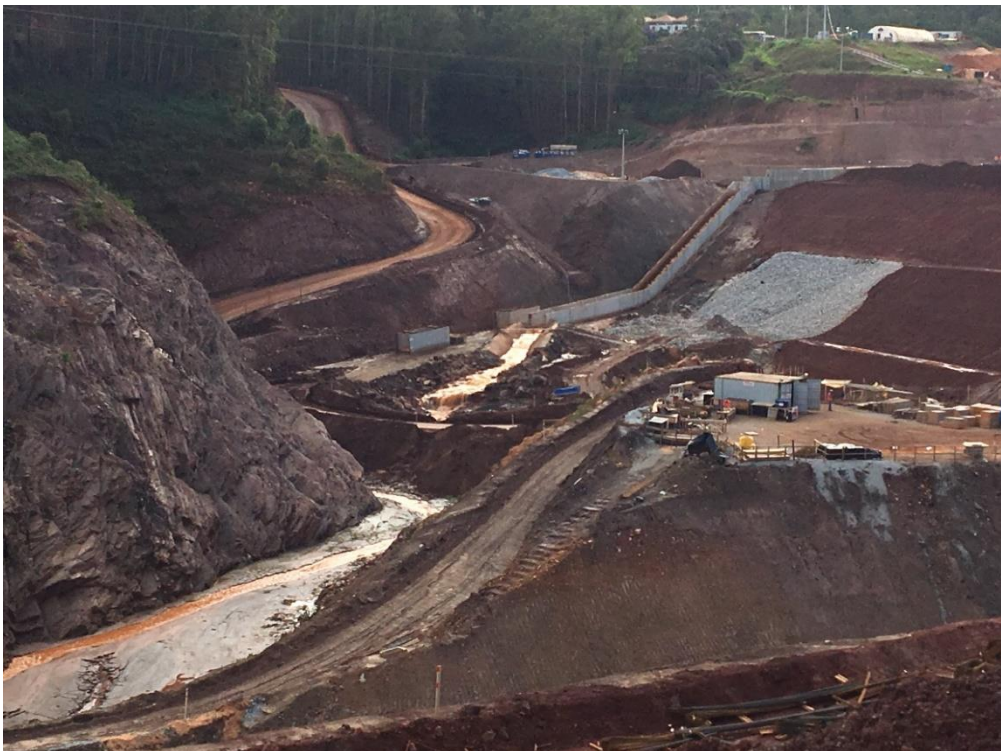
Foto 08: Ponto 04_TR 10. Vista geral da área de montante do dique S1 e a construção da barragem Nova Santarém e o desvio do córrego Santarém para a construção do maciço dessa barragem.
