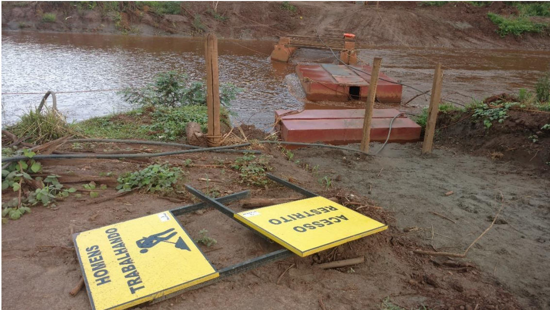
Figura 9: Balsas e sinalização de acesso à margem esquerda do rio.
