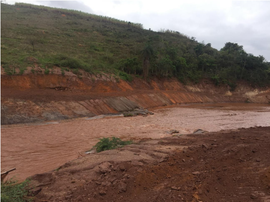
Foto 13: Reafeiçoamento do terreno e revolvimento do rejeito na margem direita.
