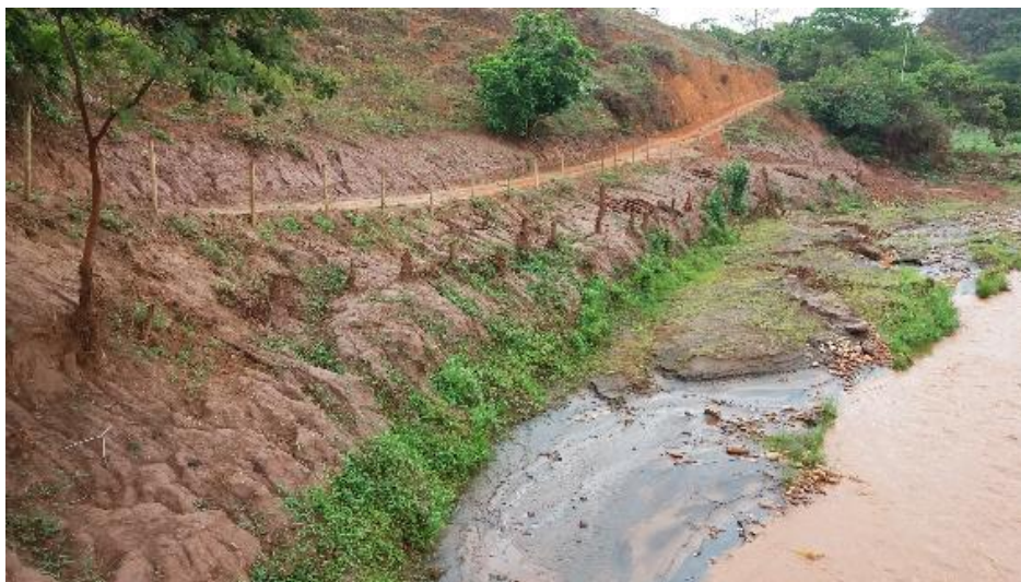
Figura 10: Detalhe da margem - Quarto Ponto na área 9 – Montante.
