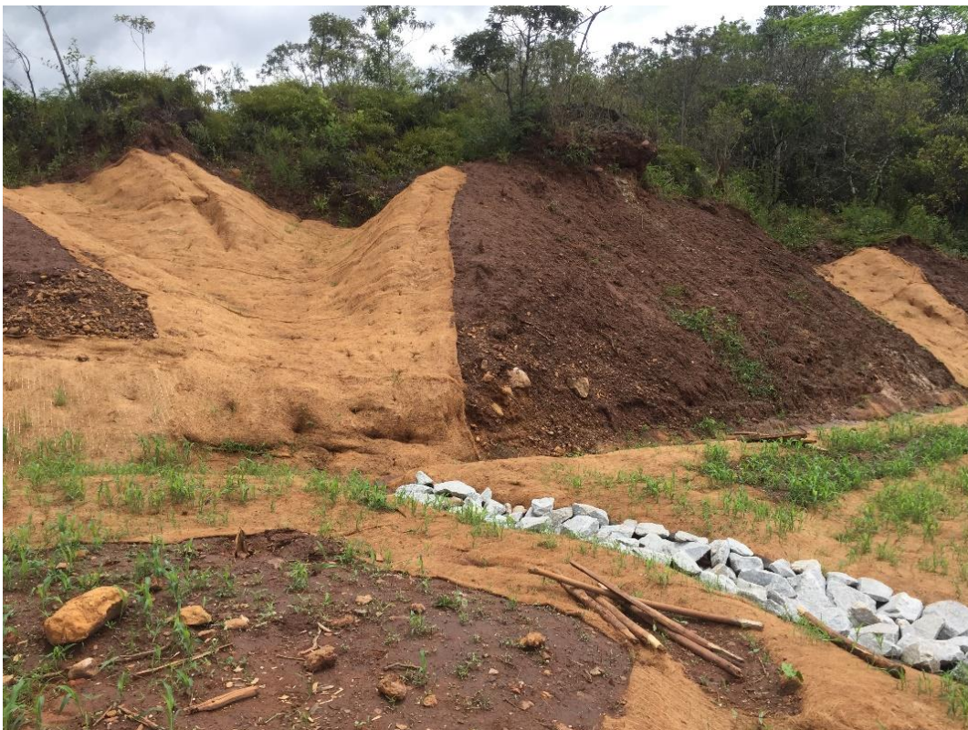
Foto 3: Canaletas de crista e de berma revestidas com biomanta.
