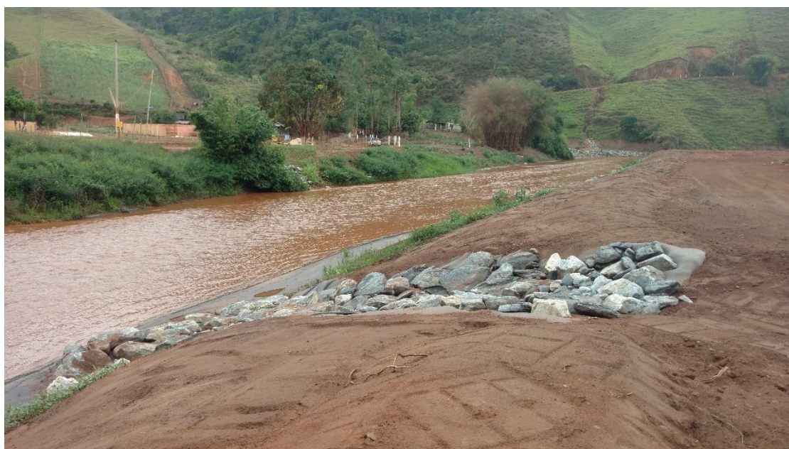
Figura 1: Canais de drenagem com geotêxtil e enrocamento
