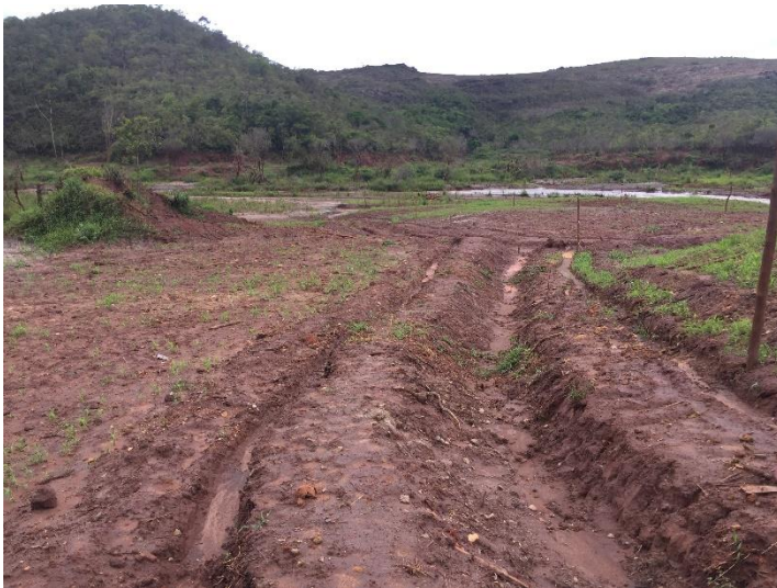
Foto 7. A: Leiras perpendiculares ao curso d'água. B – Leiras preparadas para receber biomanta.
