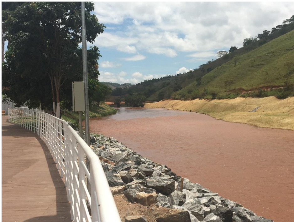
Foto 12: TR 15. Vista da margem direita em que a SAMARCO reconstruiu a praça, as casas destruídas pela lama, a recuperação dos taludes com bioengenharia, bem como nos pontos de direcionamento das águas pluviais frgamentos de rocha para proteger o talude e dissipar a energia.
