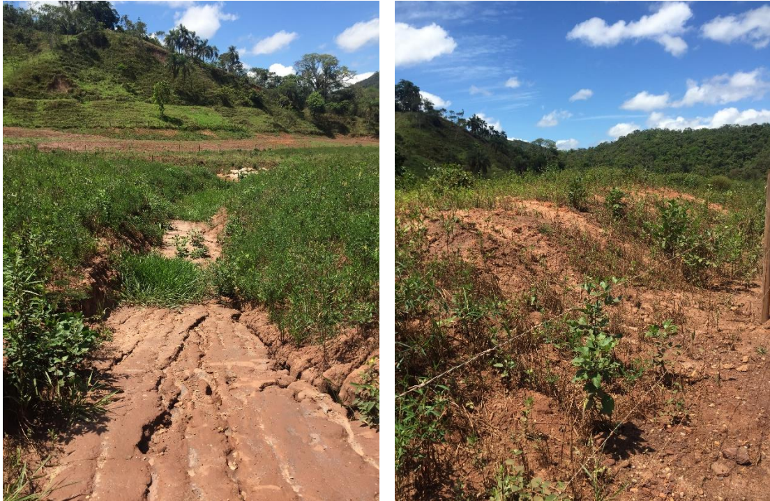
Foto 3. A: Rampa de acesso ao rio com intenso ravinamento. Foto 3. B: Talude da rampa de acesso também com processos erosivos.
