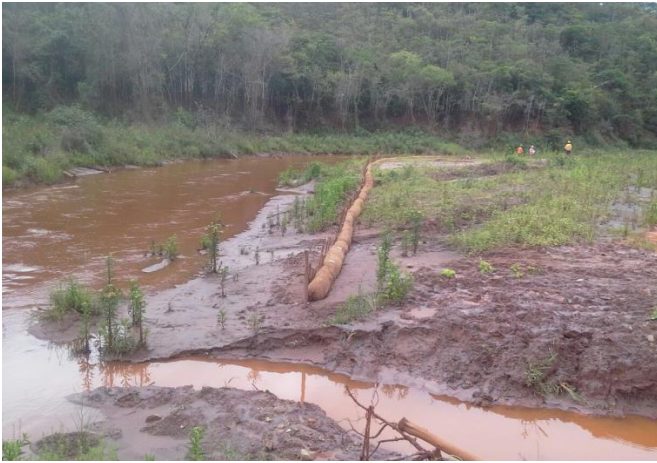
Foto 1. A e B: Retentores de sedimentos já instalados.
