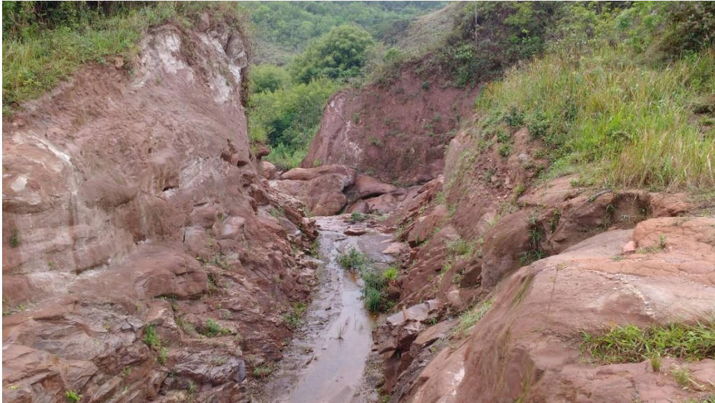
Figura 12: Canal extravasor da antiga PCH Bicas.
