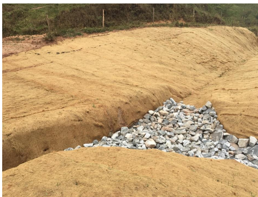
Foto 14: Ponto 07_TR 15. Depressão localizada no terreno com biomanta que tem com finalidade captar e direcionar da água pluvial sendo que na descida dessa água para o rio, foram colocados os fragmentos de rocha para proteção e dissipação de energia.
