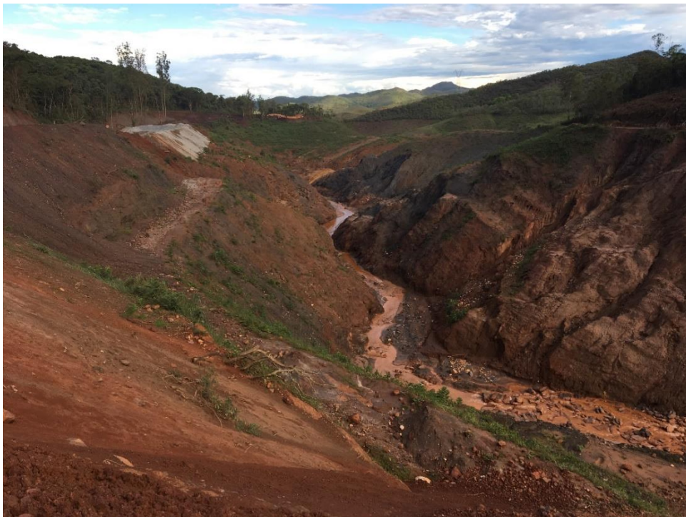
Foto 06: Ponto 03_TR 10. Vista geral da calha do córrego Santarém impactada com a descida da lama em que observamos altas declividades e solo exposto com instalação de processos erosivos.
