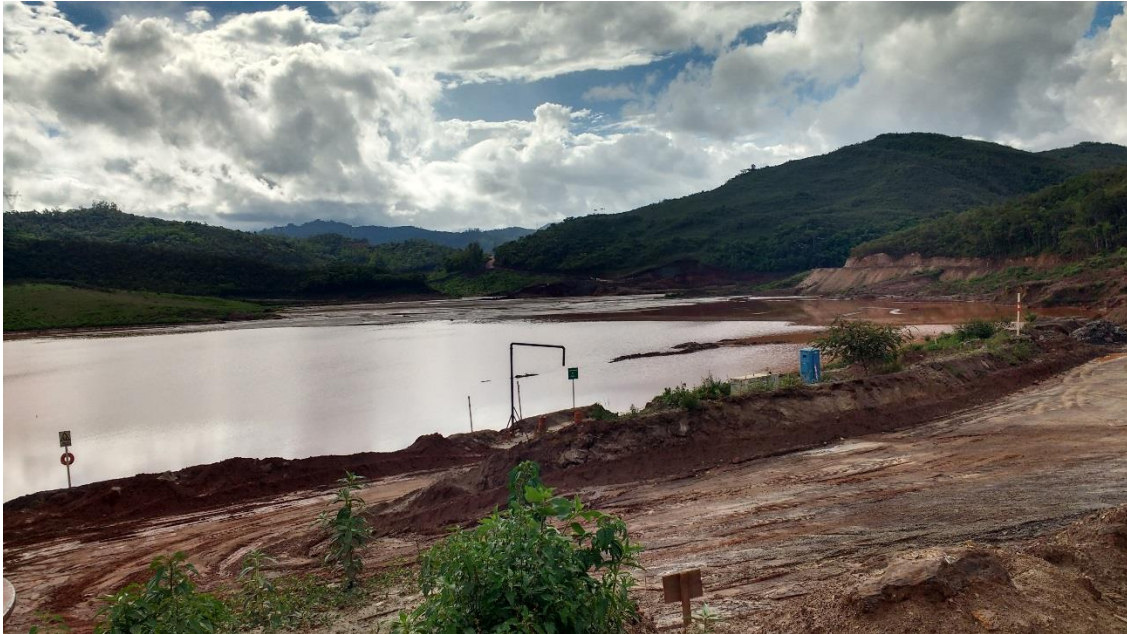
Figura 4: Área de alagamento do dique S3
