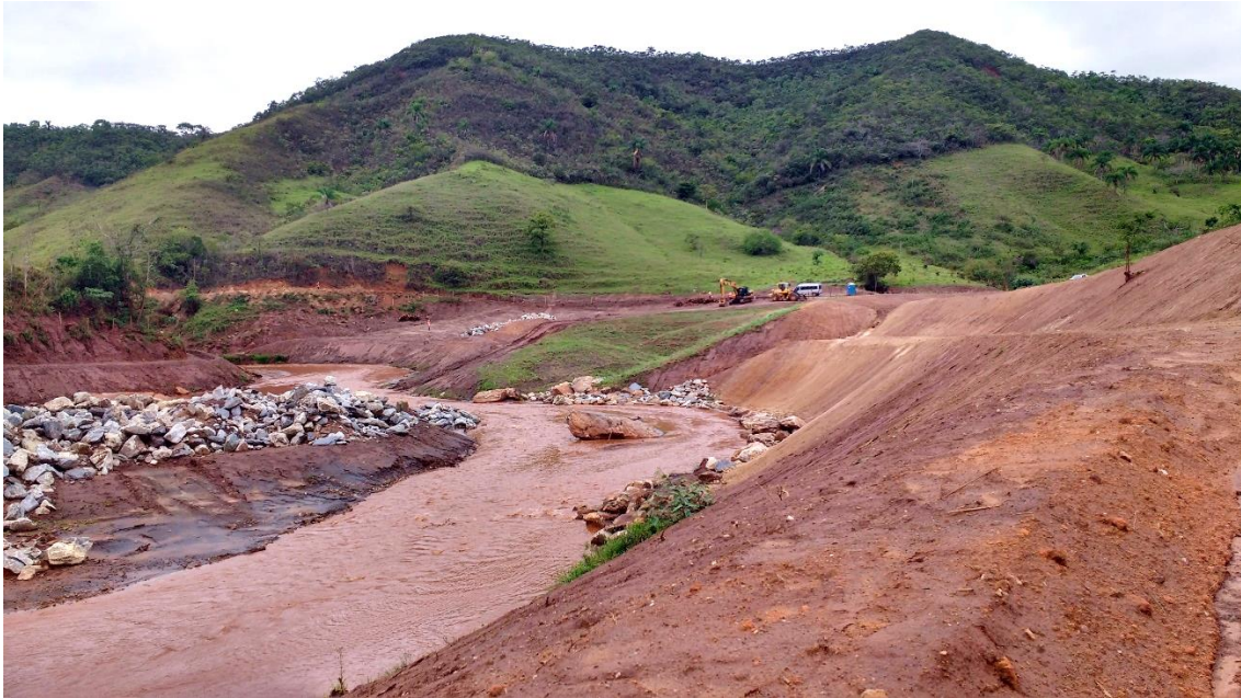
Figura 4: Foto Trecho TR08-306. Observa-se: a) o retaludamento das margens e enrocamento na base do talude; b) biomanta na confluência com tributário
