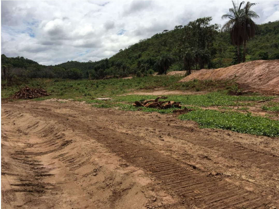
Foto 11: Ponto 03_TR 09. Vista de parte da área em que evidenciamos a presença de montes de galhos de árvores, uma reconformação da planície, leiras na parte direita da foto e vegetação (forrageira) desenvolvida de forma irregular no rejeito depositado nessa margem.
