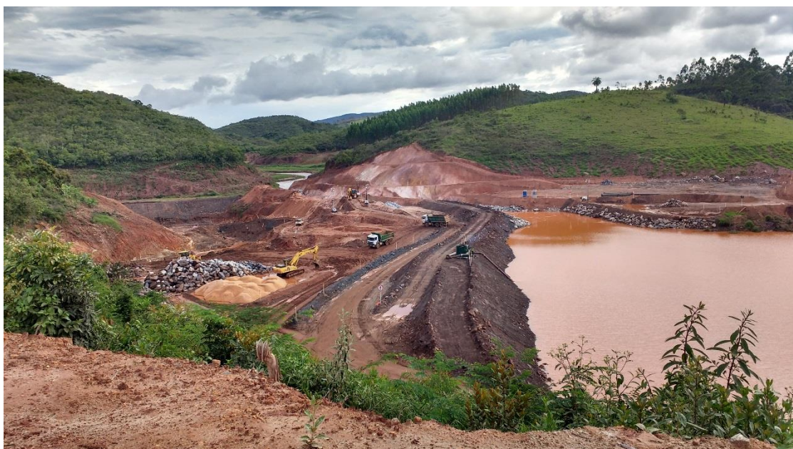
Figura 8: Dique S4 em construção.
