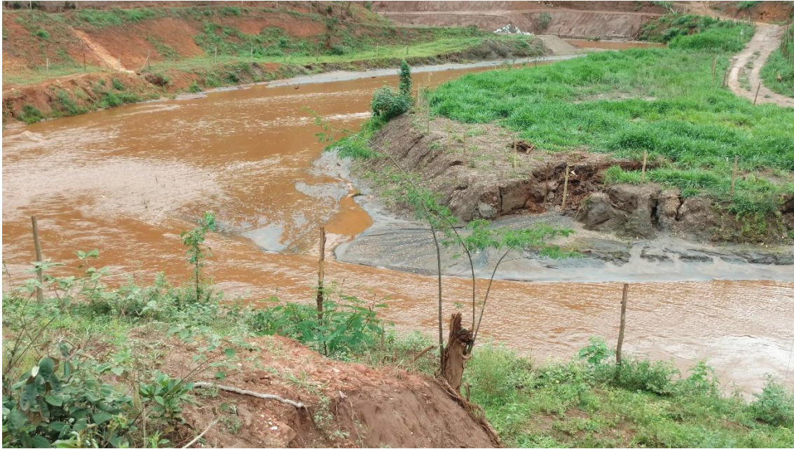
Figura 10: Planície de inundação com desenvolvimento de vegetação no TR08-307. Observa-se erosão no talude com rejeito onde a vegetação não desenvolveu.
