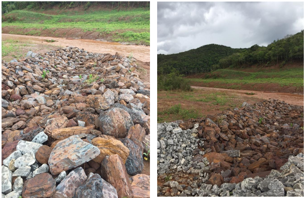
Foto 11. A e B: Enrocamento com pedras de grande dimensão no tributário TG-03.
