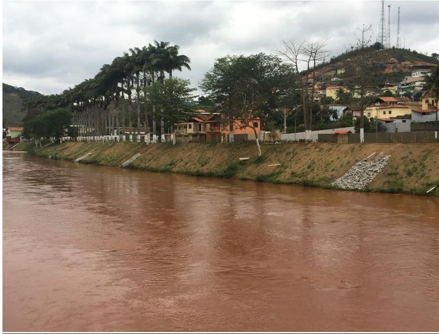
Foto 11: TR 15. Vista da margem direita em que a SAMARCO reconstruiu a praça, as casas destruídas pela lama, a recuperação dos taludes com bioengenharia, bem como nos pontos de direcionamento das águas pluviais frgamentos de rocha para proteger o talude e dissipar a energia.
