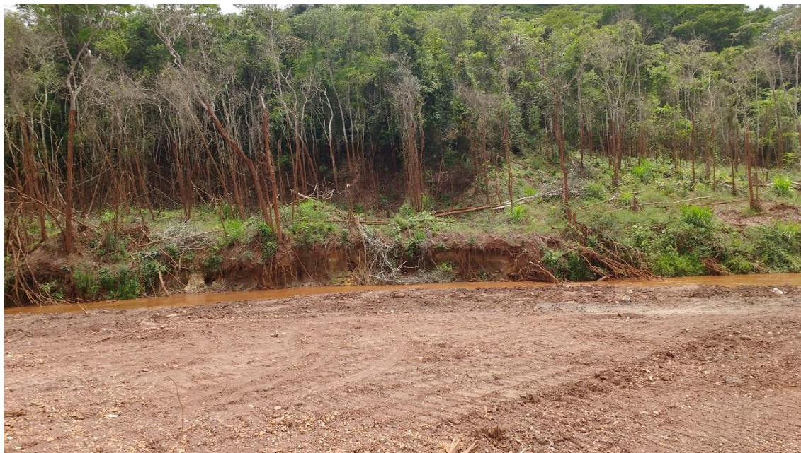
Figura 5: Solo e raízes expostas na margem esquerda.
