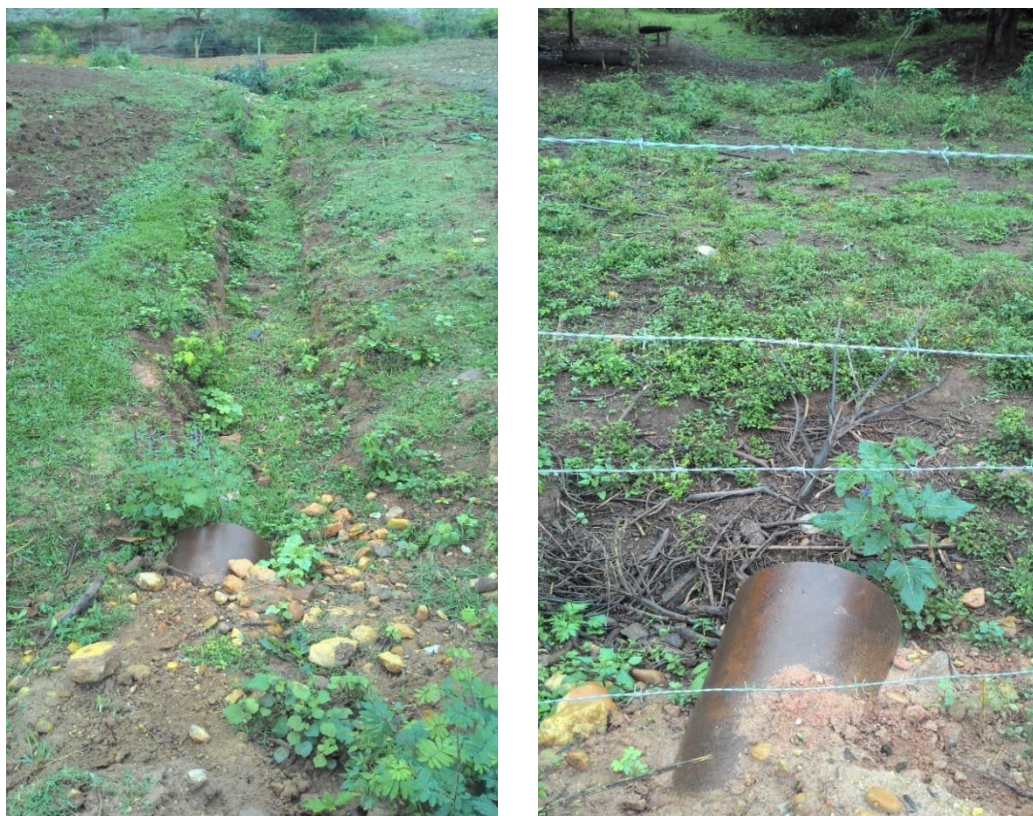
Foto 31: Canaleta de drenagem.
