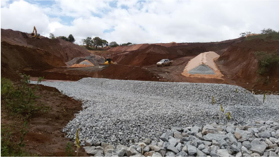
Foto 8: Pilhas de rejeito e de material próxima ao ponto TR02-03.
