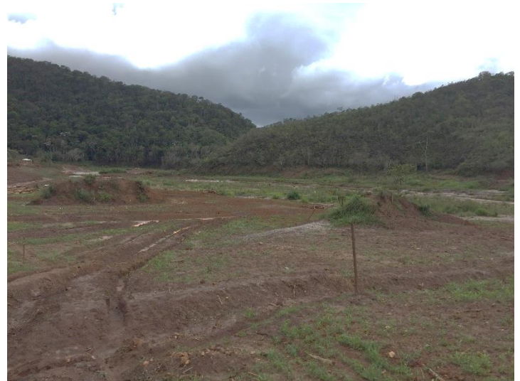
Foto 7. A: Leiras perpendiculares ao curso d'água. B – Leiras preparadas para receber biomanta.
