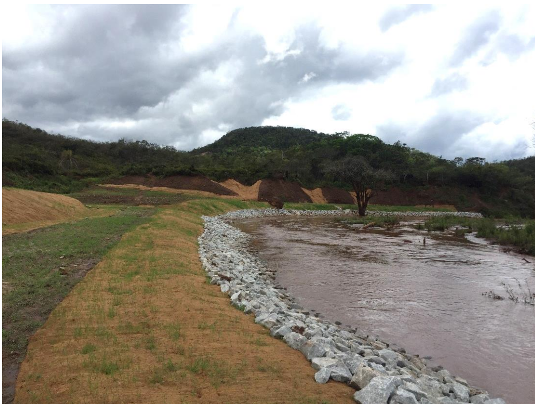
Foto 4: Canaletas de crista e de berma revestidas com biomanta.
