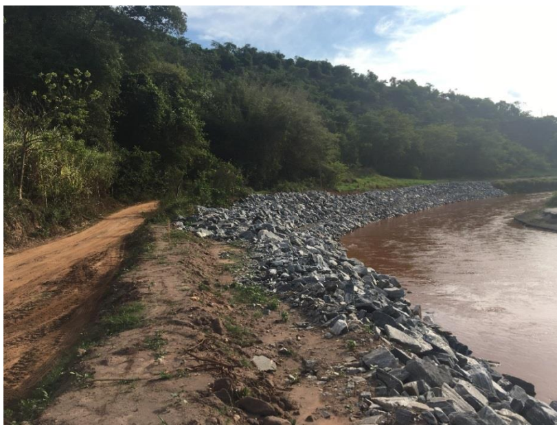
Foto 27: Ponto 13 _TR 15. Vista geral do talude reconformado e com enrocamento.
