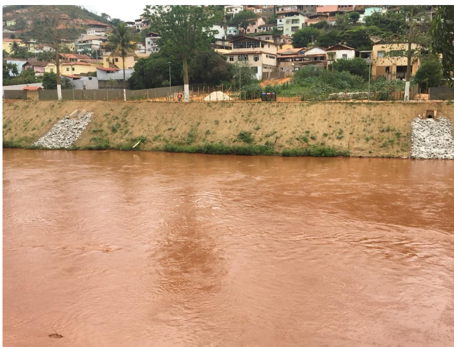
Foto 15: Ponto 08 _TR 15. Vista frontal do talude marginal com biomanta e as saídas das galerias com fragmentos de rochas para proteção e dissipação de energia da água pluvial.
