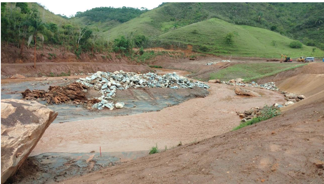
Figura 5: Foto Trecho TR08-306. Observa-se: a) ilha com cobertura de rejeitos na calha central do rio; b) Material lenhoso e rochas para enrocamento das margens; c) biomanta na confluência com tributário
