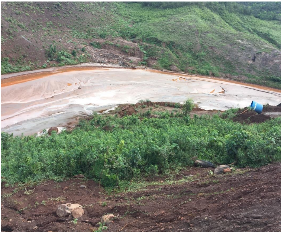
Foto 04: Ponto 02_TR 10. Vista geral da calha do córrego Santarém toda assoreada a jusante do dique S2.
