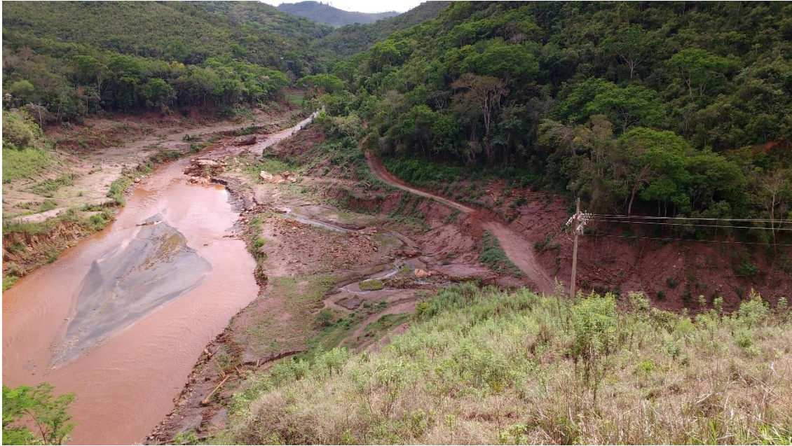
Figura 13: Ilha de rejeitos a jusante da PCH Bicas.
