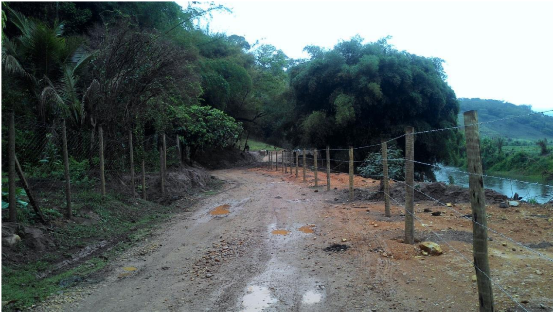
Foto 25: Instalação de cercas.
