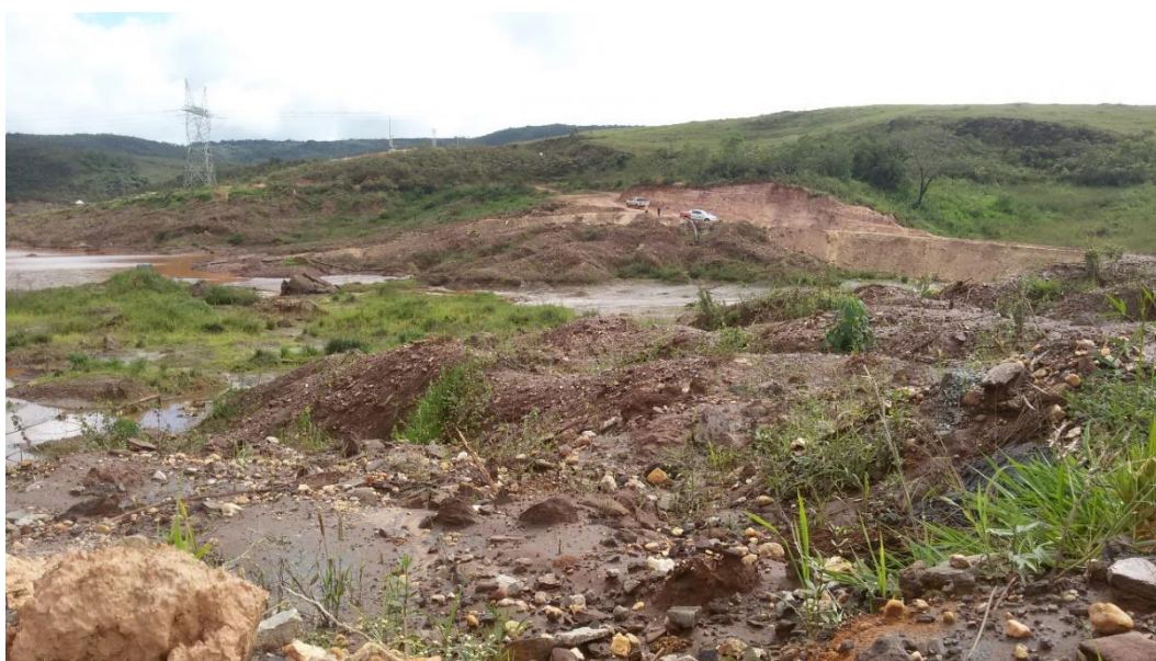
Foto 4: Intenso processo erosivo na margem direita.
