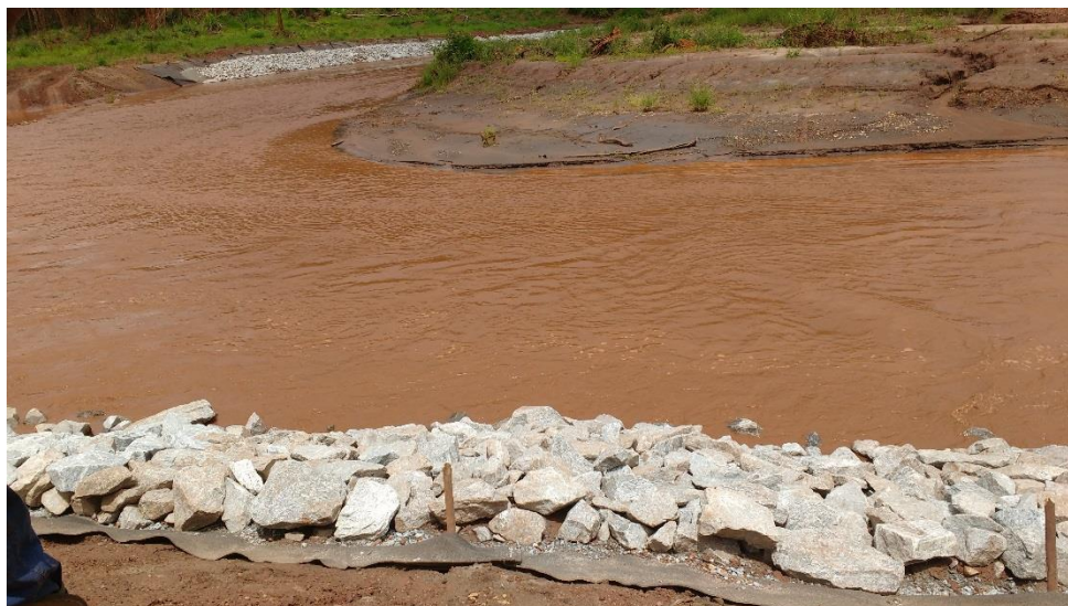
Figura 2: Enrocamento
