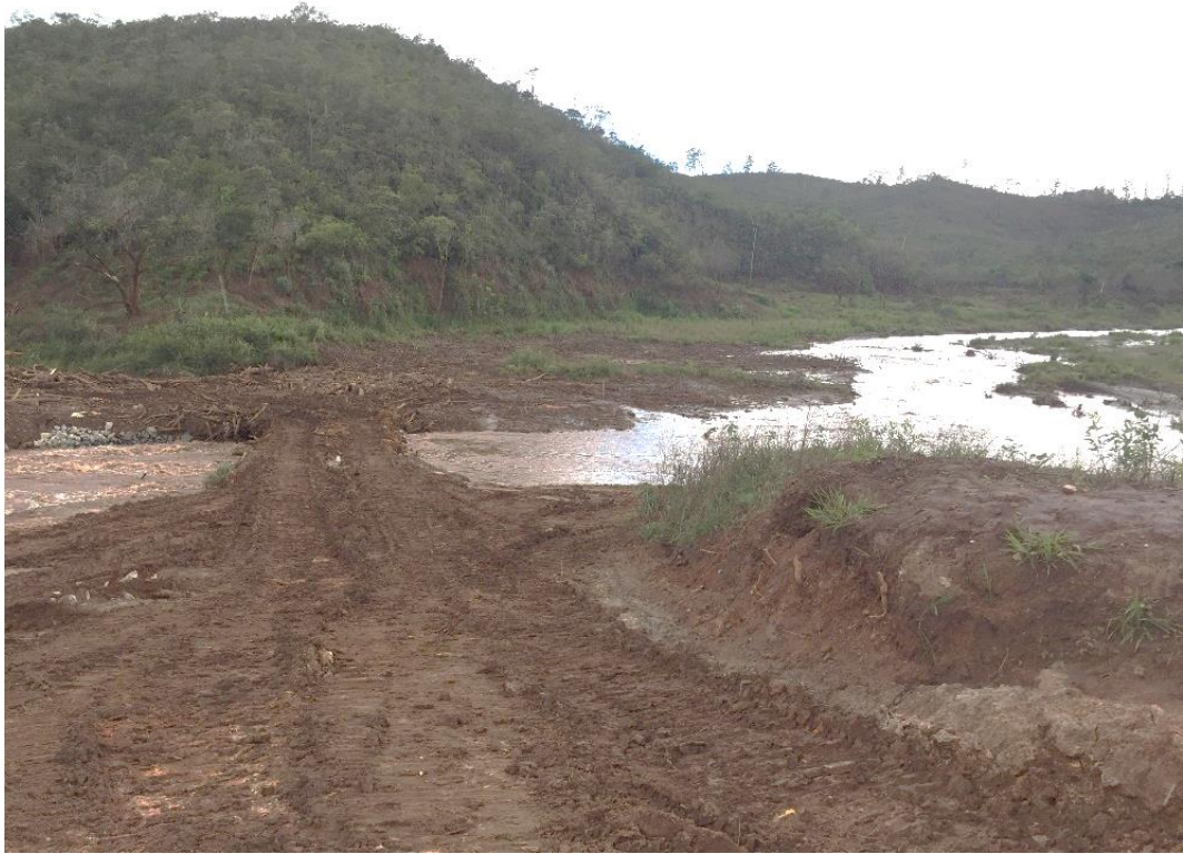
Foto 9: Canalização no Gualaxo para travessia.
