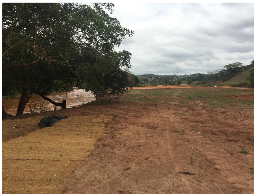
Foto 16: nas imediações do Ponto 08 _TR 15. Planície de inundação do rio do Carmo recebendo biomanta nos taludes marginais.
