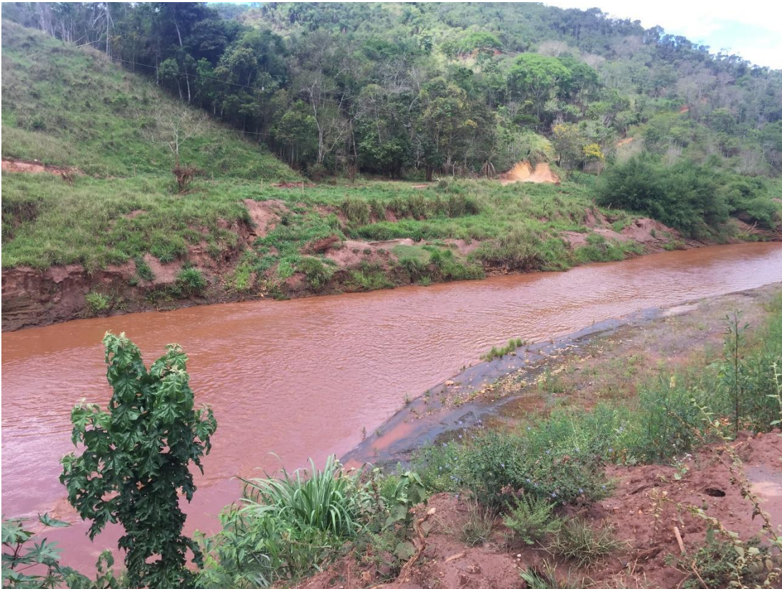
Foto 1: Talude marginal esquerdo.
