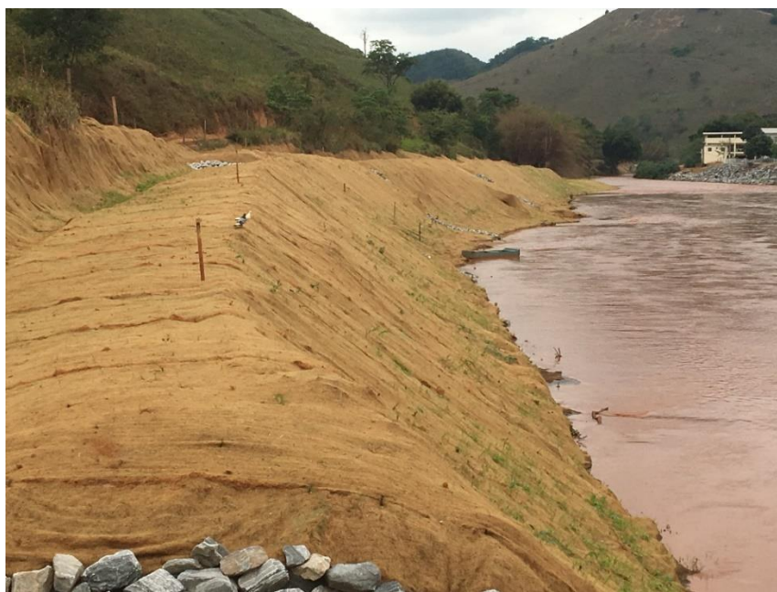
Foto 13: Ponto 07_TR 15. Proteção com a biomanta.
