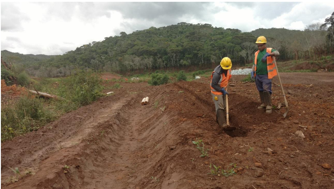
Figura 4: Confeção de canaletas para drenagem e contentores de rejeitos.
