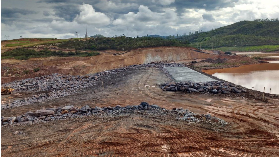
Figura 3: Alçamento do dique S3
