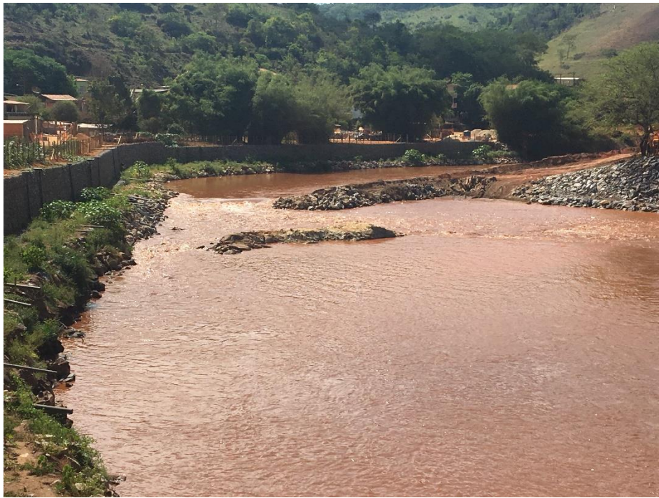
Foto 24: Planta G006900-C-100330 (folha 6/16) _TR 15. Acesso construído no rio para retirada de rejeito acumulado após a constrição de afloramento rochoso. Esta constrição a SAMARCO solicita a sua remoção.
