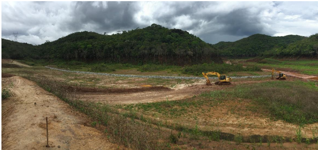
Foto 10 – Obras de reconformação de taludes iniciada na margem esquerda.
