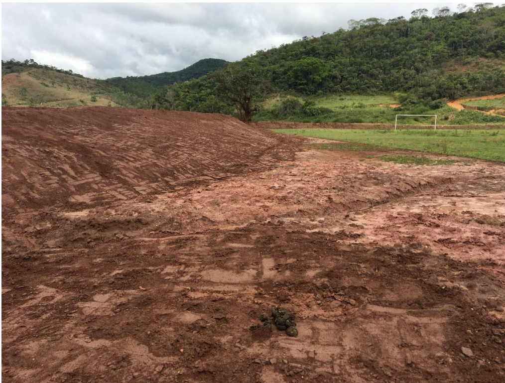
Foto 04: Ponto 02_TR 09. Vista ao fundo da foto do campinho de futebol em APP e à esquerda da foto, a implantação do murundu (leiras) susceptível a processo erosivo e carreamento dos sedimentos para o curso d'água.
