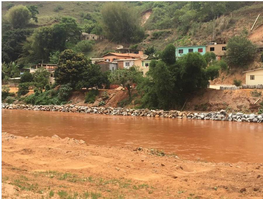
Foto 10: Ponto 06_TR 15. Vista geral da margem direita do rio do Carmo com enrocamento de rochas, os taludes marginais com lata inclinação e casas contruídas em APP e na planície de inundação.
