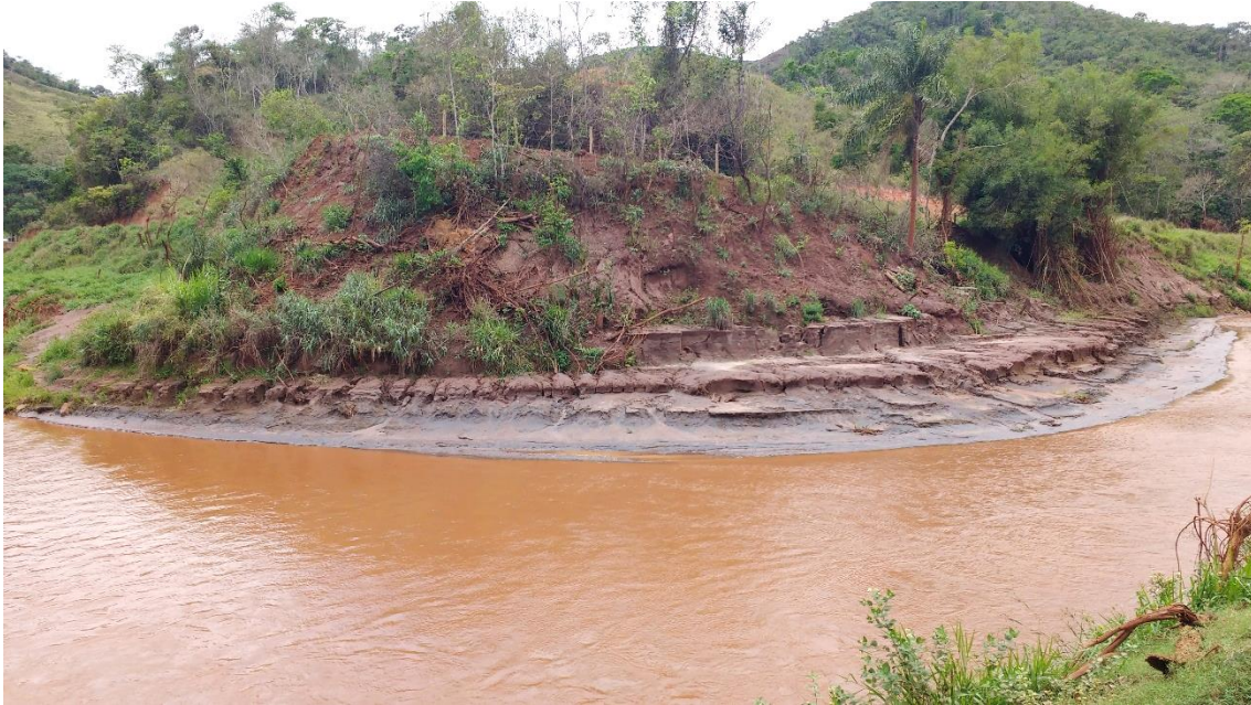
Figura 12: Vista de margem do TR08-310 com erosão do talude formado pelos rejeitos.
