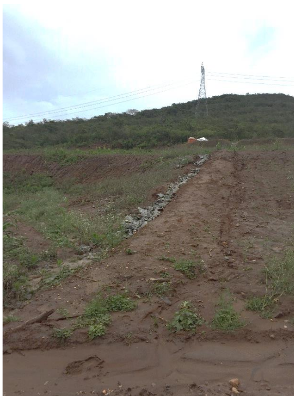
Foto 12: Canaleta de drenagem no limite do talude marginal do tributário.
