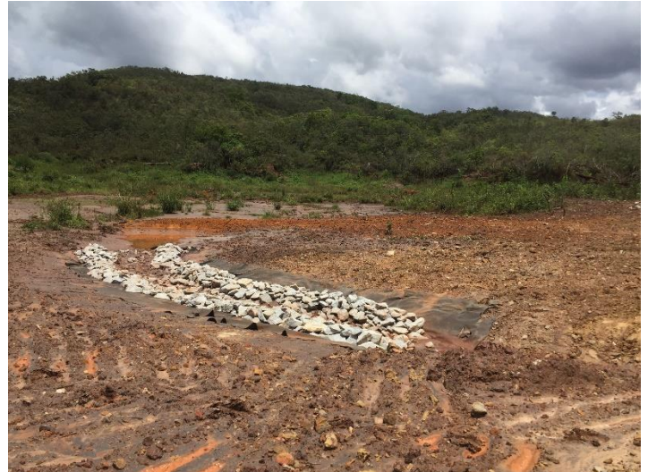
Foto 5. A: Saída da tubulação para drenar e direcionar as águas do tributário não identificado (coordenada 664756.22 / 7758812.91). Foto 5. B: Tributário não identificado (coordenada 664756.22 / 7758812.91) com margens reconformadas, implantação de biomanta e enrocamento.
