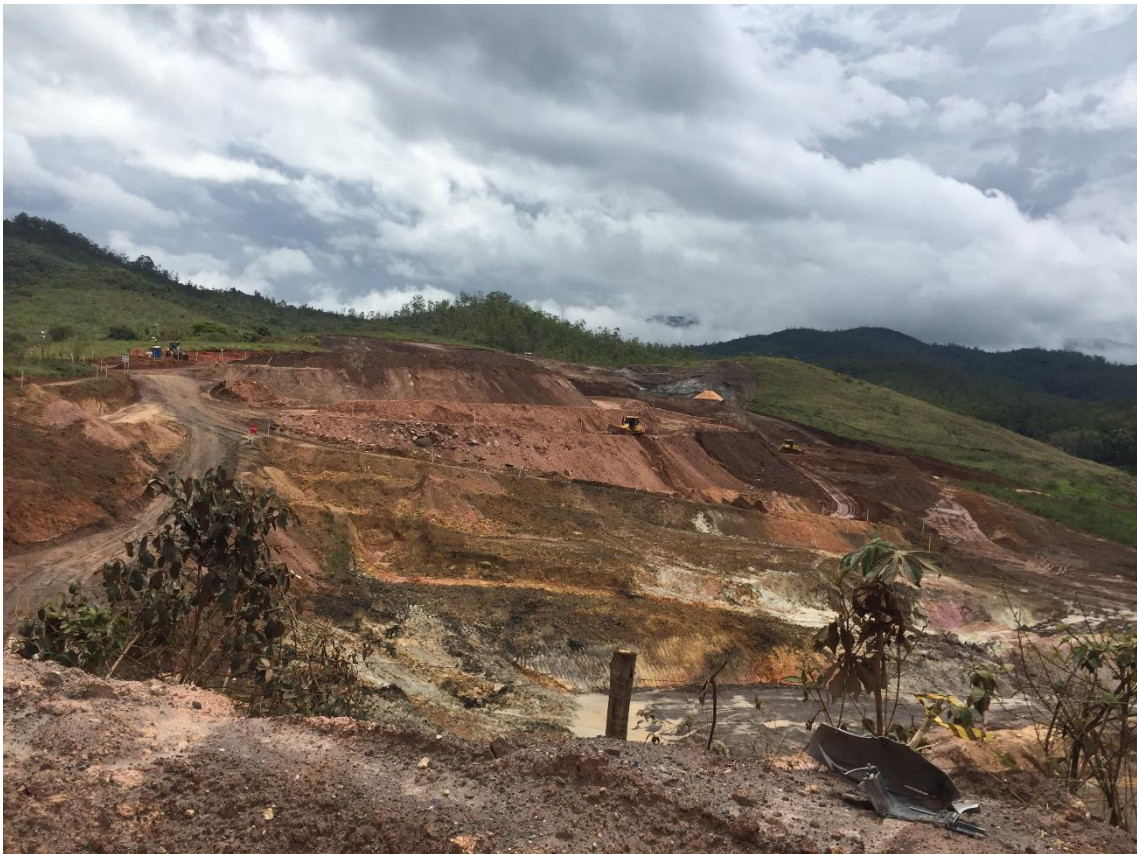
Foto 7: Pilha de rejeito próxima ao ponto TR02-03.
