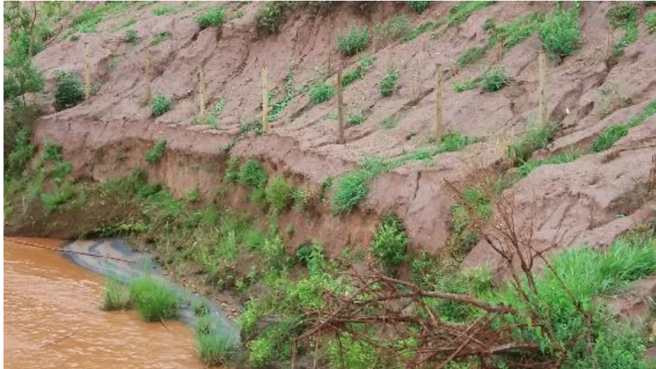
Figura 12: Detalhe da Margem direita - Quarto Ponto na área 9 – Jusante.
