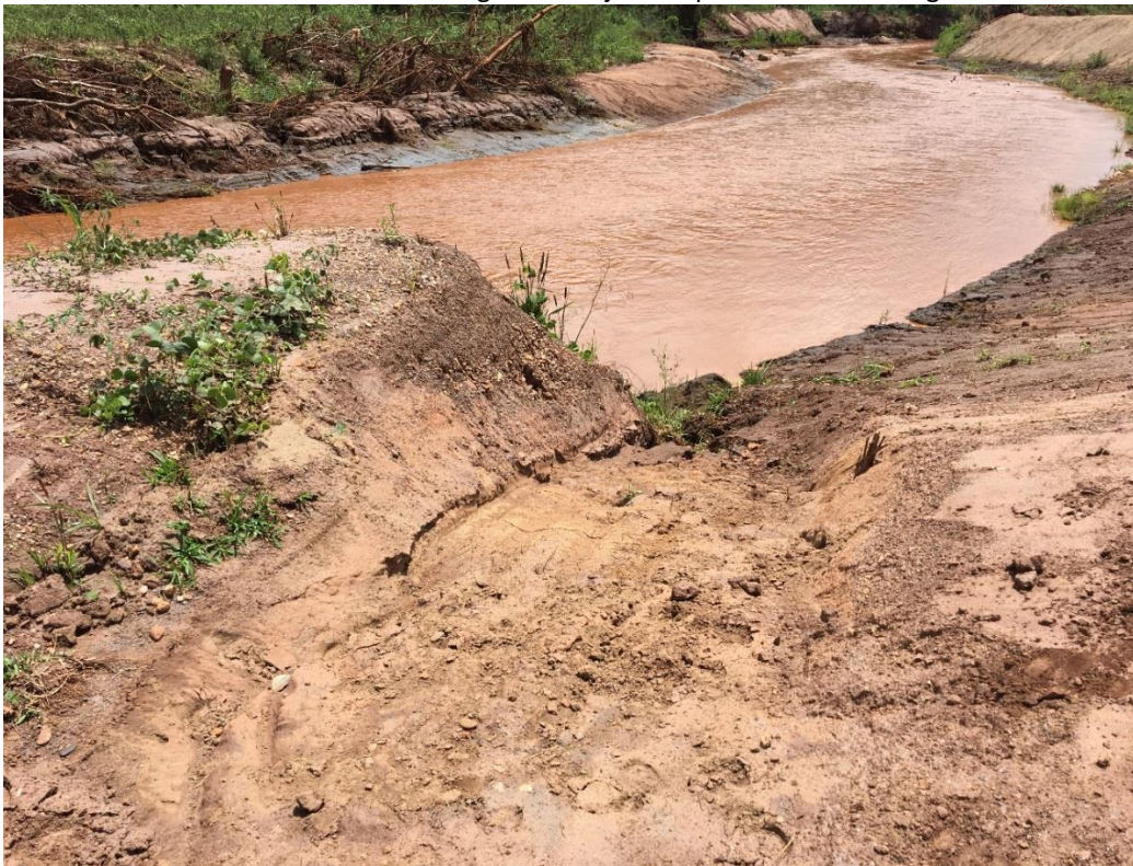
Foto 12: Ponto 03_TR 09. Vista de local com potencial instalação de processo erosivo e carreamento de sedimentos para o curso d'água.
