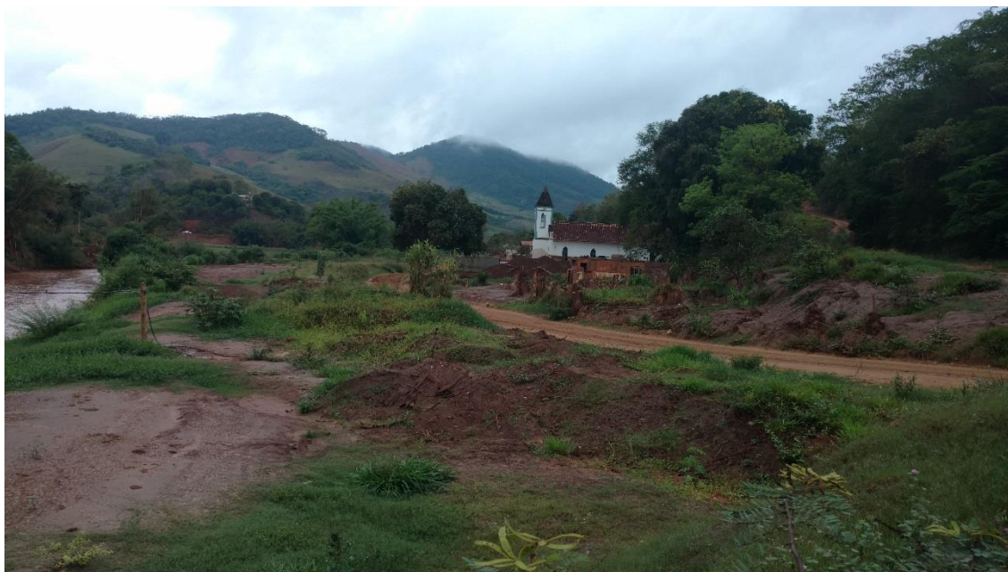
Figura 5: Estruturas remanescentes com acúmulo de rejeitos.
