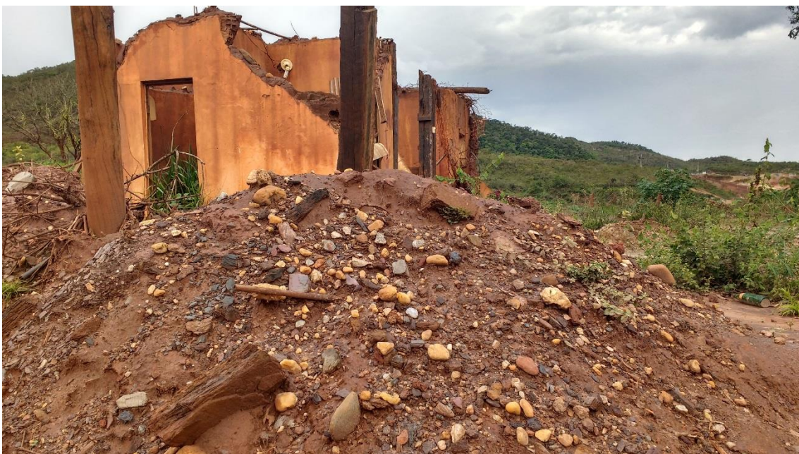
Figura 5: Estruturas remanescentes e acúmulo de sedimentos.
