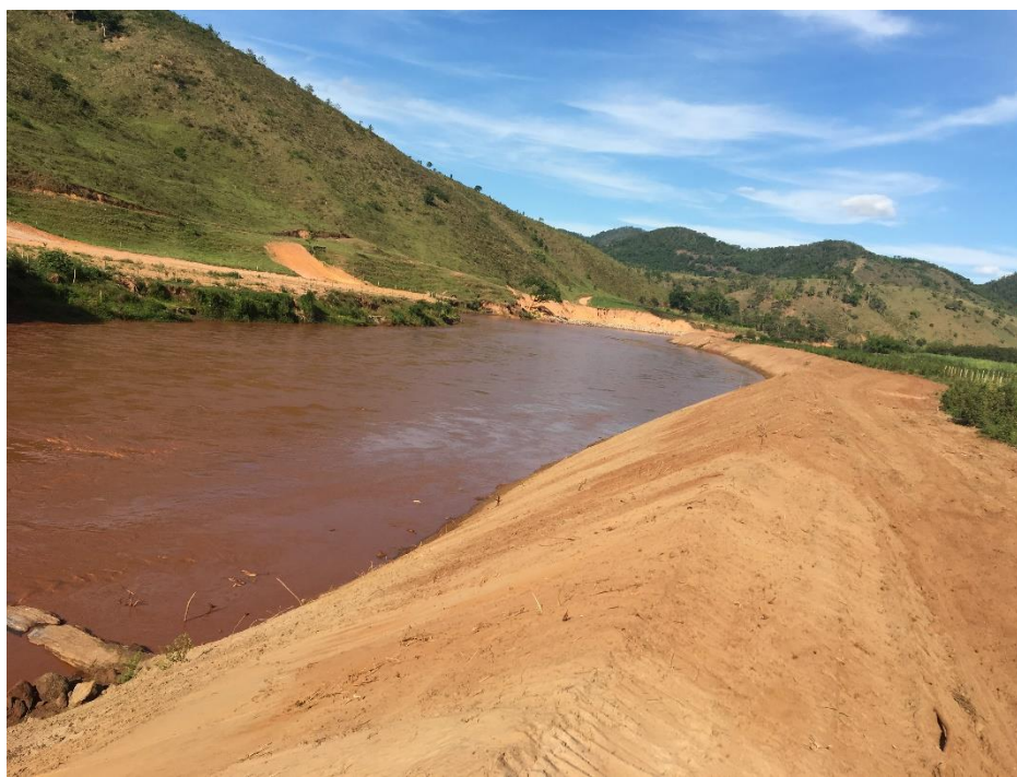
Foto 28: Ponto 12 _TR 15. Vista geral do talude reconformado.
