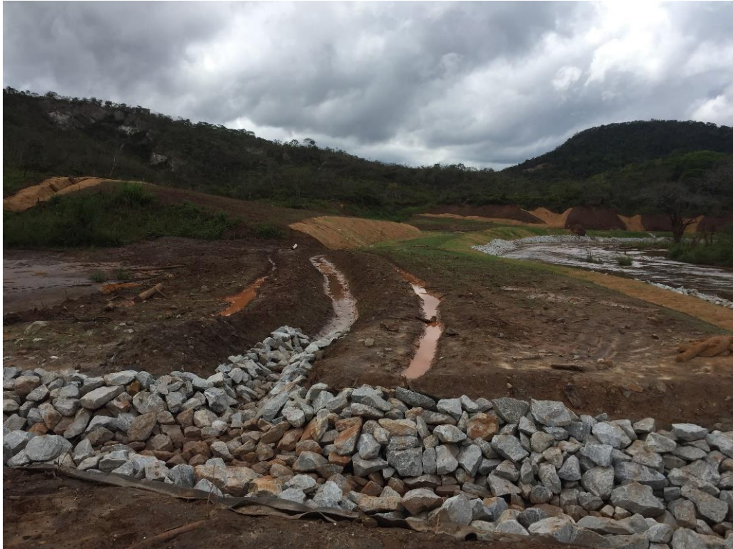
Foto 2: Obras na margem esquerda para instalação de geotêxtil e enrocamento, seguidos de biomanta e revegetação com mix de sementes.
