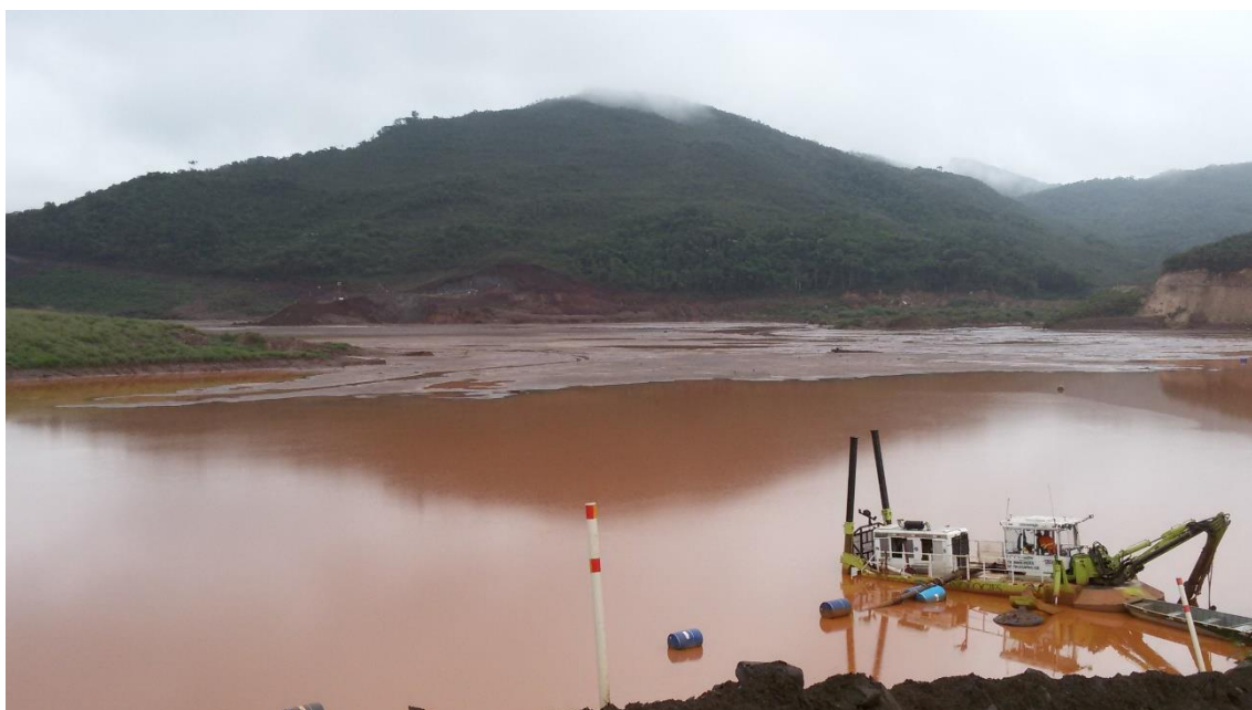
Foto 2: Dragagem experimental do material contido pelo dique S3.
