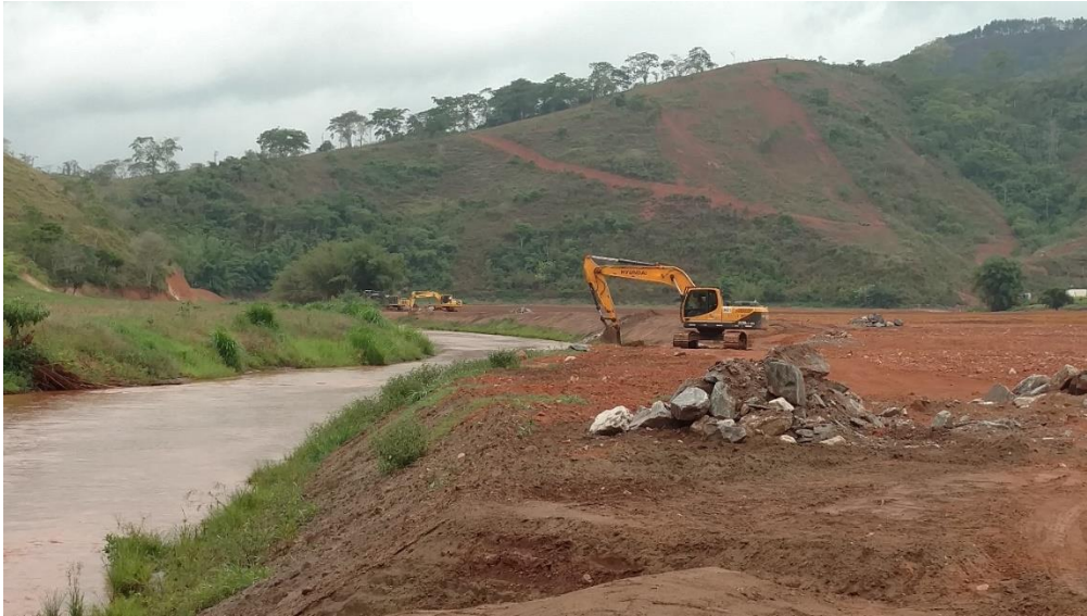
Figura 3: Retaludamento na planície de inundação
