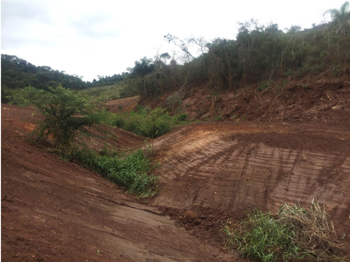
Foto 11: Margem esquerda do canal de drenagem pluvial na qual será feita a limpeza dos galhos mortos manualmente sem destoca.
