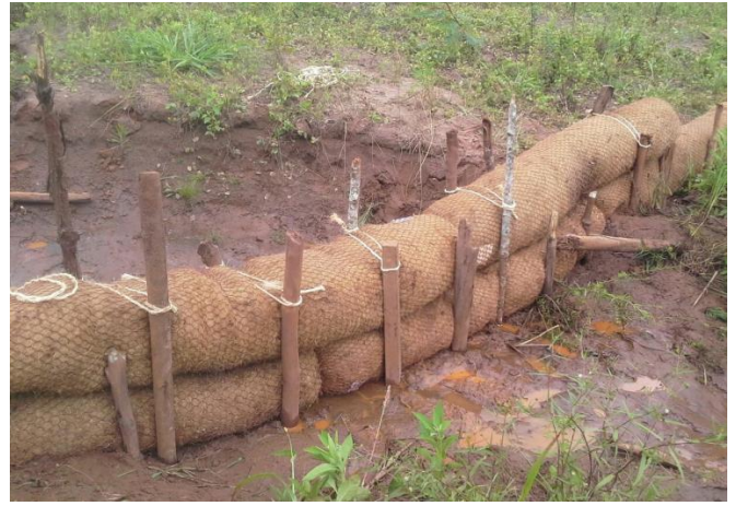
Foto 1. A e B: Retentores de sedimentos já instalados.
