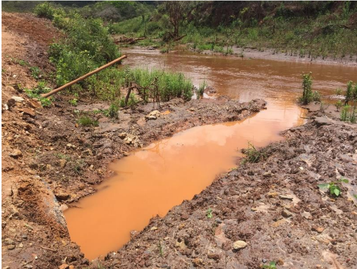
Foto 5. A: Saída da tubulação para drenar e direcionar as águas do tributário não identificado (coordenada 664756.22 / 7758812.91). Foto 5. B: Tributário não identificado (coordenada 664756.22 / 7758812.91) com margens reconformadas, implantação de biomanta e enrocamento.
