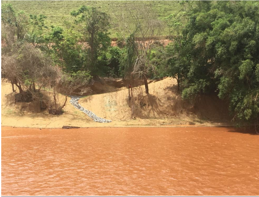
Foto 17: nas imediações do Ponto 08 _TR 15. Vista frontal do sistema de drenagem pluvial executado nesse trecho.
