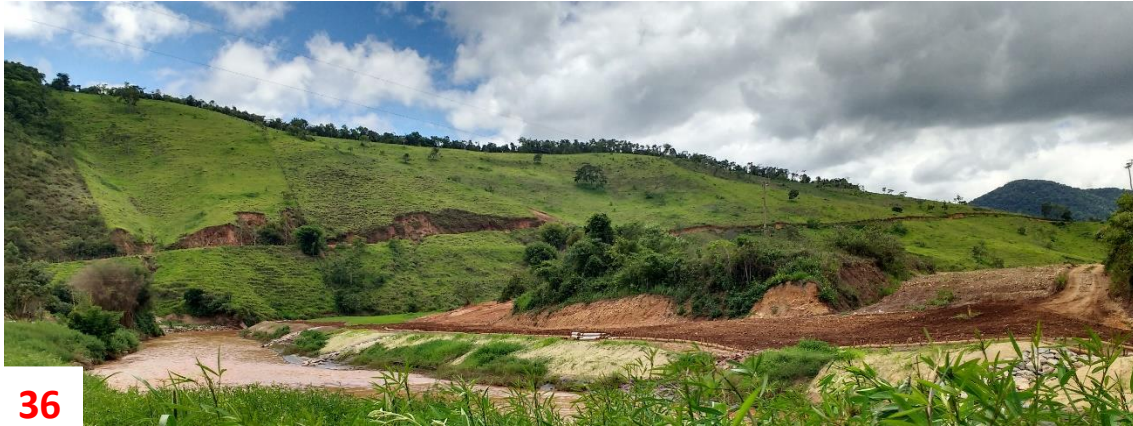
36 Figura 36: Taludes com geotêxtil, bermas para contenção de sedimento e canais de drenagem com enrocamento.
