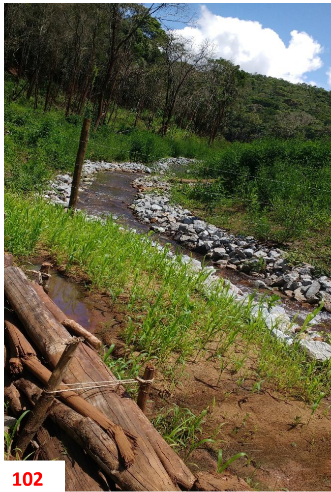
Figura 102: Enrocamento, paliçada e biomanta com sementeira.
