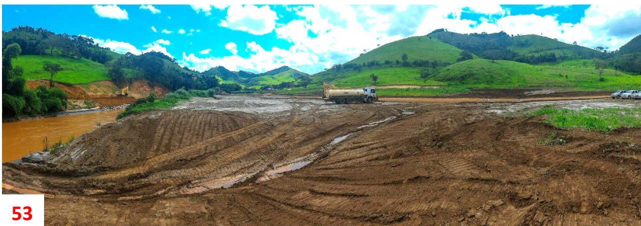
Figura 53: Área de planície onde estão sendo realizadas intervenções. Observa-se à esquerda intervenção nos taludes da margem e à direita parte da vegetação do mix de sementes plantados pela Samarco removidos para plantio de braquiária.
