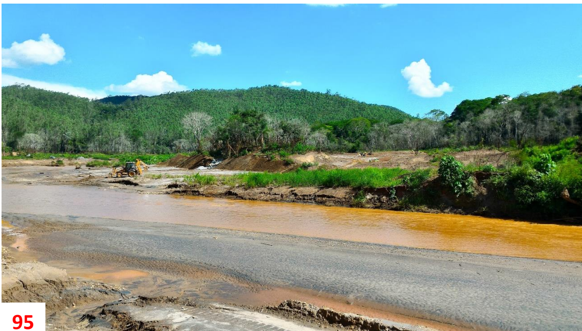
Figura 95: Reconformação da ilha com direcionamento de drenagem do entorno.
