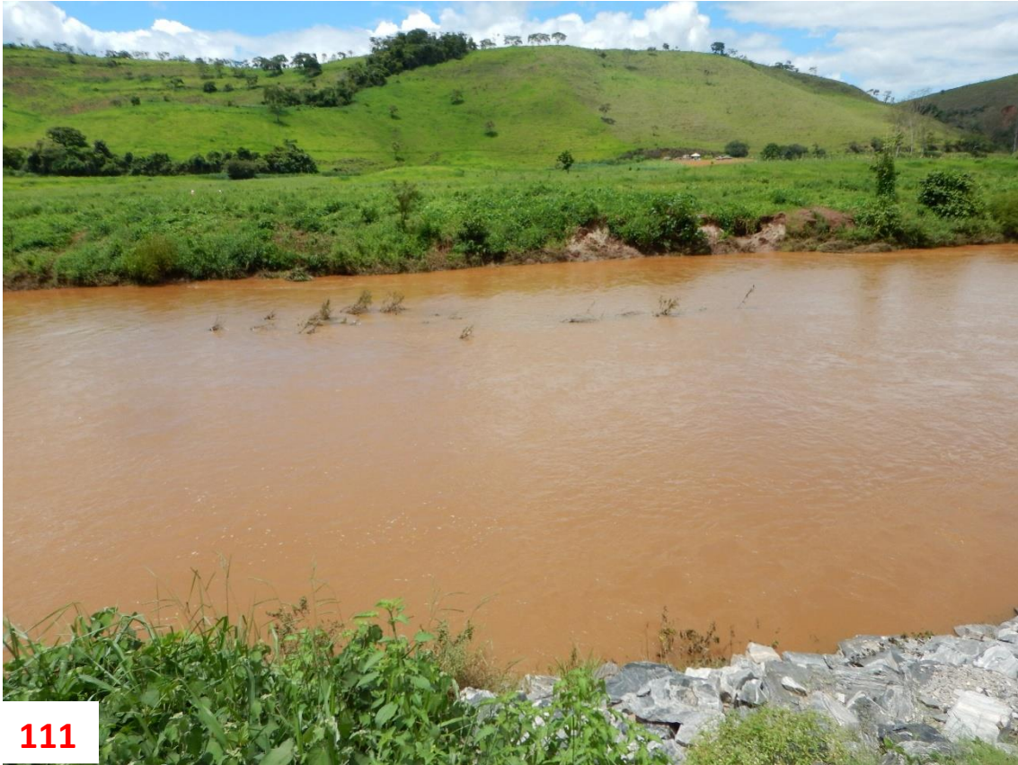
Figura 111 – Trecho da margem esquerda (ao alto) demonstrando pequeno incremento em cobertura vegetal em relação ao avaliado na fase I da operação, mas ainda apresentando solo exposto e sinais de erosão dos tipos laminar e ravinamento. Na margem direita, abaixo, pequeno enrocamento realizado emergencialmente ainda anteriormente a fase I.
