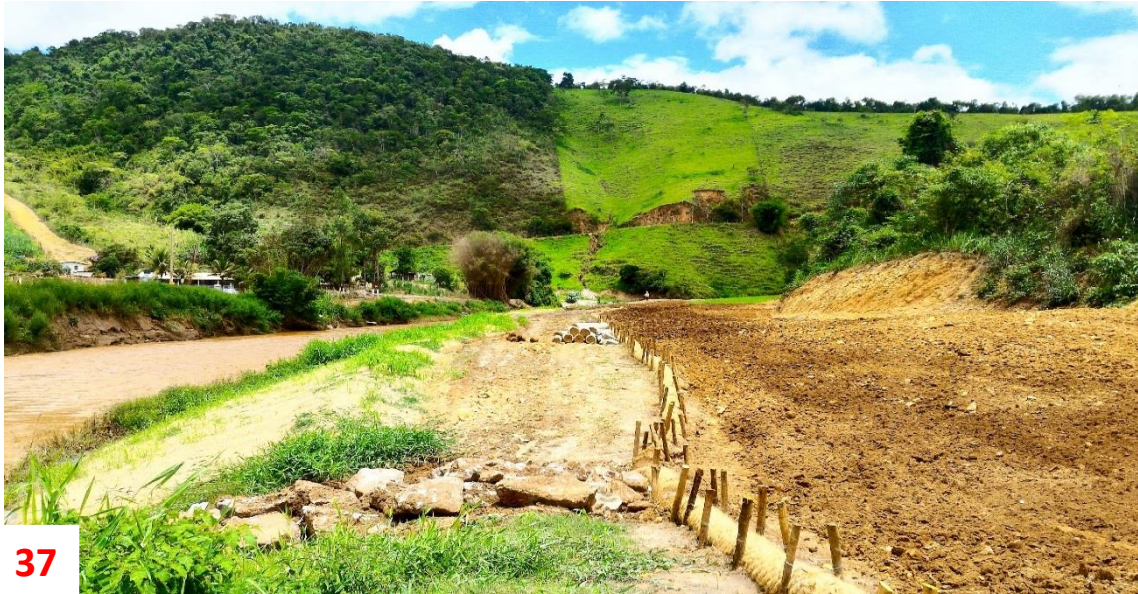
Figura 37: Visão geral da área 400. Podem-se observar os taludes com a biomanta e revegetação, canais de drenagem, e aplicação de biorrols para controle de erosão e sedimentos. Na margem esquerda observa-se talude instável.
