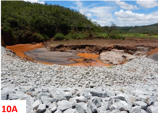
Figuras 10A e 10B: reconfiguração dos taludes do entorno da ilha.
