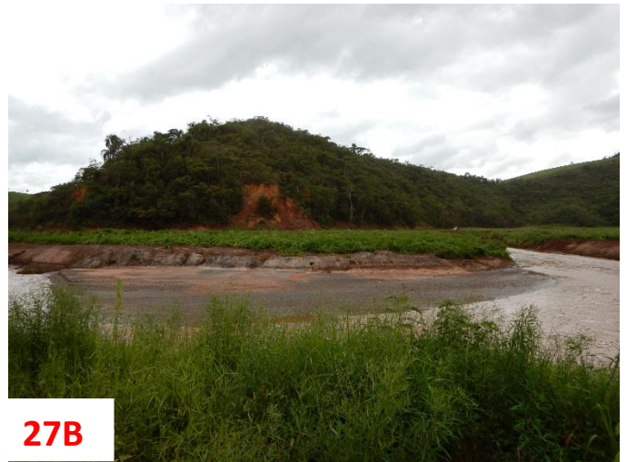
Figuras 27A e 27B: Taludes marginais erodidos sobre a praia de rejeito.
