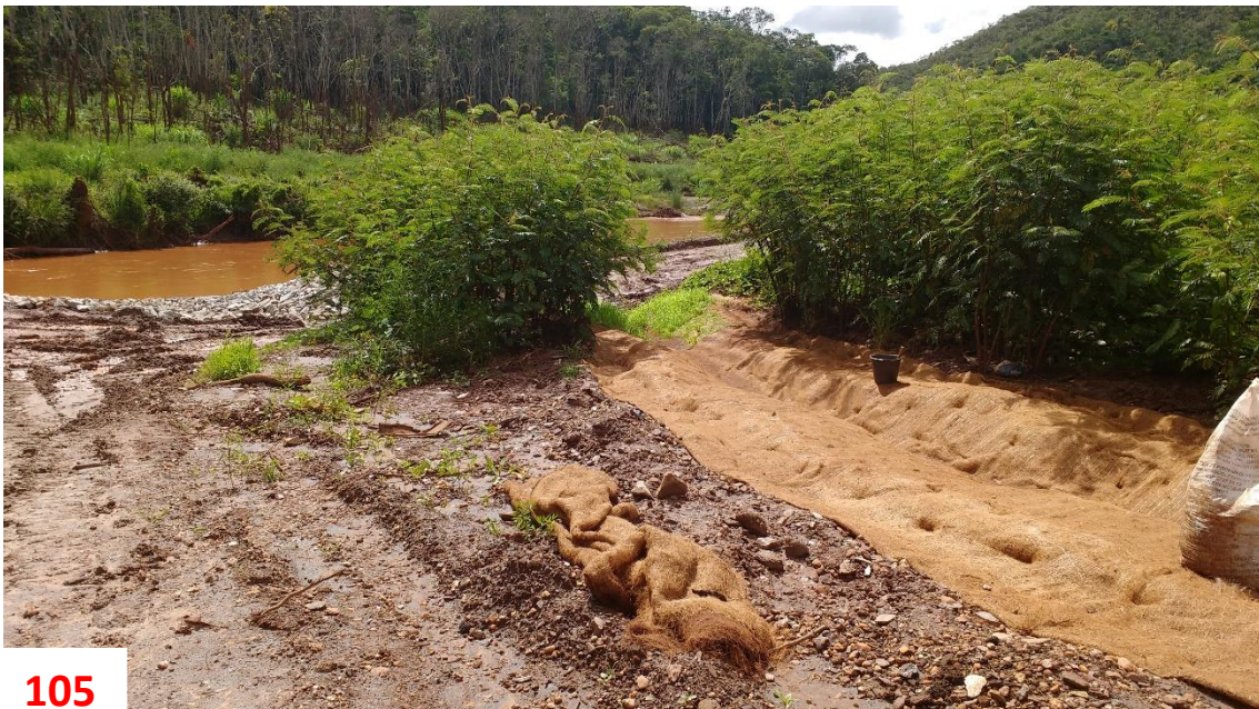
Figura 105: Aplicação de bioengenharia nos canais de drenagem.
