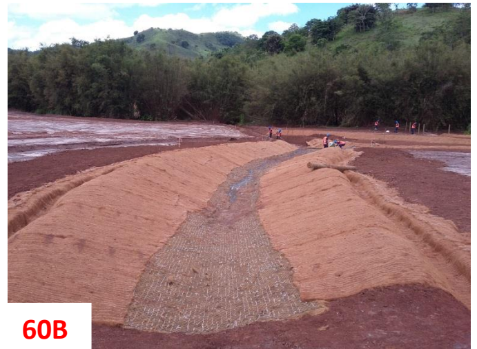
Figuras 60A e 60B: Canaletas de drenagem instalada em área brejosa.
