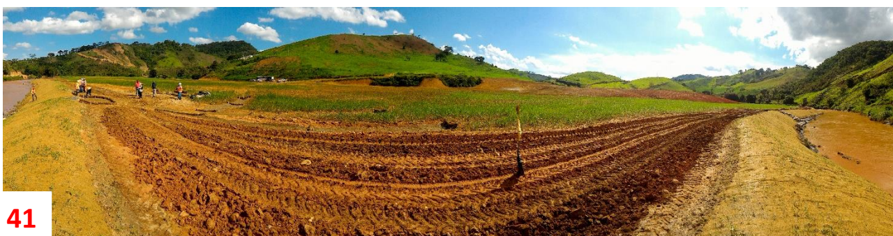
Figura 41: Taludes da margem direita reconformados e com biomanta aplicada. Observam-se marcas de maquinário que estava realizando o arado e plantio de braquiária bem próximo às margens com interferência nas ações de recuperação. Ao fundo braquiária já crescida.
