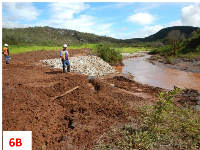
Figuras 6A e 6B: Trabalhos de manutenção do sistema de drenagem.
