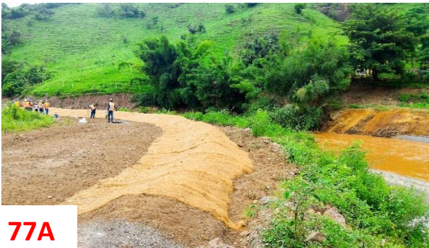
Figura 77A e 77B: Vista dos taludes e planície de inundação da área TR09-481 com obras de drenagem e implantação de biomanta.
