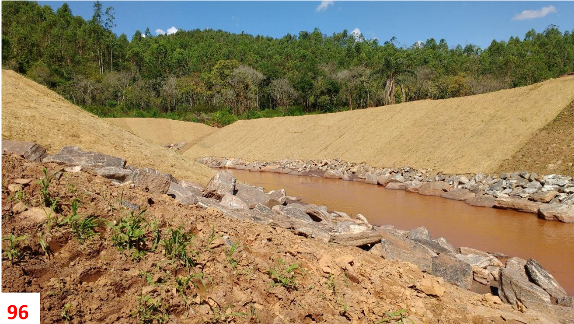
Figura 96: Intervenções realizadas no tributário TG16
