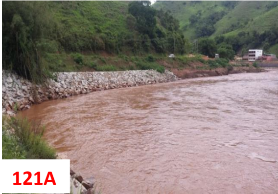
Figuras 121A e 121B: Margens da curva do Rio do Carmo evidenciando danos nos taludes e nova construção ao fundo (edifício branco) na figura 121A.
