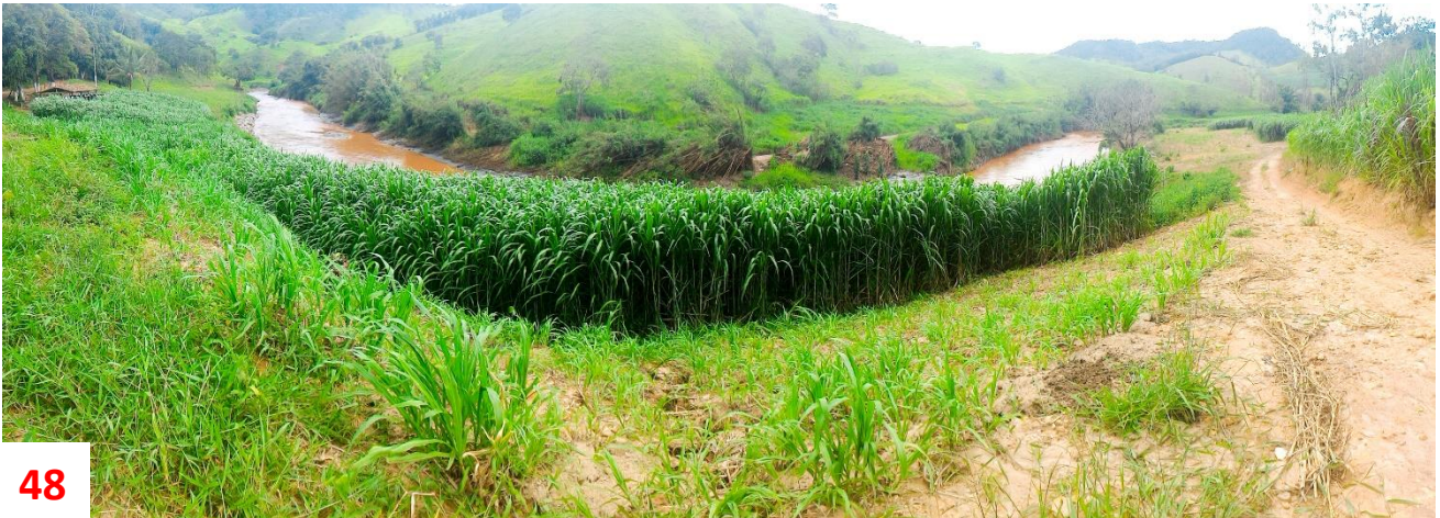
Figura 48: Vista geral da área 405, 406. Observa-se que as margens estão protegidas por vegetação natural e plantada. Há setores com enrocamento colocado na fase emergencial.
