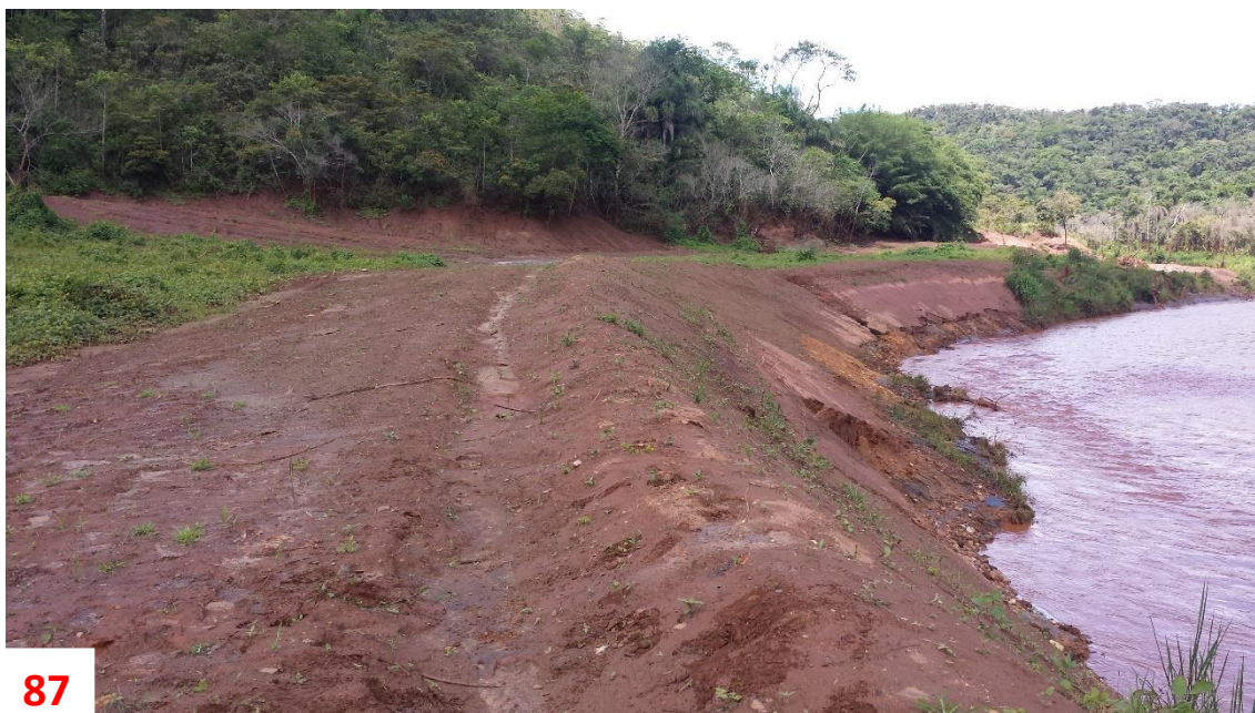
Figura 87: Obras de regularização do terreno, drenagem e contenção executadas parcialmente, estando retaludadas as margens do rio e conformadas ombreiras e canaletas sobre o rejeito depositado na planície. Solapamentos observados em alguns pontos dos taludes.
