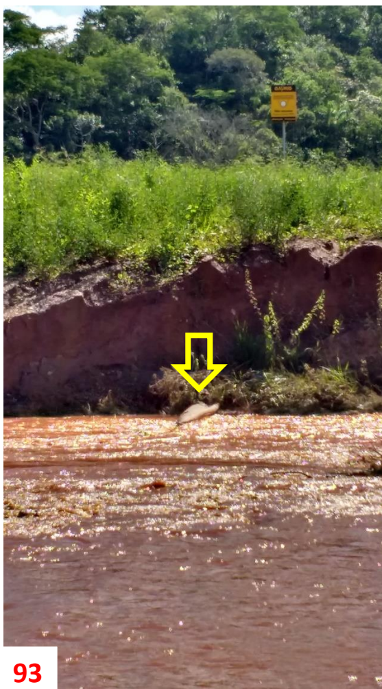
Figura 93: Tubulação de gás natural visível na margem direita.
