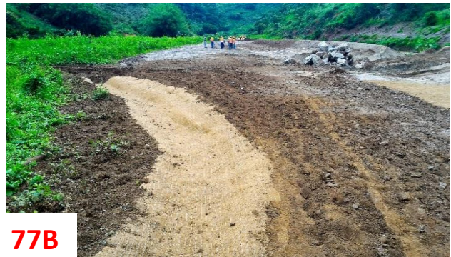
Figura 77A e 77B: Vista dos taludes e planície de inundação da área TR09-481 com obras de drenagem e implantação de biomanta.
