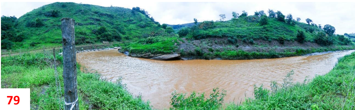
Figura 79: Panorâmica do ponto TR09-482. Observa-se talude com solo exposto e ravinamento na margem direita e enrocamento na margem esquerda.
