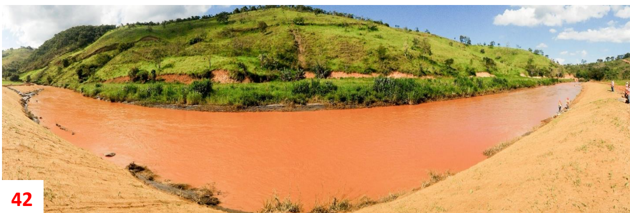
Figura 42: Taludes da margem esquerda com vegetação.
