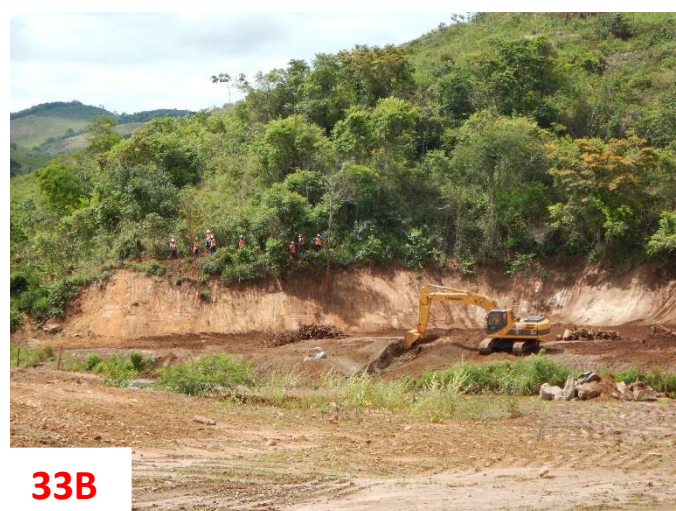
Figuras 33A e 33B : Trabalhos de reconformação dos taludes.
