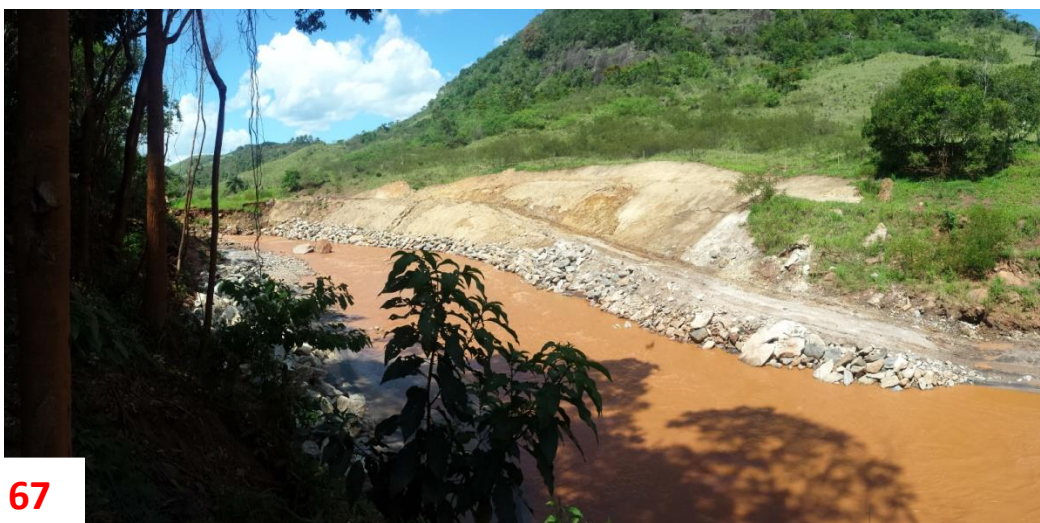
Figura 67: Retaludamento da margem do Rio Gualaxo
