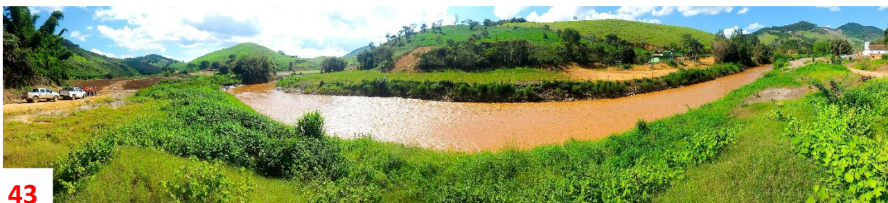
Figura 43: Setor com taludes da margem direita e esquerda que tiveram intervenção emergencial. Observa-se vegetação tem bom crescimento, contudo em alguns pontos ainda é necessária intervenção.
