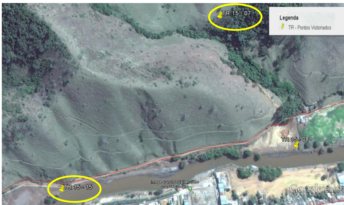
Figura 118: Visualização do Ponto TR 15-07 fora da área de intervenção do Projeto e o ponto TR15 – 15 utilizado em substituição na vistoria. Imagem do Google Earth.
