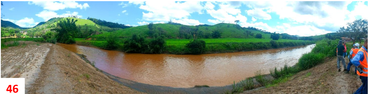
Figura 46: Visão geral da margem esquerda. Observa-se planície de inundação com plantio de braquiária e vegetação dos taludes bem desenvolvida. No primeiro plano talude da margem direita retaludado e ainda sem vegetação.
