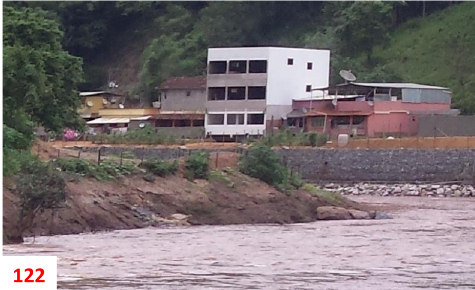
Figura 122: Trecho da curva com edifício sendo construído acima do muro de gabião.
