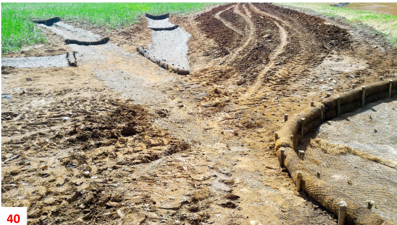
Figura 40: Trabalho de drenagem sendo realizado. Observam-se marcas do maquinário em cima da drenagem realizada.
