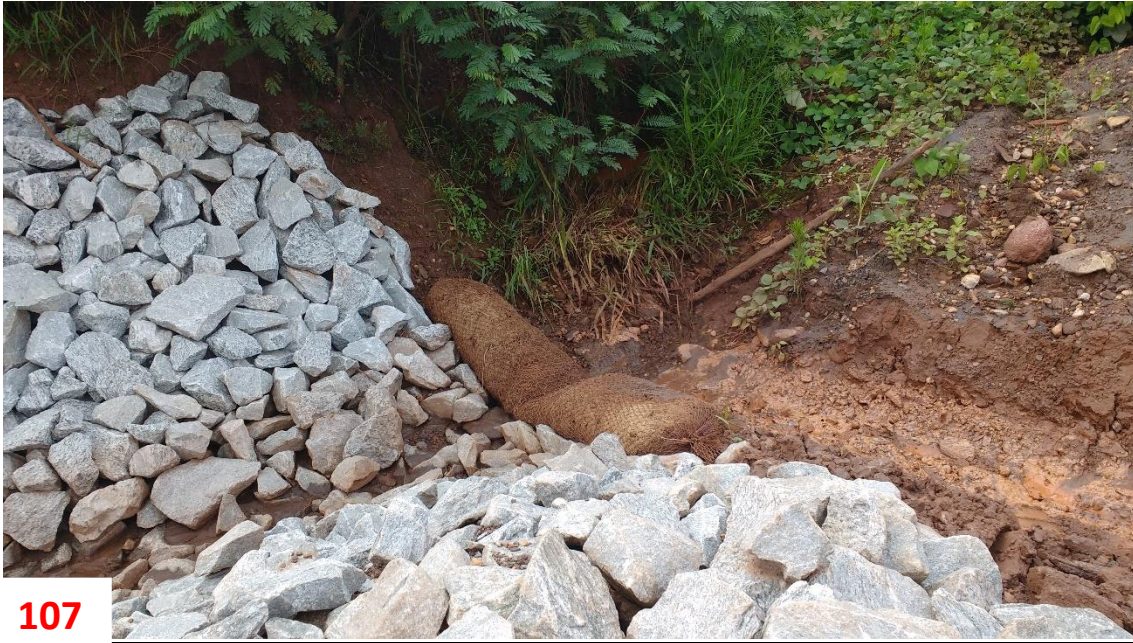
Figura 107: Medidas de contenção de sedimentos de um novo tributário.
