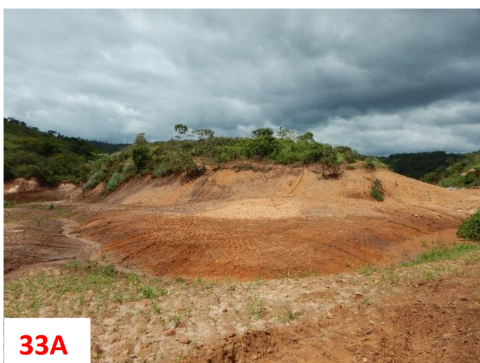
Figuras 33A e 33B : Trabalhos de reconformação dos taludes.
