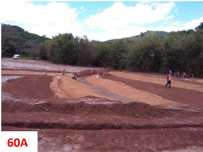
Figuras 60A e 60B: Canaletas de drenagem instalada em área brejosa.
