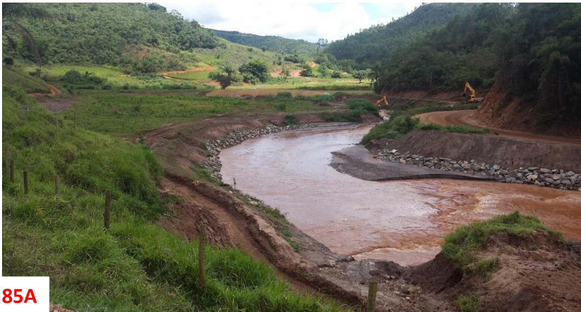
Figura 85A: Frente de trabalho nas duas margens do rio
