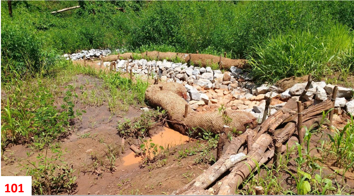
Figura 101: Enrocamento, paliçada e retentores de sedimentos em tributário.
