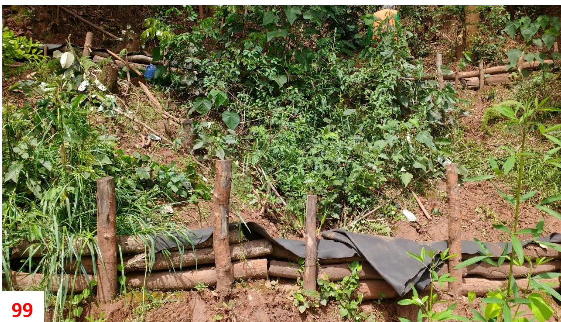
Figura 99: Paliçadas e geotexteis para contenção.
