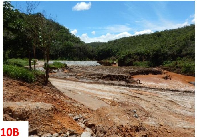
Figuras 10A e 10B: reconfiguração dos taludes do entorno da ilha.
