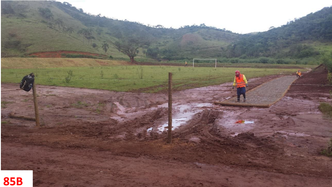
Figura 85B: Reconformação das linhas de drenagem, com aplicação de biomanta.
