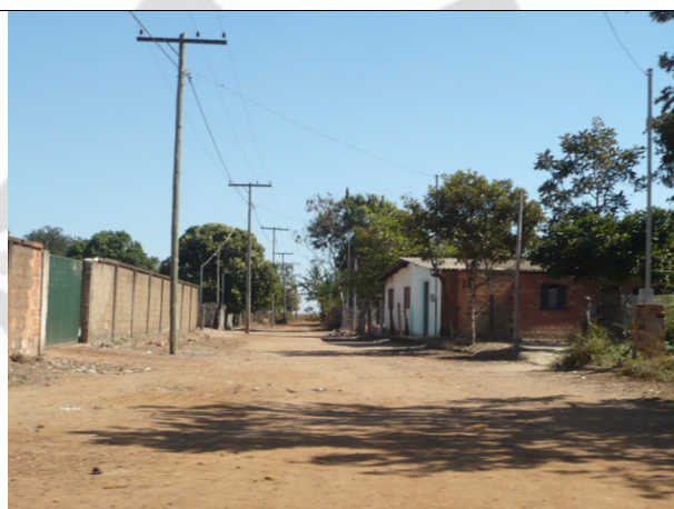
Foto 04: Rua principal da comunidade de Lagoa do Meio.
