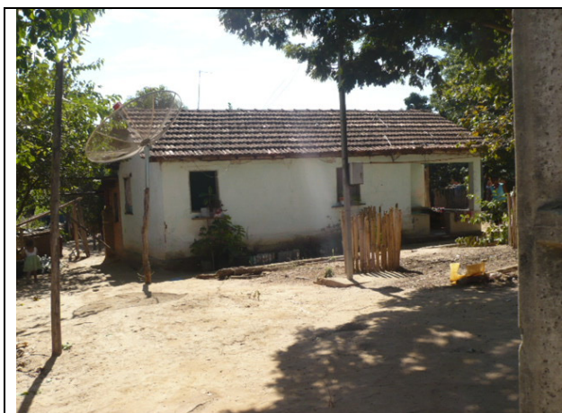
Foto 01: Exemplo das estruturas das casas identificadas na comunidade do Tronco
