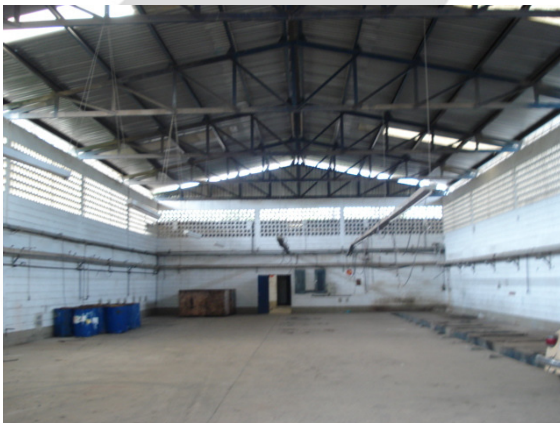
Foto 01: Vista interna do galpão no qual será implantado o empreendimento
