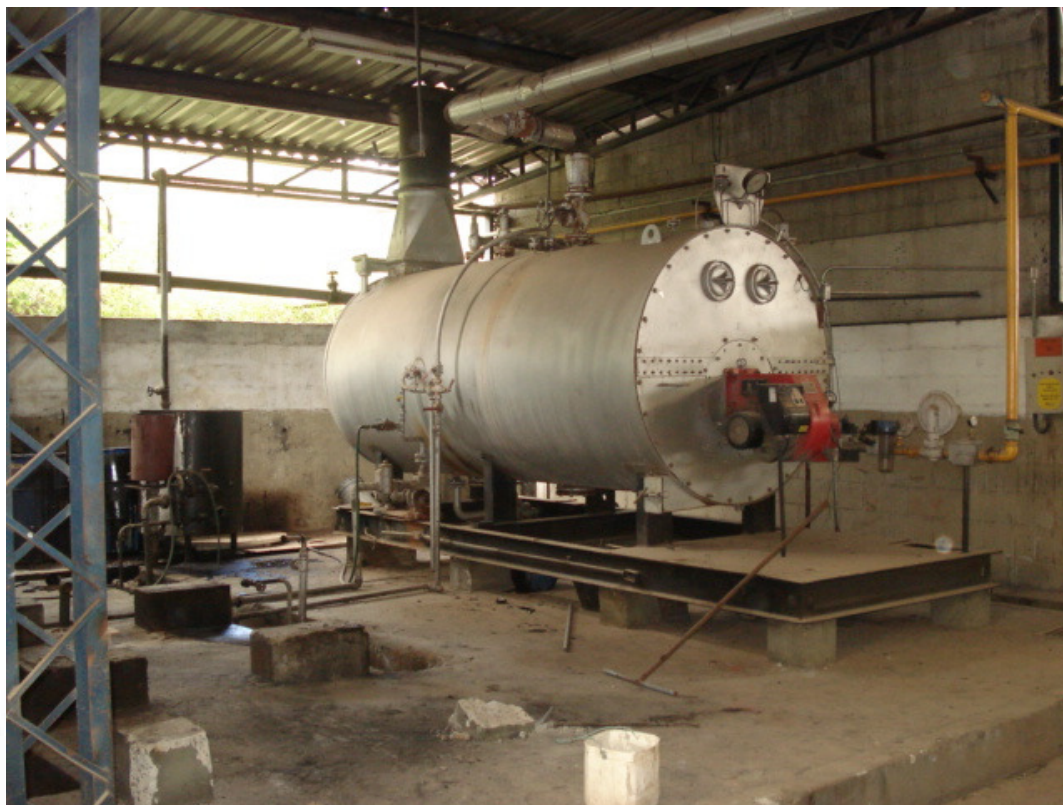
Foto 02: Tanque antigamente utilizado na lavanderia industrial (atualmente desativado)
