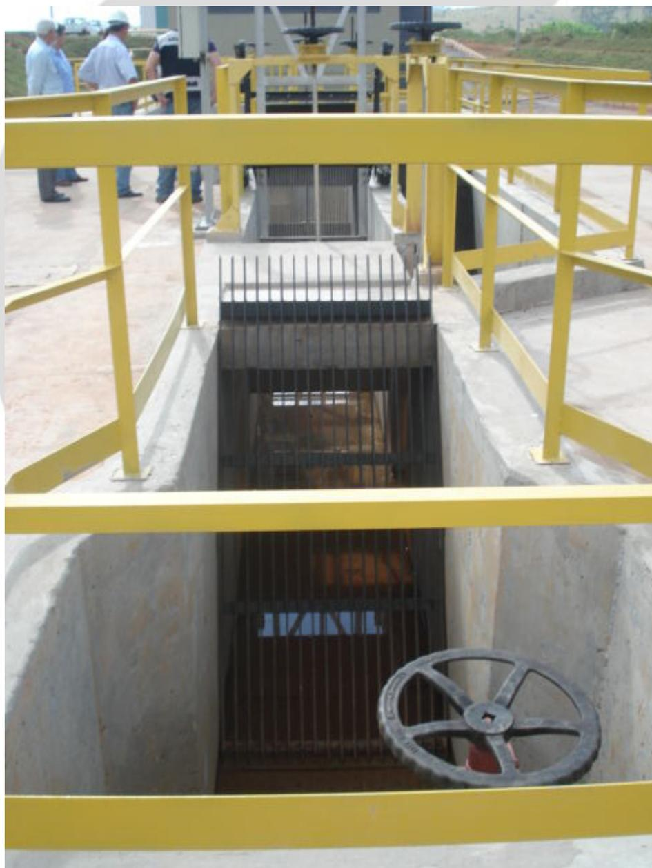
Foto 01: Vista de montante do gradeamento do tratamento preliminar
