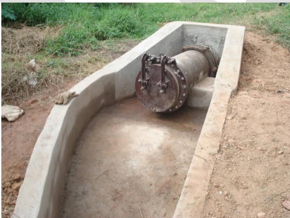
**Foto 07: Válvula de lançamento de efluentes tratados**
