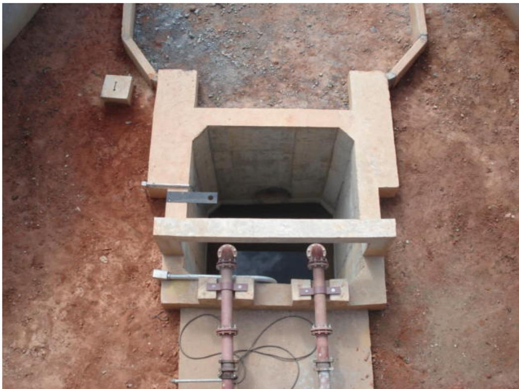
**Foto 04: Estação elevatória de recirculação**
