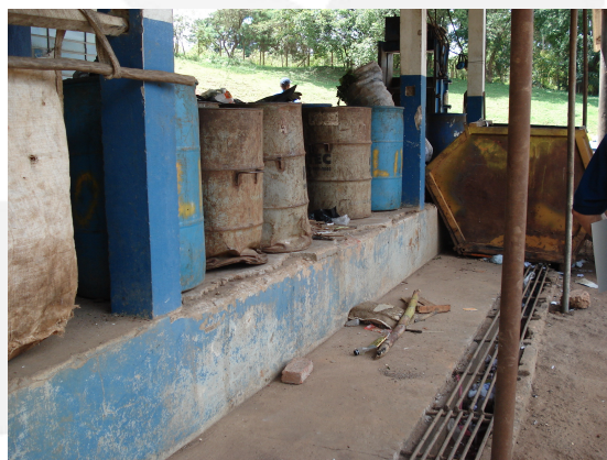
Foto 4 - Galpão de triagem e canaleta de drenagem.
