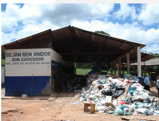
Foto 1 - Galpão de recepção de resíduos.
