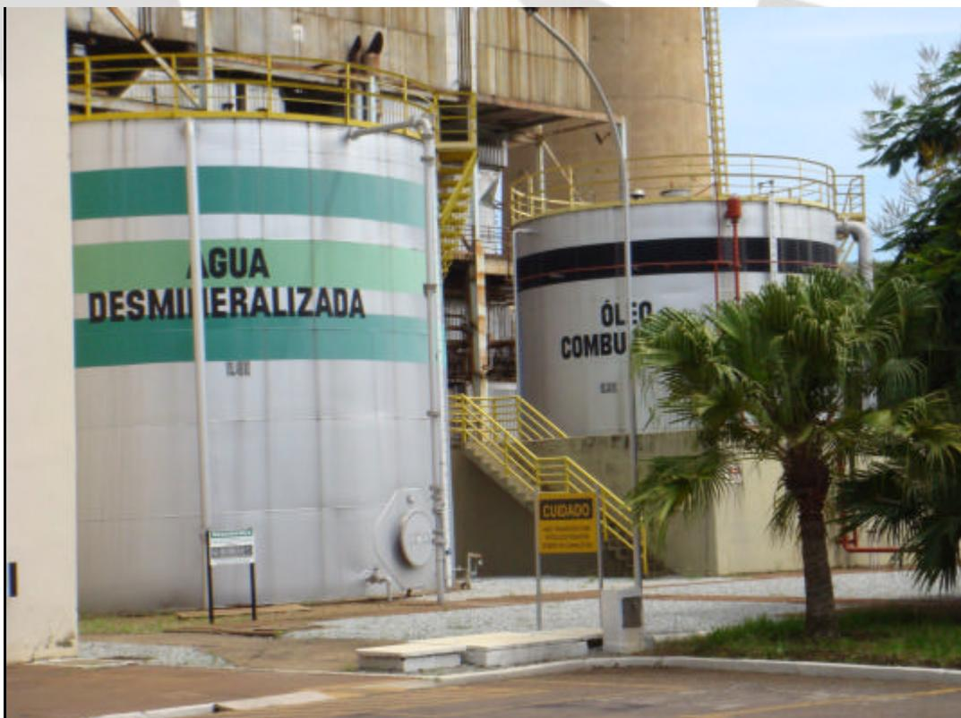
Foto 03: Tanques de armazenamento de água desmineralizada e de óleo combustível utilizados no processo de geração de energia
