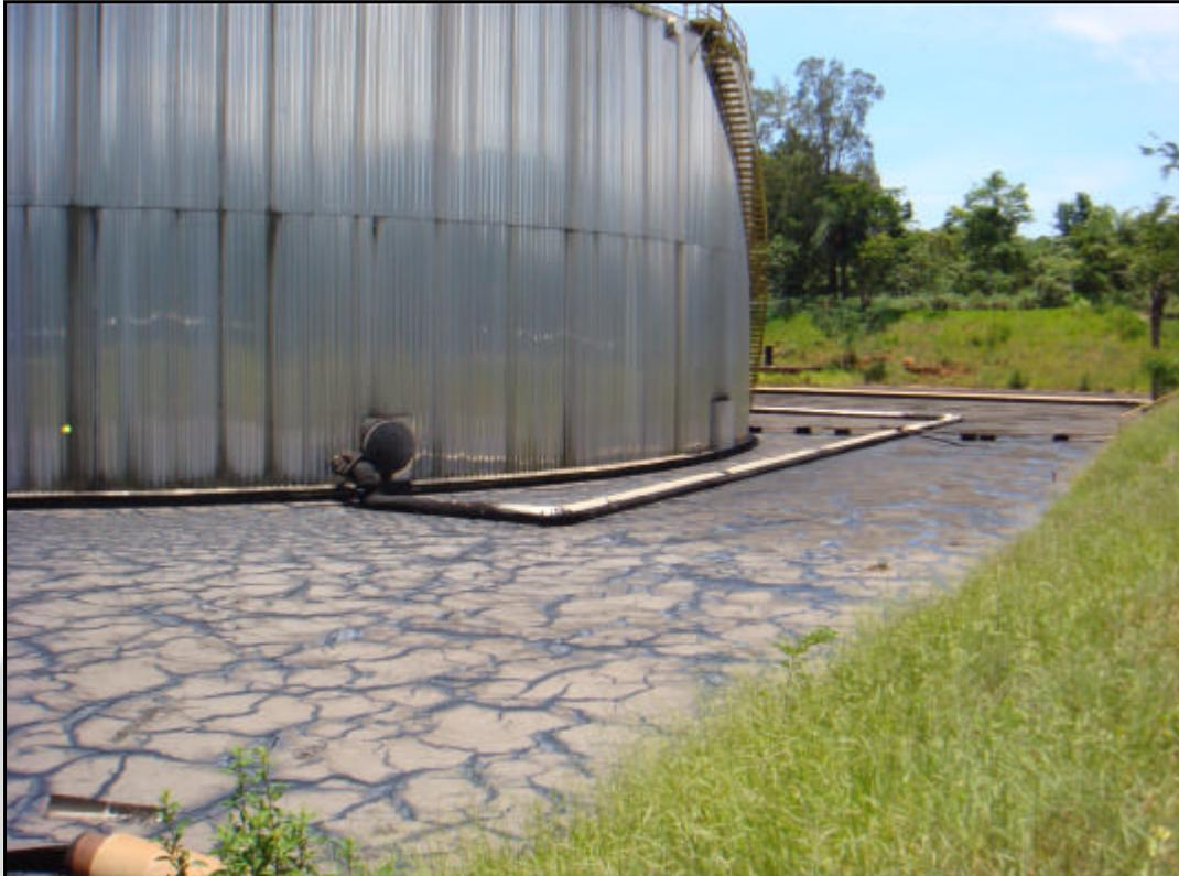
**Foto 08: Área impactada pelo derramamento de óleo no interior da bacia de contenção dos tanques de armazenamento**
