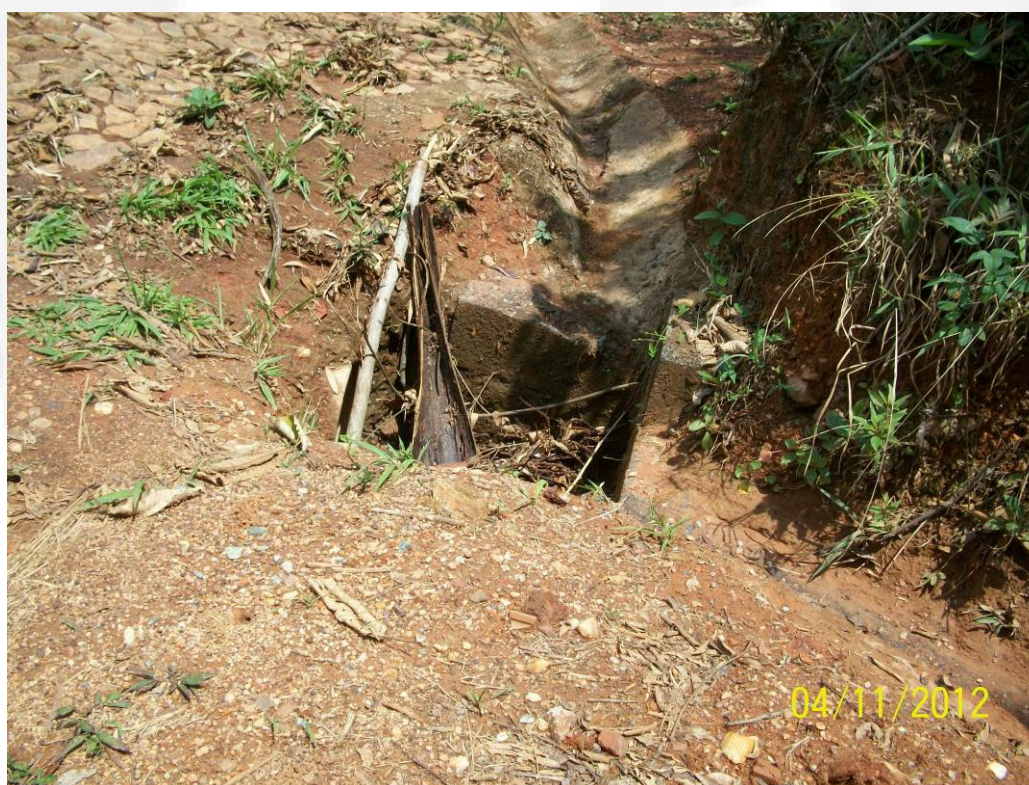
Foto 15, 16, 17: Canaleta de concreto pré-moldado meia-cana e caixa de concreto de águas pluviais
