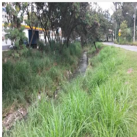
Foto 01. Trecho a ser canalizado
