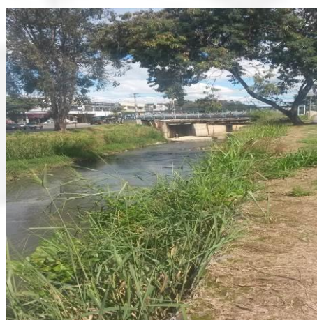
Foto 04. Trecho a ser canalizado
