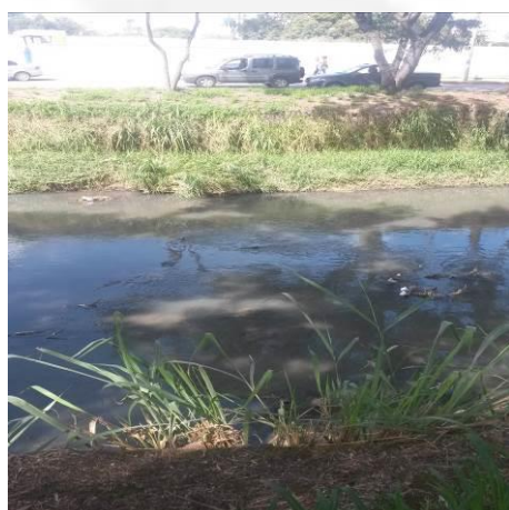
Foto 03. Trecho a ser canalizado
