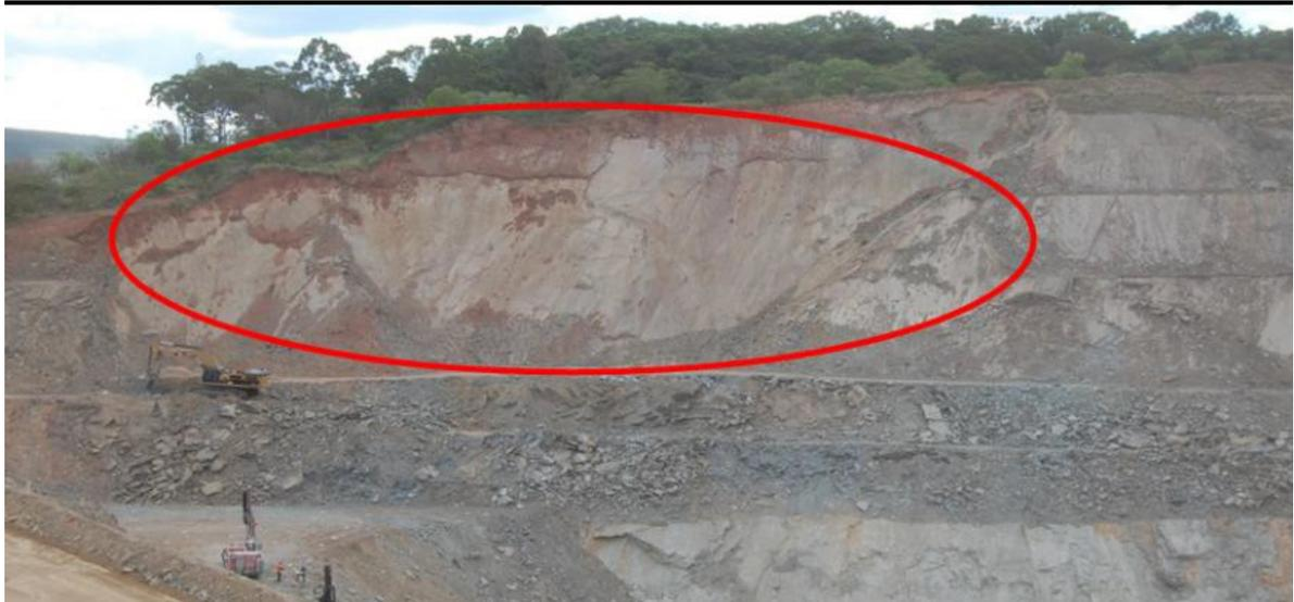
Figura 1: Colapso de talude na porção oeste da cava
