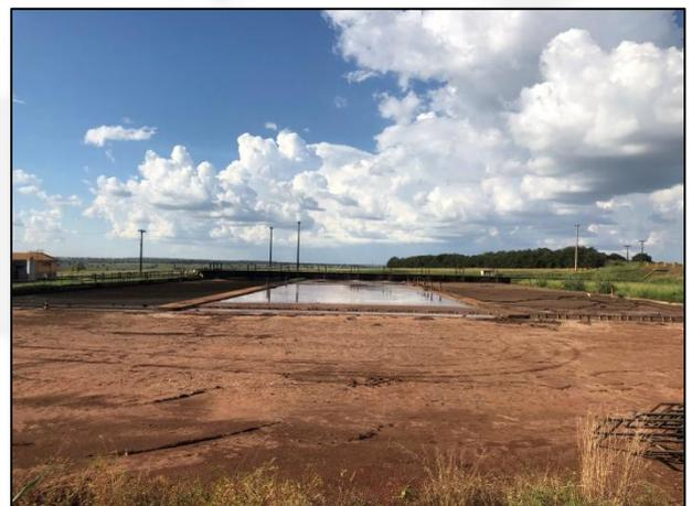
**Figura 10:** Tanques de sedimentação – águas residuárias
