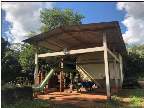
**Figura 7:** Casa de bombas - Captação de água superficial
