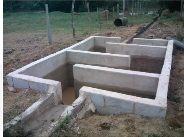
Foto 02. Caixa de decantação e tubulação de retorno da água residuária.
