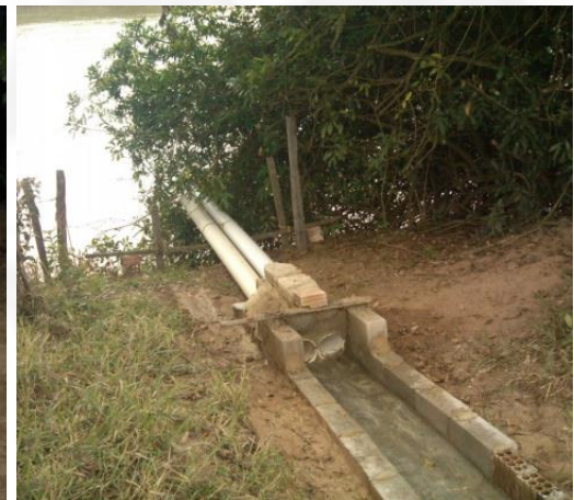
Foto 02. Caixa de decantação e tubulação de retorno da água residuária.
