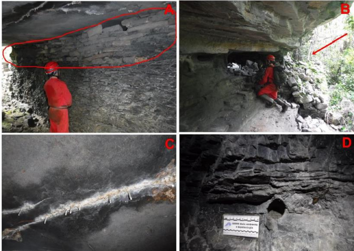
Figura 254: (A) Circulado de vermelho o muro de pedra visto por dentro da galeria. (B) Vista da cavidade natural subterrânea com seta indicando entrada da galeria. (C) Deposição química do tipo canudo de fresco com pequenas dimensões no interior da galeria. (D) Perfuração em interior de galeria feita durante atividade de extração de salitre.
