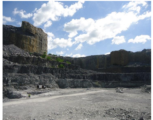
Figura 2. Vista da cava
