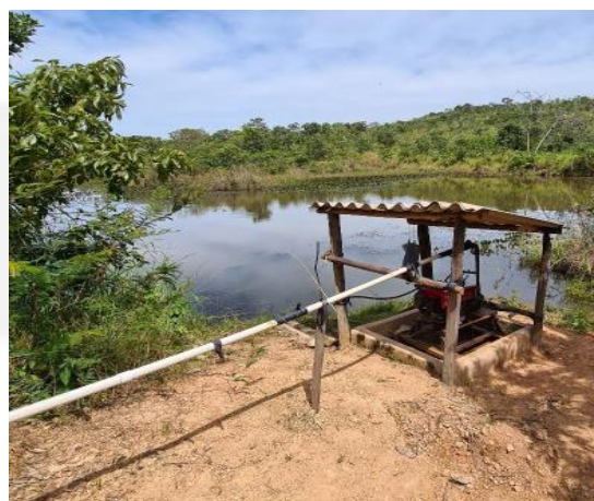
Foto 02: Ponto de Captação
