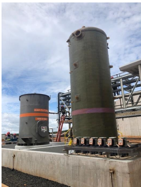
Figura 2-2 -Bacia de contenção e sistema pipe rack
