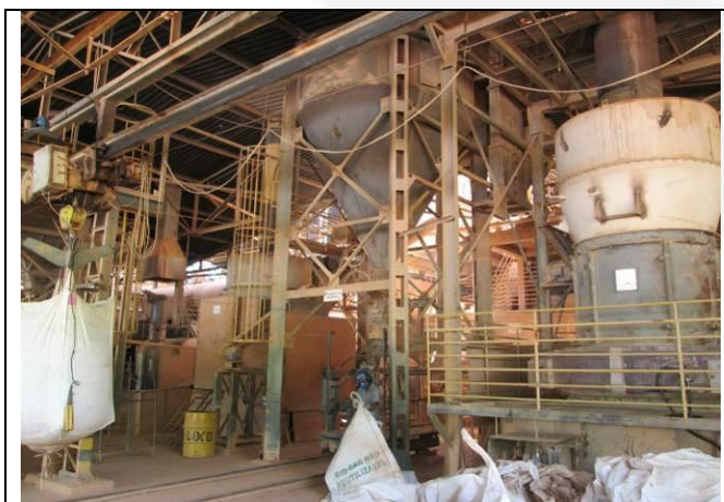
Foto 13: Moinho de bauxita e sistema de transporte dos big bags
