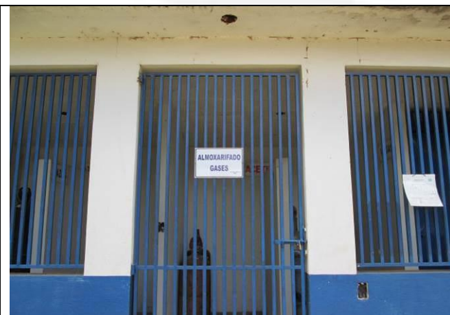
Foto 7: Depósito de oxigênio e acetileno
