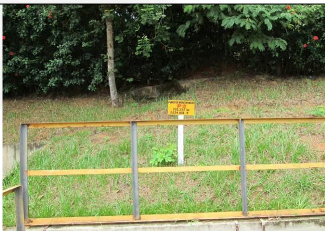
Foto 20: Caixa SAO do lavador de veículos e do
