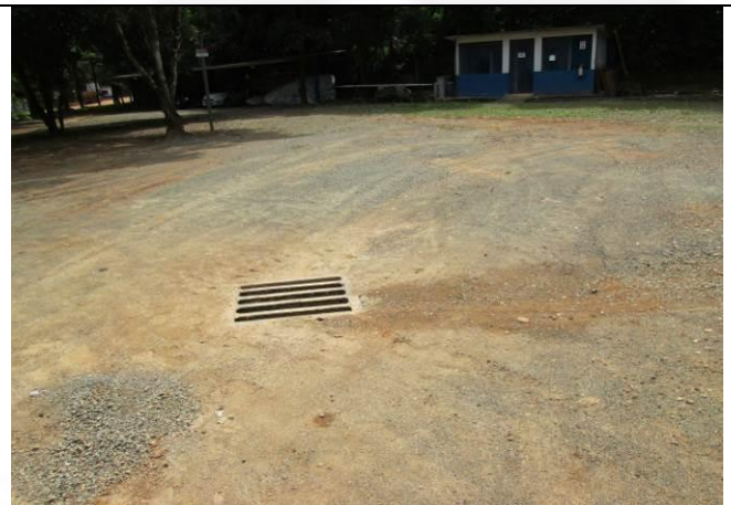
Foto 2: Pátio com drenagem de água pluvial
