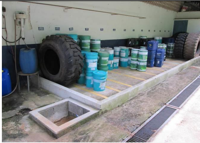
Foto 3: Depósito coberto e piso impermeabilizado de lubrificantes com caixa coletora com registro
