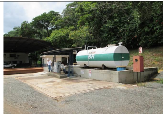
Foto 5: TAC com piso impermeabilizado e canaletas de contenção de vazamento de óleo
