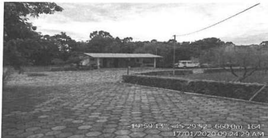
Figura 10: Setor administrativo, sanitários e estacionamento.
