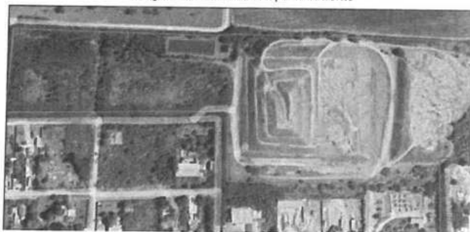
Imagem 01 - Área do Empreendimento
