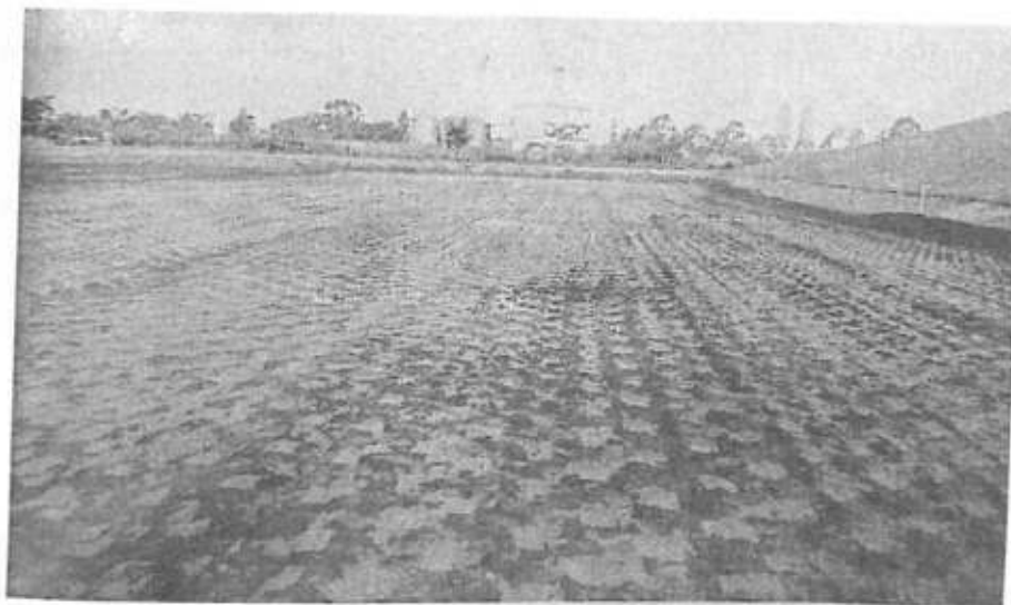
Figura 05: Obras de implantação do sistema de impermeabilização. Fonte: EIA.
