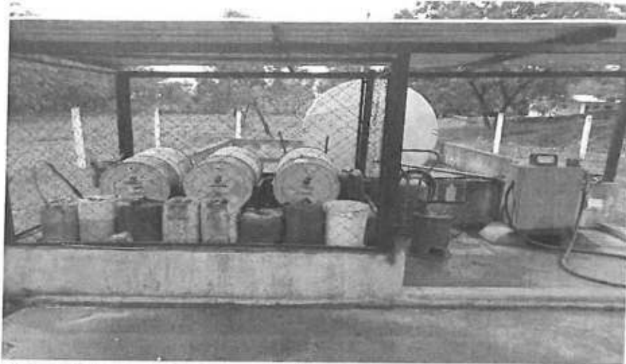
Figura 11: Tanque de armazenamento de combustível e pista de abastecimento.
