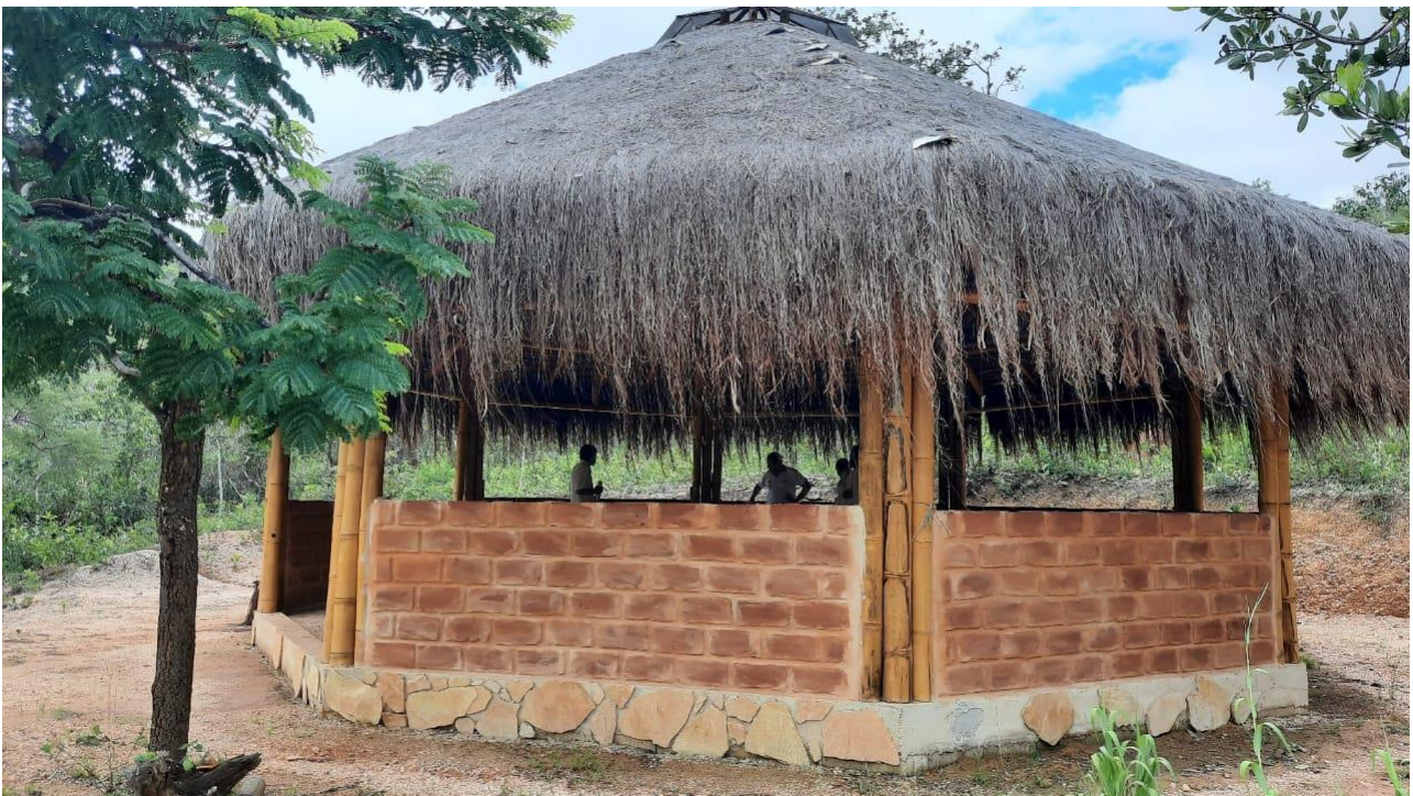
Estrutura em fase de construção que apoiará a recepção da RPPN Terra do Sol, situada fora da Unidade de Conservação em área limítrofe.
