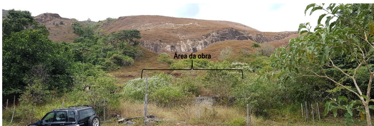
Figura 2.5: Vista lateral da drenagem com a área da obra das piscinas
