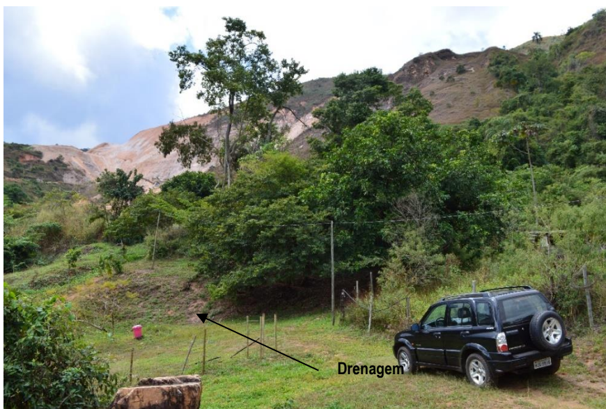
Figura 2.4: Vista da drenagem no ponto abaixo da obra as piscinas
