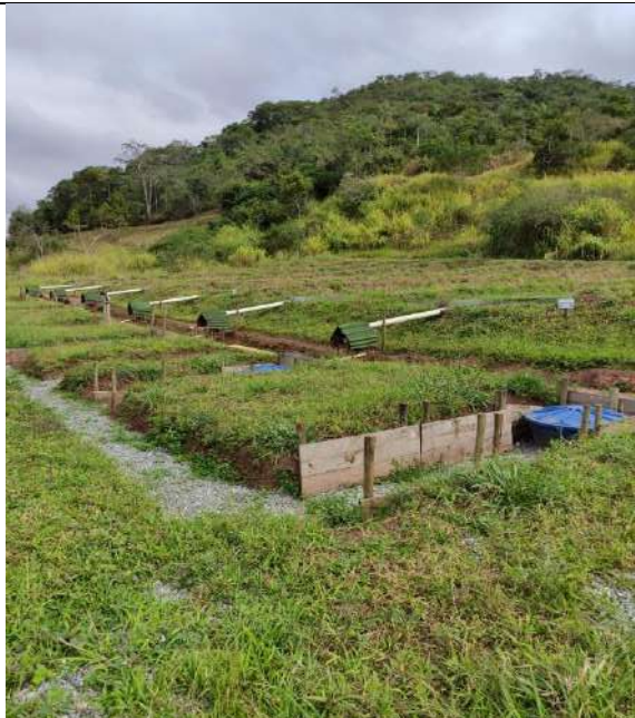
Foto 57: Sistema experimental de contenção de erosão laminar
