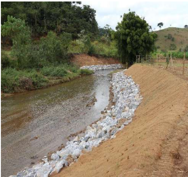
Foto 28: Enrocamento e graminhas em fase bem inicial de desenvolvimento através da biomanta
