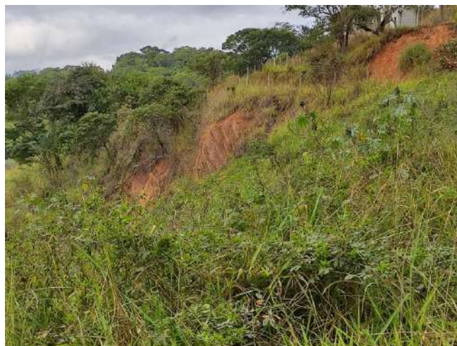
Foto 48: Talude com processo erosivo
