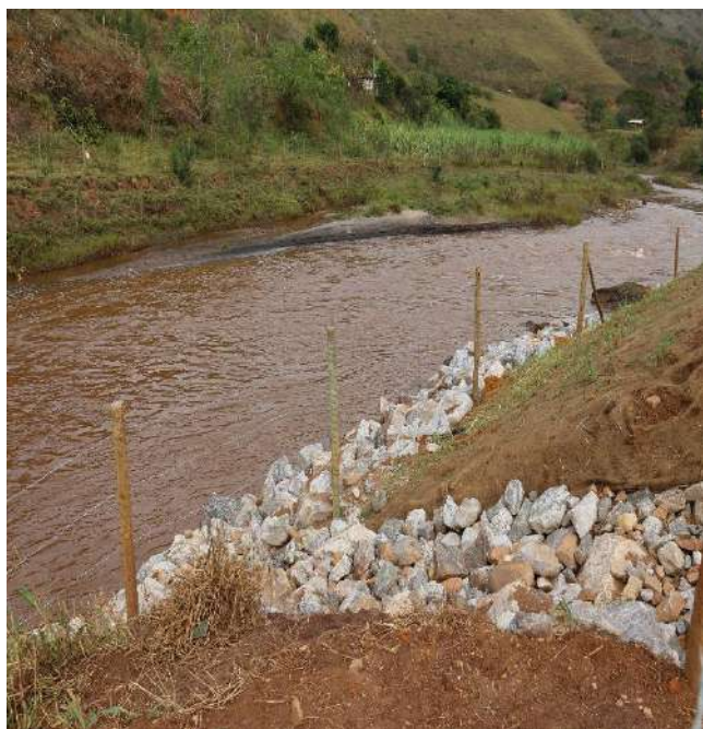
Foto 20: Retaludamento e enrocamento para estabilização da margem
