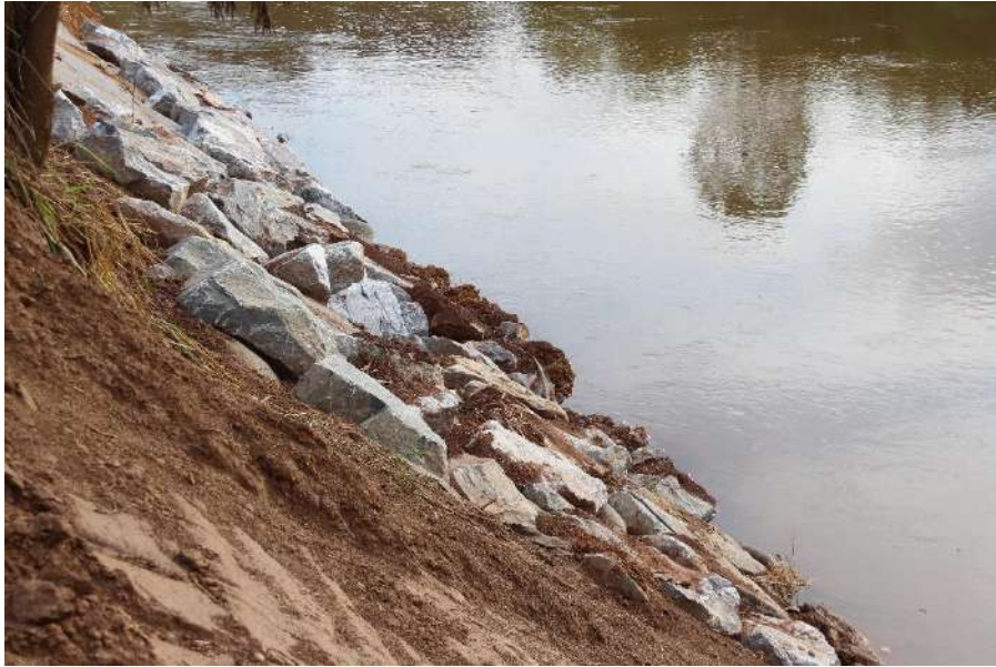
Foto 33: Enrocamento utilizando rochas grandes
