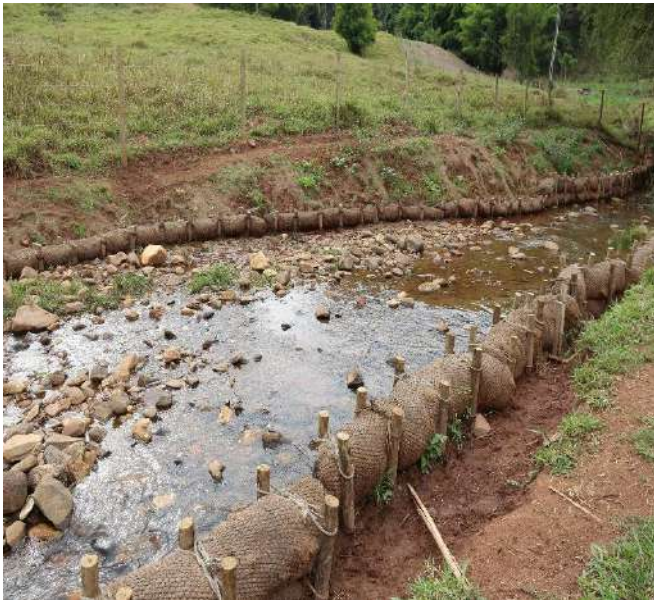
Foto 23: Biorretentores/biorolo e paliçadas de madeira em detrimento ao enrocamento devido à pequena altura do talude.
