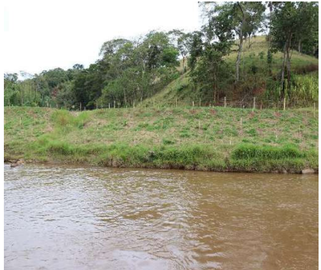
Foto 38: Enrocamento estabilizado as margens do rio Gualaxo.
