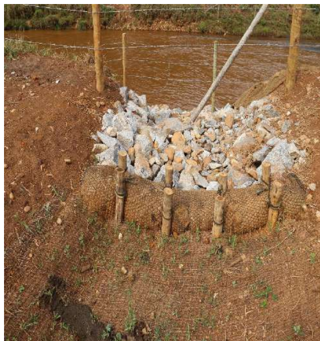
Foto 21: Biomanta constituída por fibra de coco e detalhe do enrocamento e Biorretentores para descida de água
