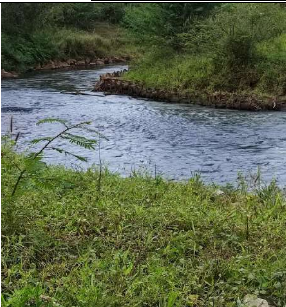
Foto 11: Biorretentores na margem direita
