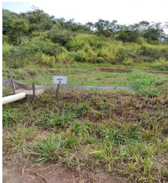
Foto 58: Área inoperante, com predomínio de braquiária no local.
