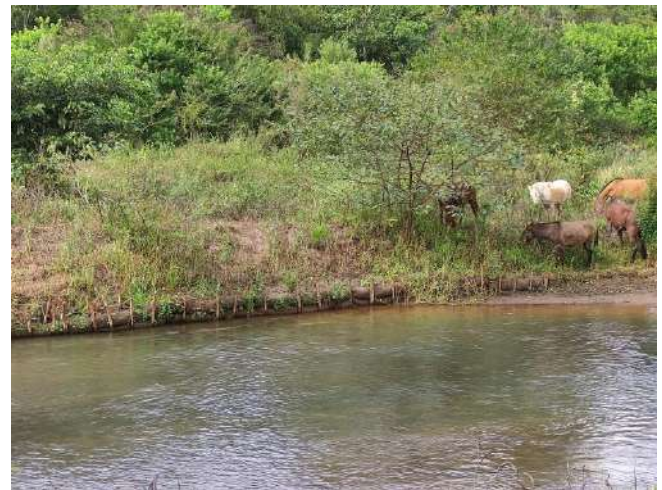
Foto 8: Presença de biorretentores na margem do rio Gualaxo do Norte
