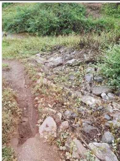
Foto 37: Enrocamento de 2016 incorporado ao meio e recobrimento vegetal
