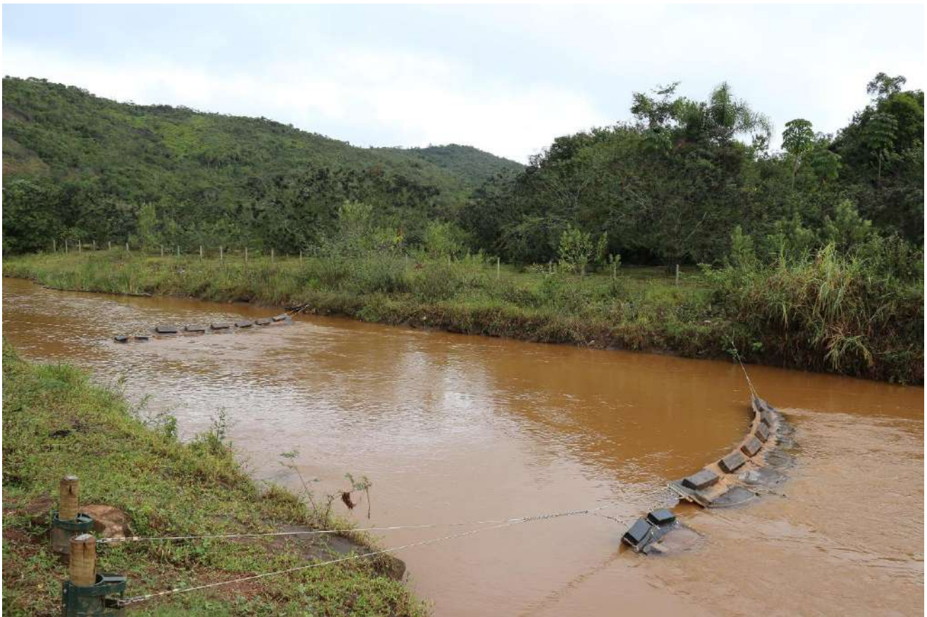
Foto 3: Estação de Tratamento Natural - ETN - Conjunto de 4 sacos com membranas filtrantes instalados com 4 cabos que cruzam o rio, de margem a margem
