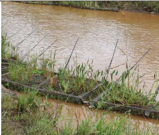
Foto 4: Estação de Tratamento Natural – ETN - Ilhas flutuantes com cultivo de espécies aquáticas
