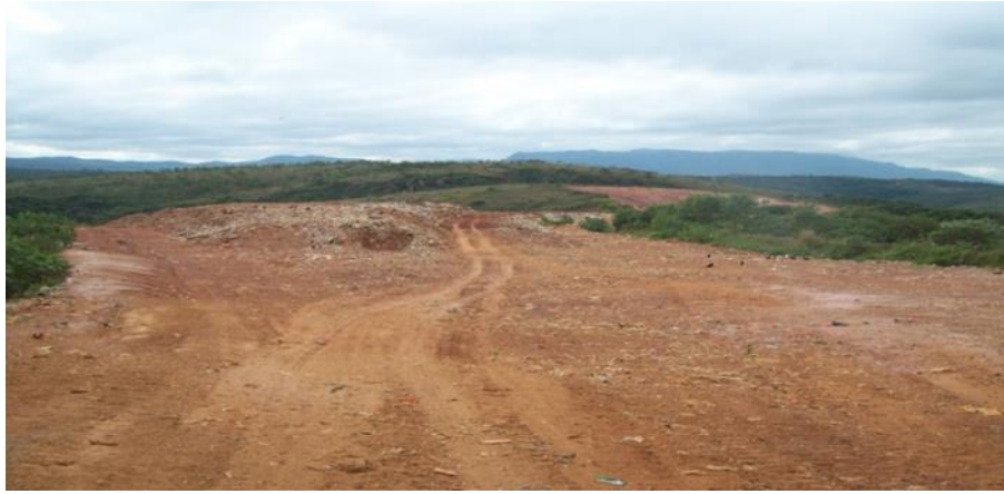
Figura 7: Vista parcial do aterro de Congonhas Fonte: Acervo próprio (2015).
