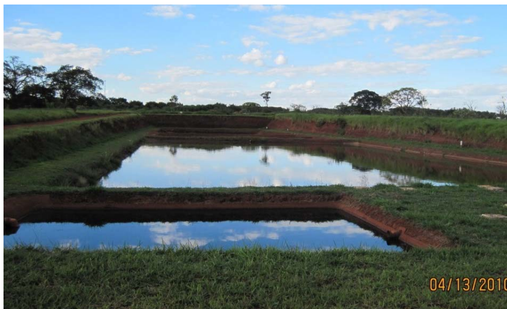
Figura 7. Lagoas de Evaporação de Chorume
