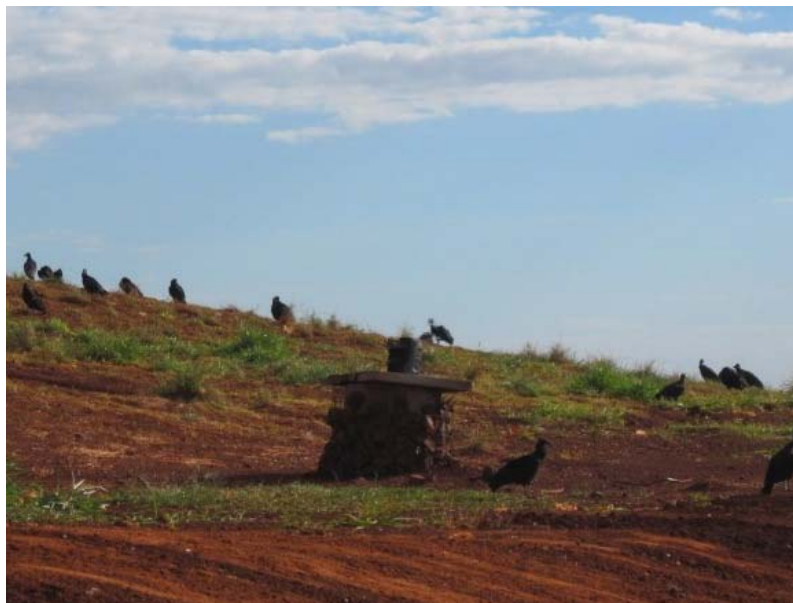
Figura 10. Poço de Dreno com Queima de GAS
