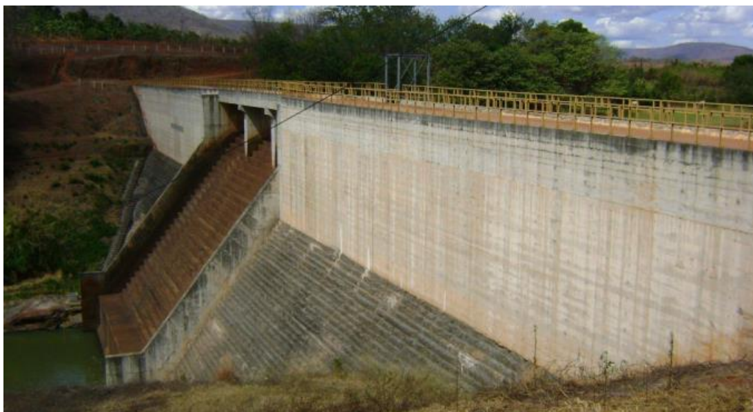
Figura 3: Vista de uma barragem construída em concreto compactado a rolo. Fonte: Possan, [201-].
