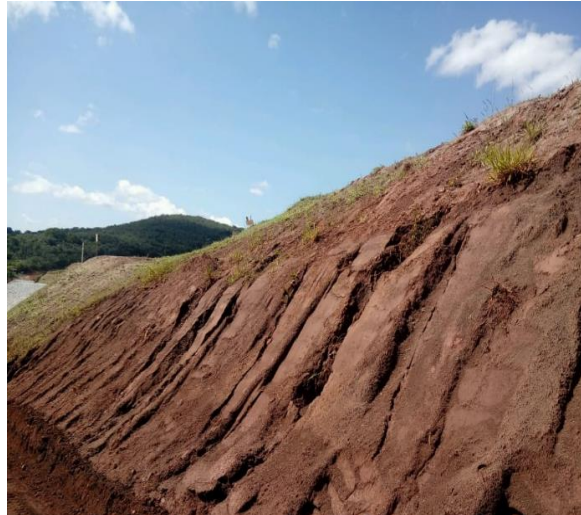
Figura 27: Sulcos erosivos em estágio inicial de desenvolvimento. Fonte: Acervo Feam.
