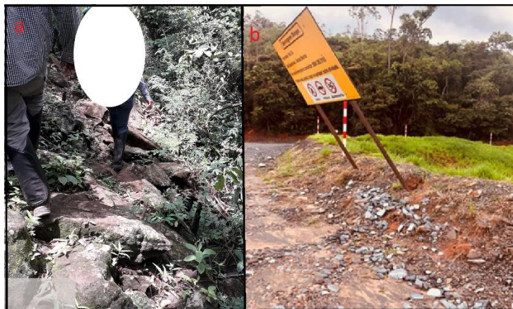
Figura 44: trilha de acesso à barragem em maus condições de circulação (a) e placa de sinalização tombada (b).
