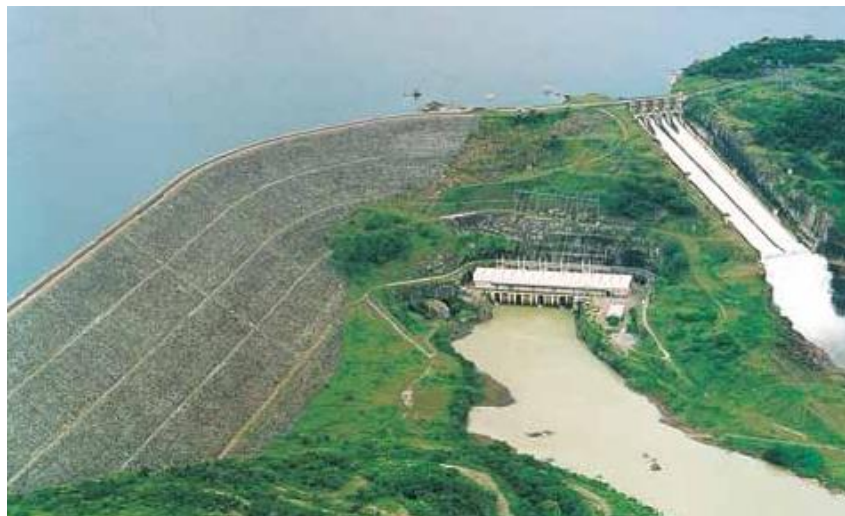
Figura 6: Vista de uma barragem de enrocamento com função de armazenamento de água. Fonte: CBDB, 2011.
