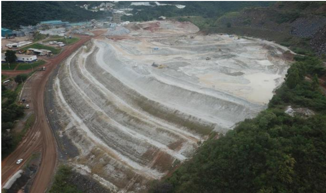
Figura 8: Vista de uma barragem de aterro hidráulico, construída com rejeito de mineração. Fonte: GeoHydroTech, 2022.
