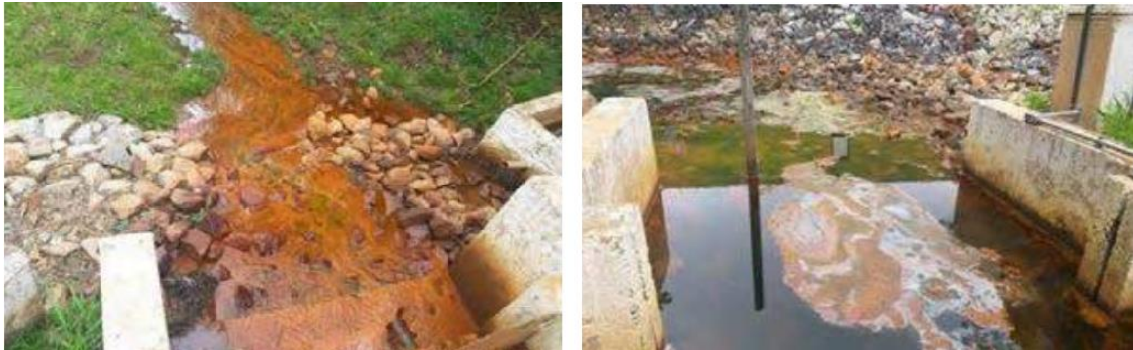
Figura 34: Ação de ferro-bactérias na bacia do dreno de fundo. Fonte: Acervo Feam.
