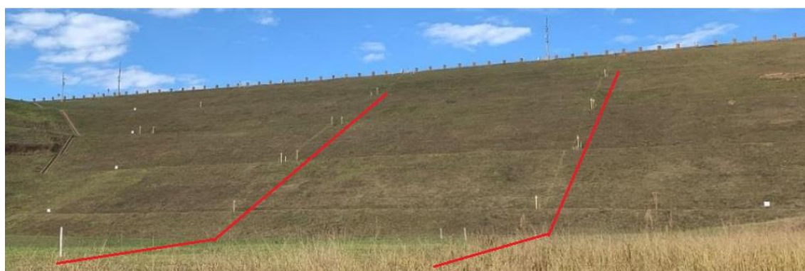
Figura 15: Seções instrumentadas em uma barragem de terra. Fonte: Acervo Feam.
