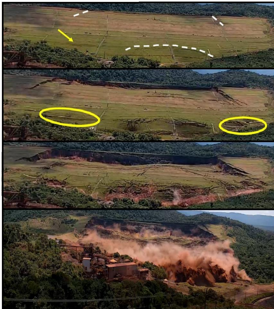
Figura 21: Sequência do processo de ruptura por liquefação da Barragem B1. Fonte: Adaptado de MPMG, 2020.
