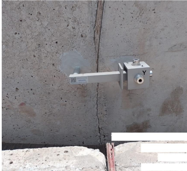
Figura 43: Monitoramento de uma junta na estrutura de concreto. Fonte: Acervo Feam.
