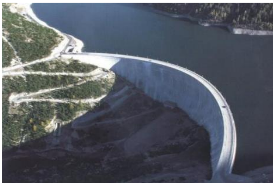
Figura 1: Vista de uma barragem de concreto do tipo arco duplo, utilizada para armazenamento de água. Fonte: Possan, [201-].
