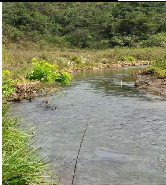
Foto 12: Enrocamentos na margem esquerda do rio Gualaxo do Norte
