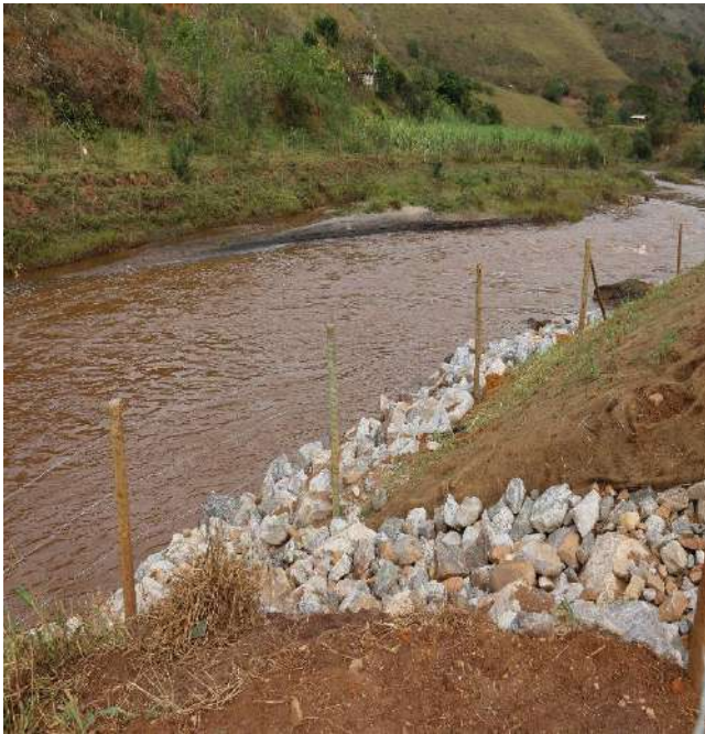
Foto 20: Retaludamento e enrocamento para estabilização da margem
