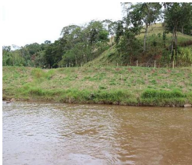
Foto 38: Enrocamento estabilizado as margens do rio Gualaxo.
