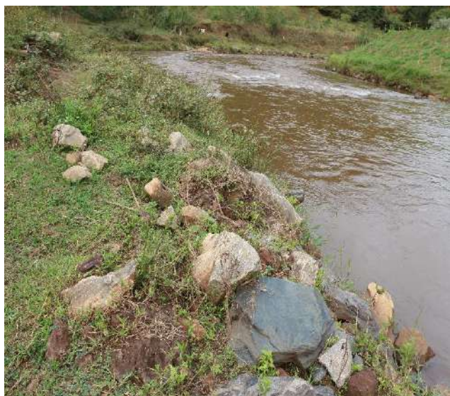
Foto 37: Enrocamento enriquecido com mix de sementes.
