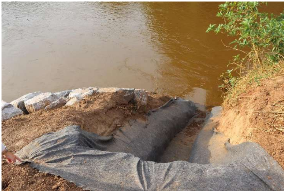
Foto 34: Descida de água iniciada
