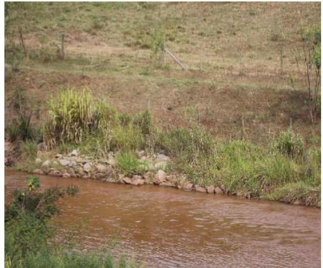
Foto 31: Obra de engenharia de enrocamento estabilizada, no rio Gualaxo, abaixo da saída do tributário.
