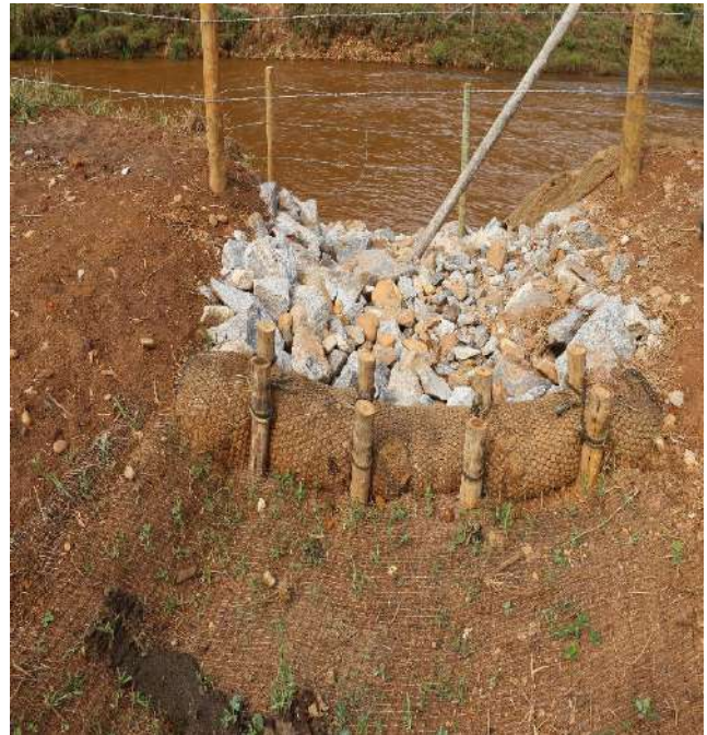
Foto 21: Biomanta constituída por fibra de coco e detalhe do enrocamento e Biorretentores para descida de água
