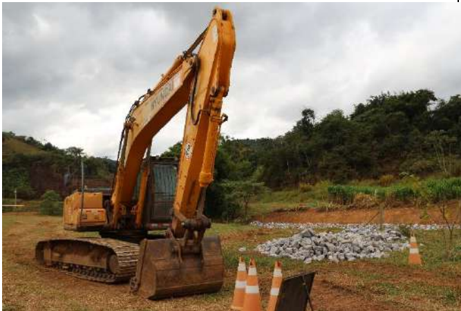
Foto 26: Obra em processo de execução
