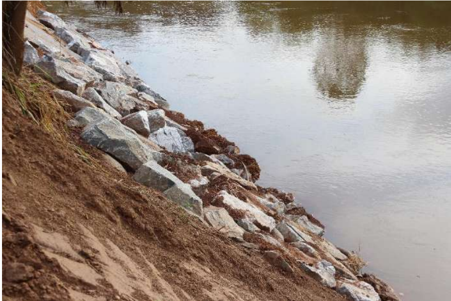
Foto 33: Enrocamento utilizando rochas grandes
