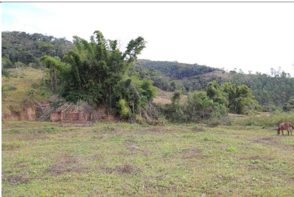
Foto 2: Presença de equino e construção com marcas do extravassamento do rejeito, no entorno da lagoa
