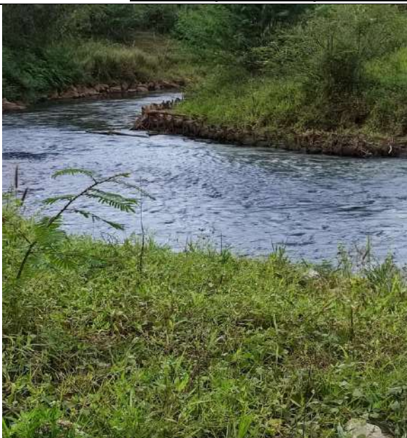
Foto 11: Biorretentores na margem direita
