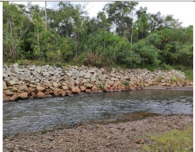
Foto 4: Enrocamentos na margem direita do rio Gualaxo do Norte
