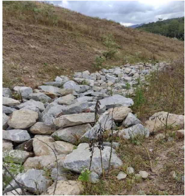
Foto 19-a: Enrocamentos ITS07
