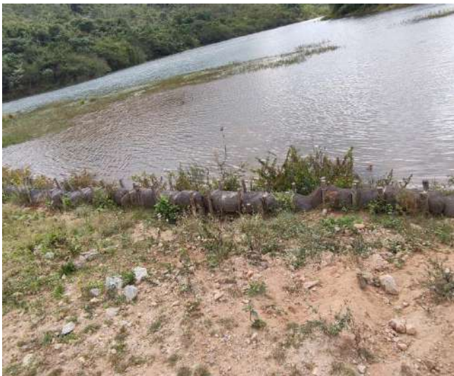
Foto 19-b: Biorretentores ITS07
