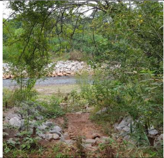
Foto 6: Estrutura de contenção de sedimentos
