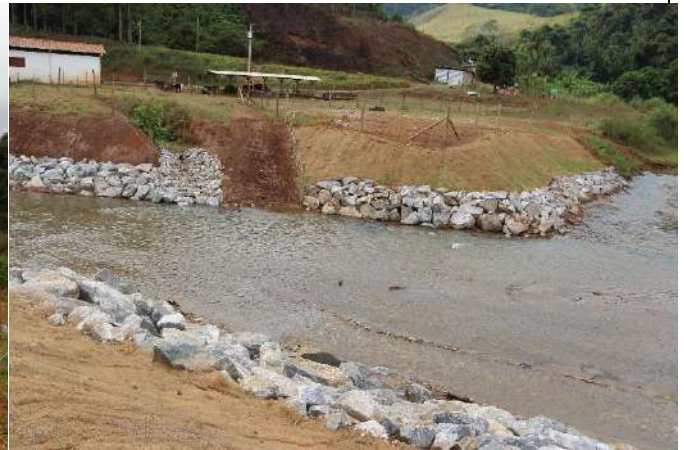
Foto 27: Rampa para utilização da margem para dessedentação animal entre enrocamento nas margens dos tributários
