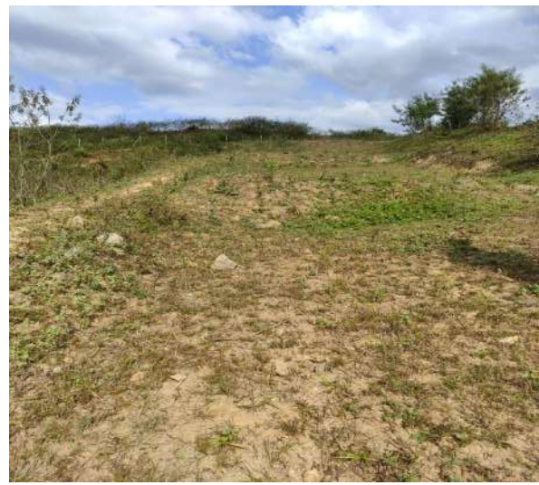
Foto 19-c: Degraus para dissipação de energia ITS07
