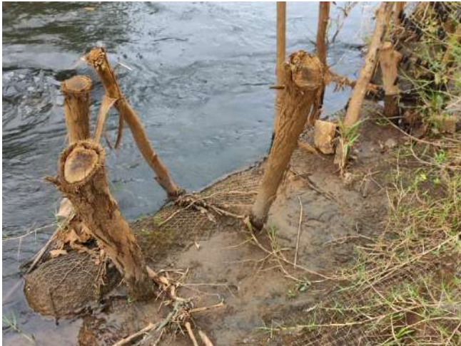
Foto 1: Biorretentores na margem esquerda do rio Gualaxo do Norte
