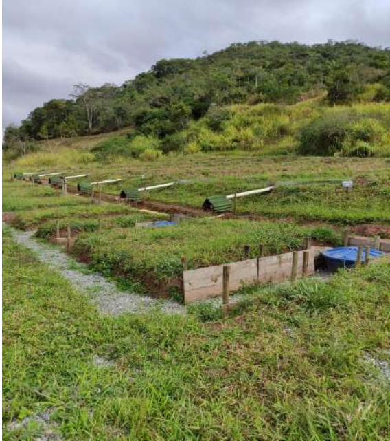
Foto 57: Sistema experimental de contenção de erosão laminar
