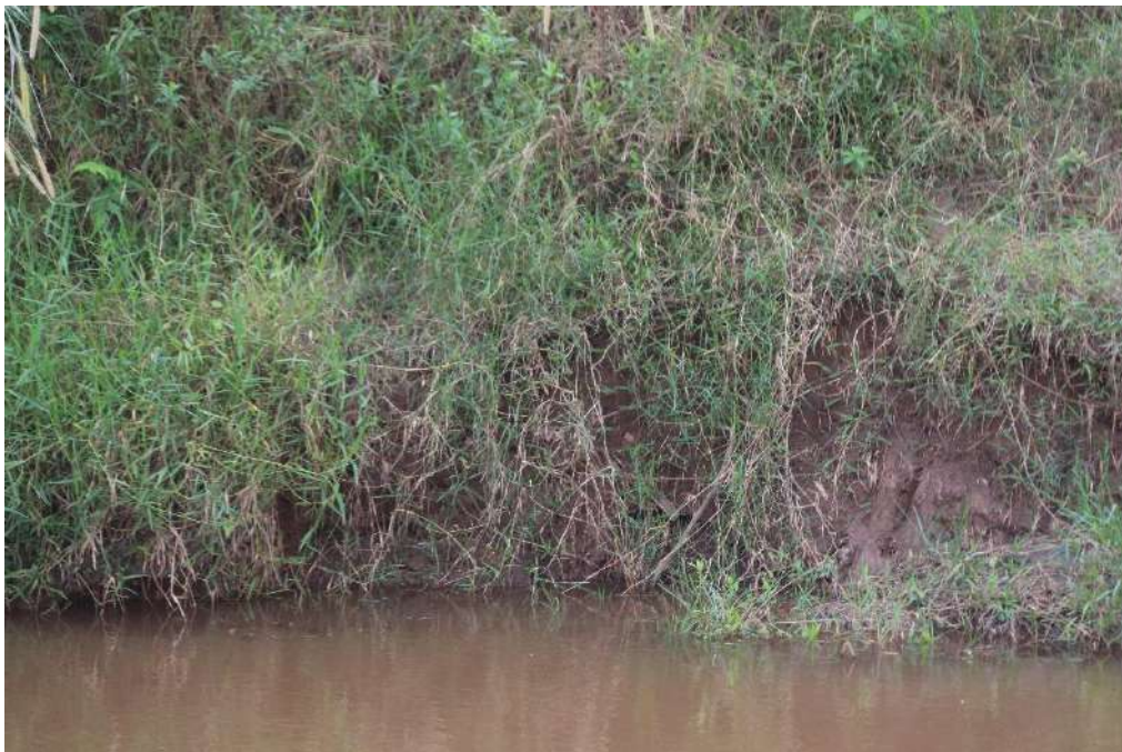
Foto 36: Detalhe mostrando a área de erosão a ser recomposta
