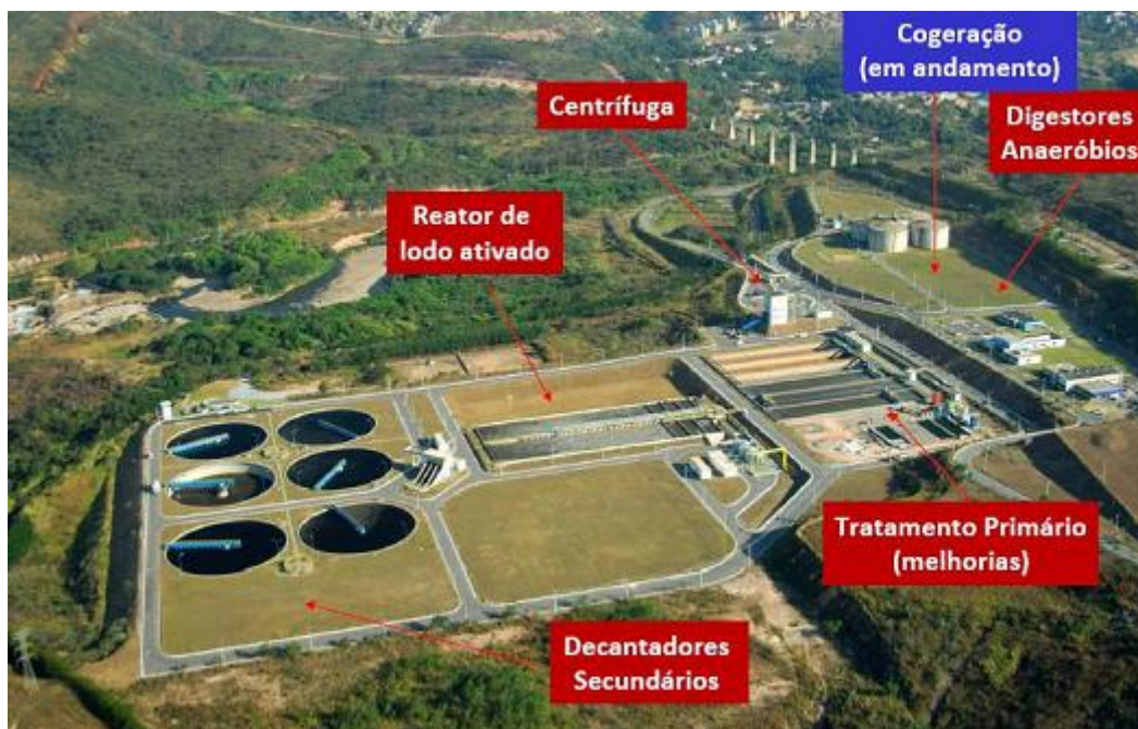
Figura 7 - Principais módulos da estação de tratamento de esgoto de Arrudas. Em azul, a central termelétrica (Fonte: Licença de instalação da estação)
