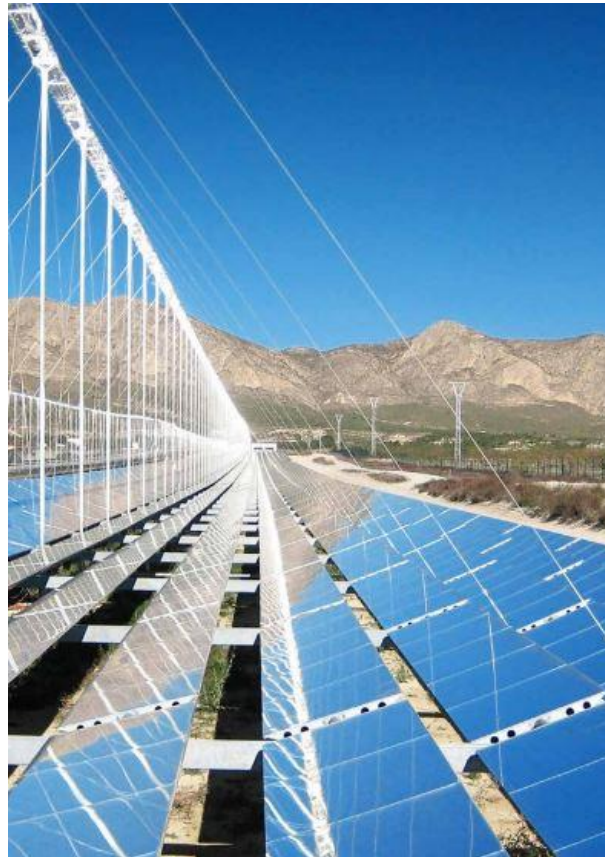
Figura 12: Refletor Linear Fresnel.
