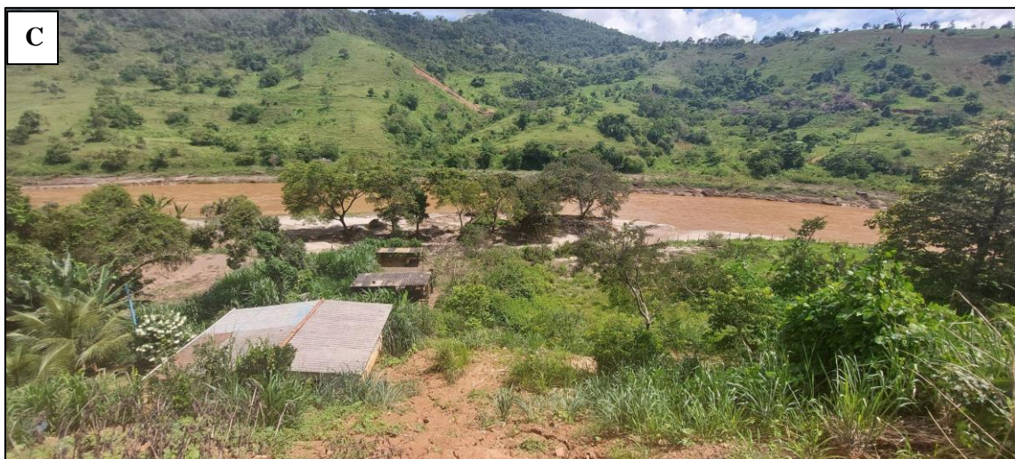
Fotos 08 A, B e C: Presença de bancos de sedimentos formados após as chuvas de janeiro de 2022.
