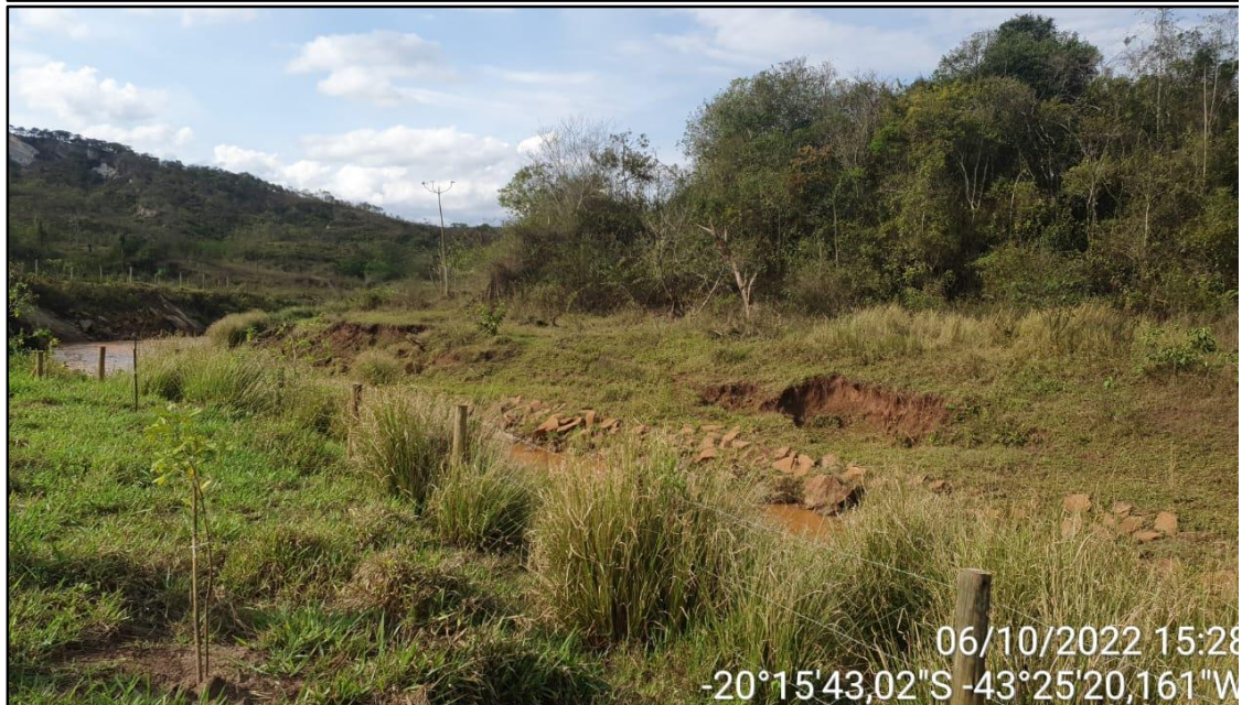
Fotos 17a e b: Área do Ponto 17. a) Solapamento do talude com exposição de enrocamento. b) Detalhe do capim Vetiver.
