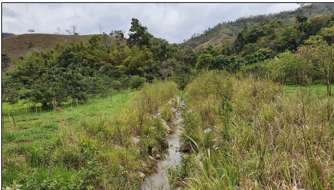
Foto 16: Vista do bueiro substituído no local para disciplinamento da drenagem.
