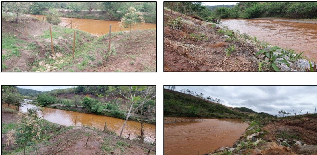
Fotos 12a, b, c e d: Controle de processos erosivos no Ponto 12.
