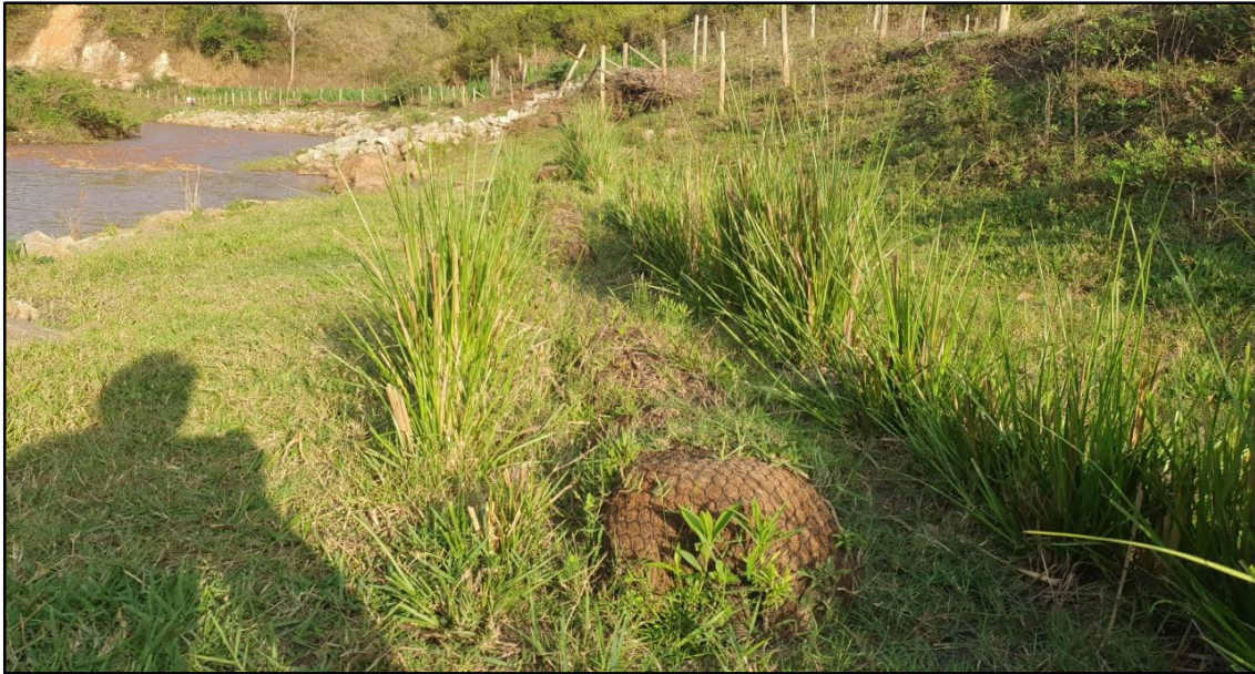
10b: Detalhe do capim vetiver enfileirado com implantação de biorretentor ao centro.
