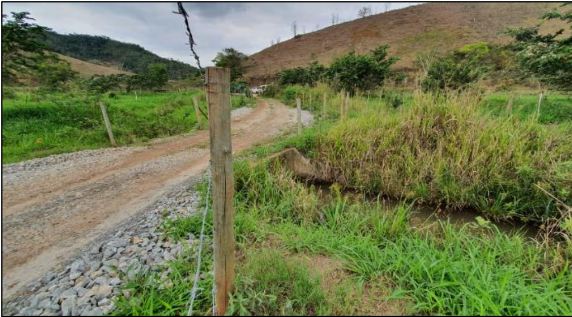
Foto 15: Vista do bueiro substituído no local para disciplinamento da drenagem.
