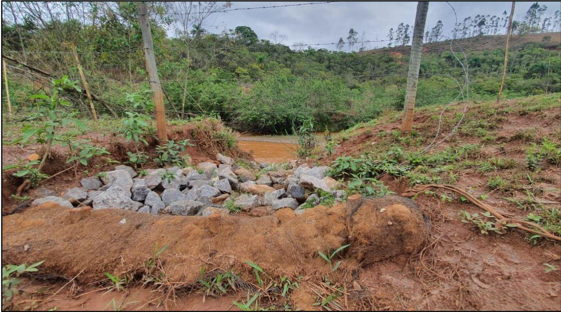
Foto 13: Detalhe do bioretentor em primeiro plano e do revestimento da canaleta de drenagem, com enrocamento, em segundo plano.
