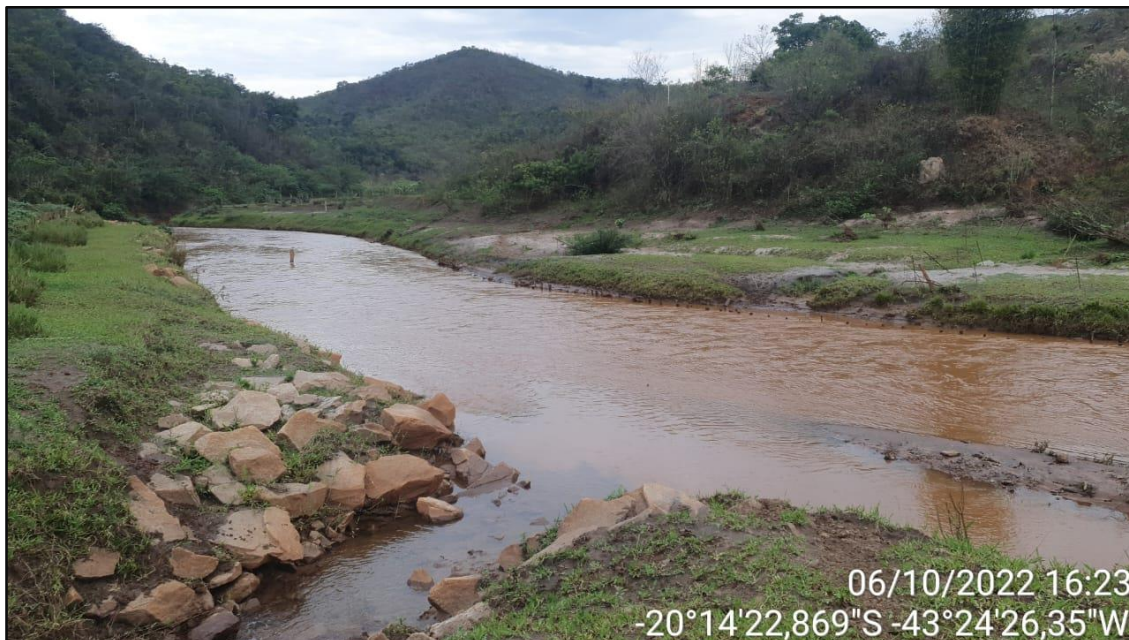
Fotos 18: Tributário do rio Gualaxo do Norte em primeiro plano, com implantação de enrocamento na base do talude.
