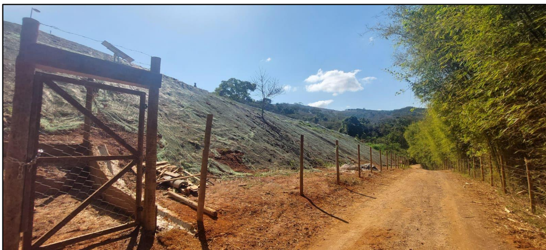
Foto 7: Vista geral do talude com aplicação de tela fotossensível.
