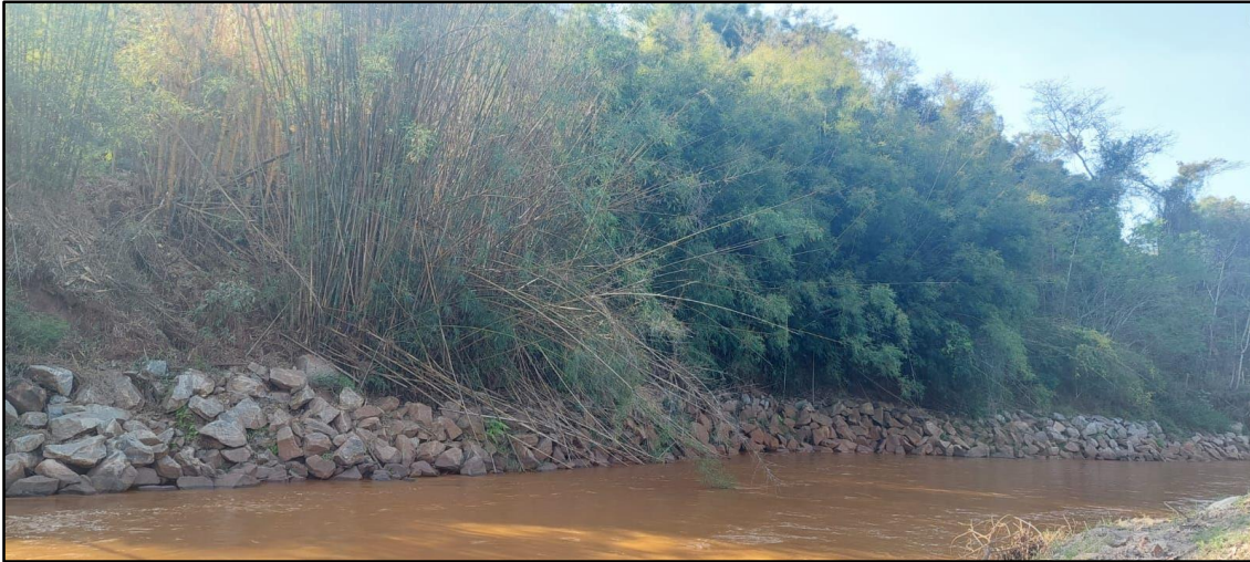
Foto 9: Vista do enrocamento inserido no Ponto 09.
