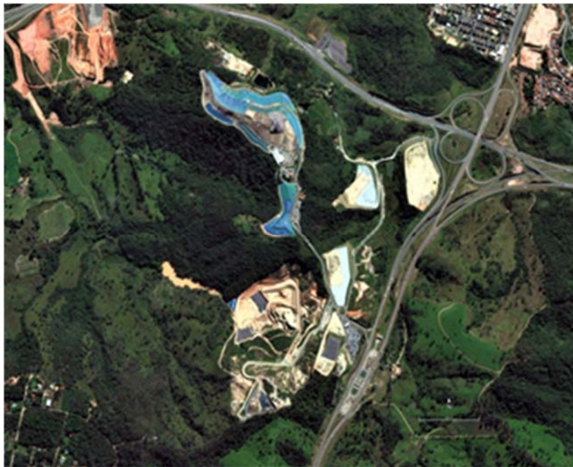
Figura IV.1-2 – Vista Aérea de Aterro Gerenciado pela Essencis.
