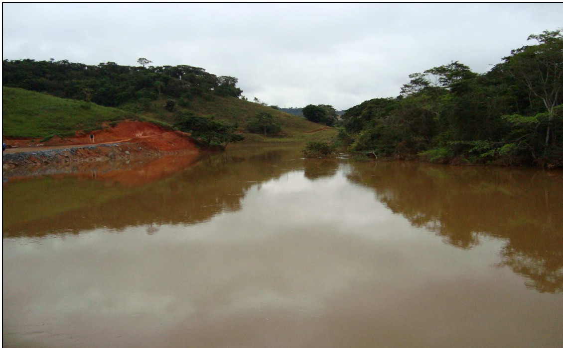
Figura 1: reservatório a montante ao eixo do barramento.
