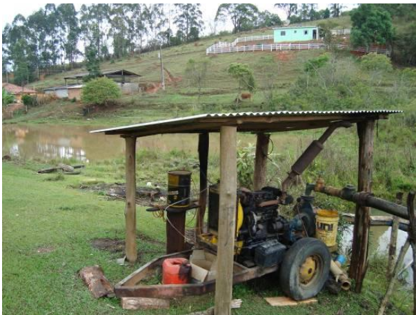
Figura 70 – Captação para a irrigação de olerícolas.
