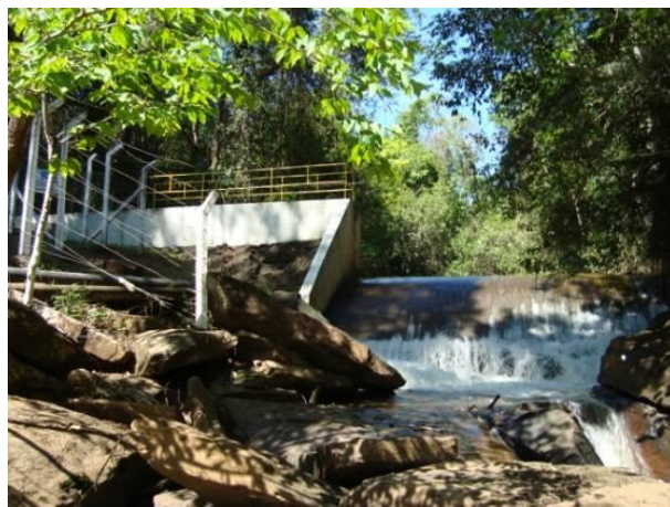
Figura 178 - Ponto de captação para o abastecimento doméstico e industrial de sede municipal de Carmo da cachoeira.
