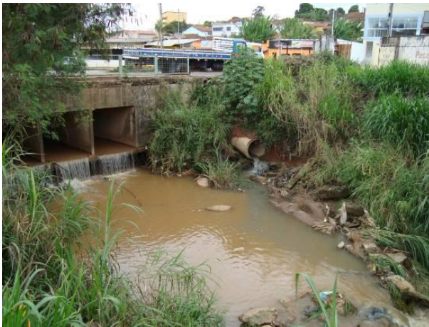
Figura 192 - Ponto de lançamento de efluentes domésticos e industriais da sede municipal de Oliveira.
