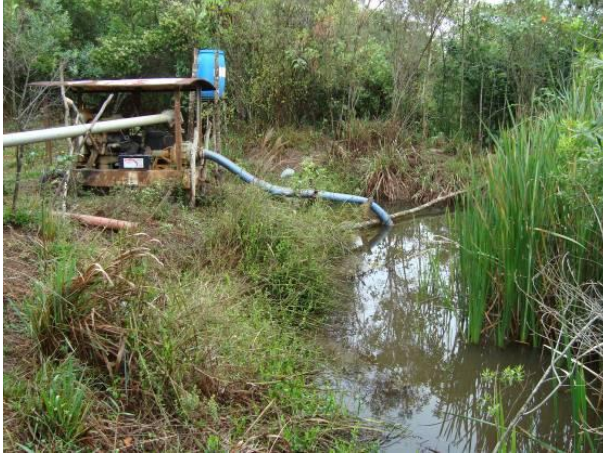
Figura 65 - Ponto de captação para irrigação tipo aspersão (Tomate e repolho.).
