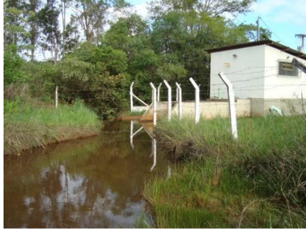
Figura 196 - Ponto de captação para o abastecimento doméstico e industrial da sede municipal de São Francisco de Paula.
