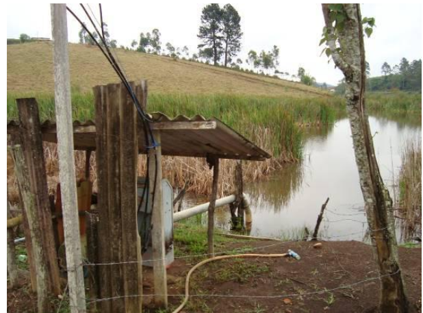
Figura 60 - Ponto de captação para irrigação tipo aspersão (Tomate e repolho.).
