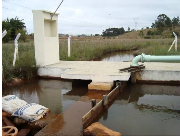
Figura 131 - Ponto de captação para o abastecimento doméstico e industrial da sede municipal de São Tiago.
