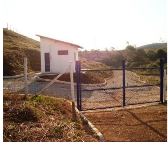
Figura 44 - Estação de tratamento de esgoto de Ressaquinha.
