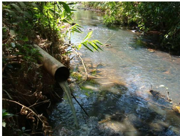
Figura 54 - Ponto de lançamento de efluentes domésticos do povoado rural Bichinho (Prados). Fonte: Ecoplan-Lume-Skill, 2011.
