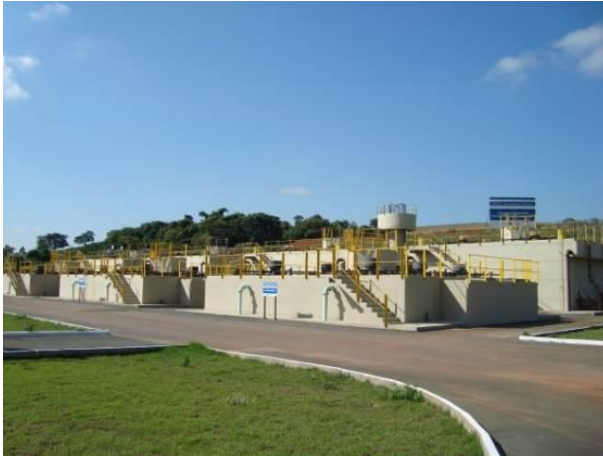
Figura 168 - Estação de tratamento de efluentes da sede municipal de Lavras.
