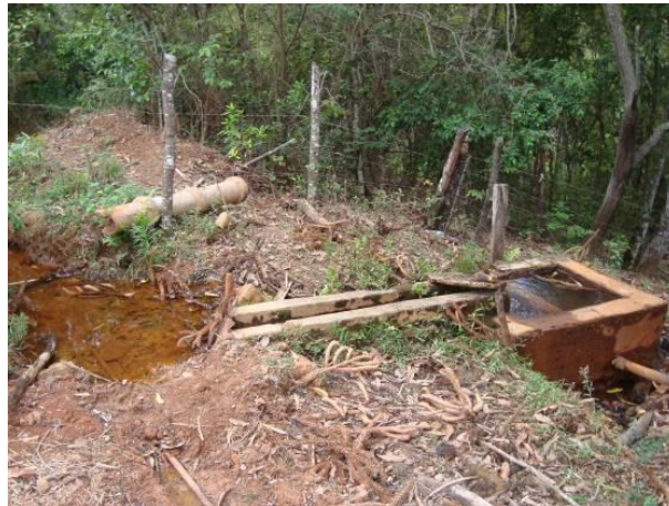
Figura 130 - Captação para abastecimento doméstico do povoado rural Jorge (São Tiago).
