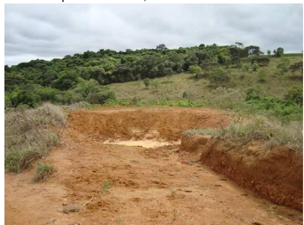
Figura 187 - Pequena barragem construída à margem da estrada vicinal para o acúmulo de água pluvial e sedimentos.
