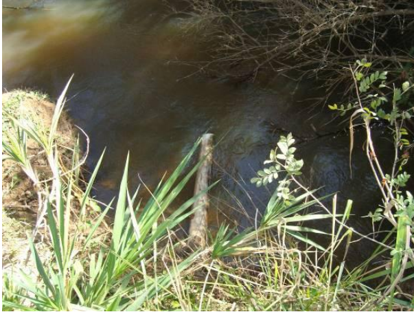
Figura 84 - Ponto de lançamento de esgoto "in natura" da sede municipal de Ibertioga.
