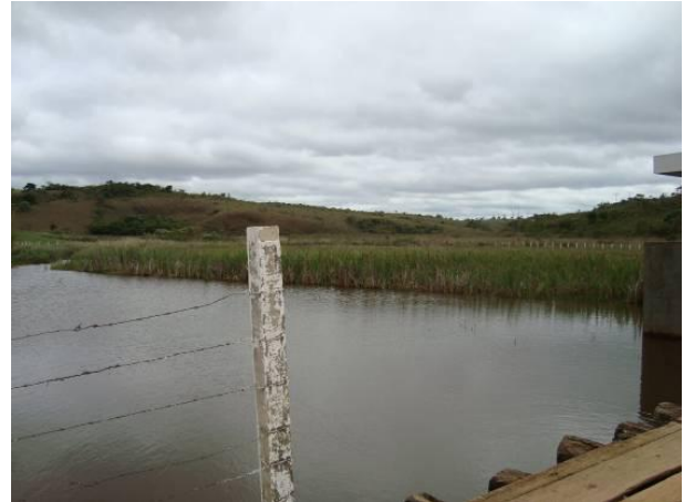
Figura 189 - Ponto de captação para o abastecimento doméstico e industrial da sede municipal de Oliveira.
