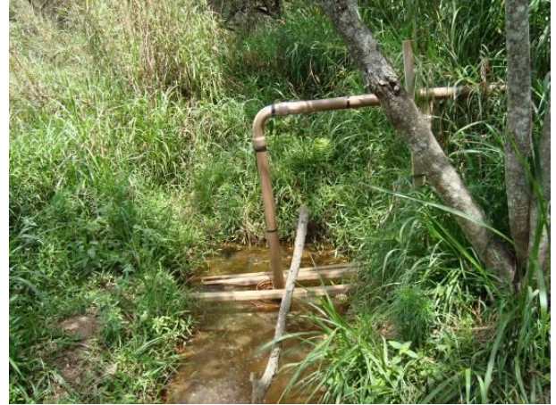
Figura 29 - Captação para o abastecimento industrial.
