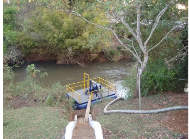
Figura 85 - Em destaque a balsa de captação para o abastecimento doméstico e industrial da sede municipal de Tiradentes.
