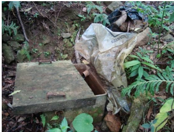
Figura 160 - Ponto de captação para o abastecimento doméstico da sede municipal de Ijaci (somente o bairro Vila Industrial).
