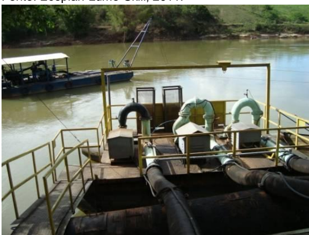
Figura 158 - Ponto de captação para o abastecimento doméstico e industrial da sede municipal de Lavras.
