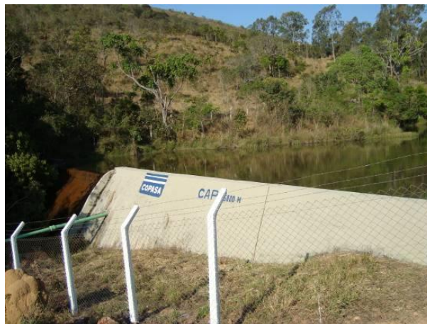
Figura 45 - Ponto de captação para o abastecimento doméstico e industrial da sede municipal de Ressaquinha.
