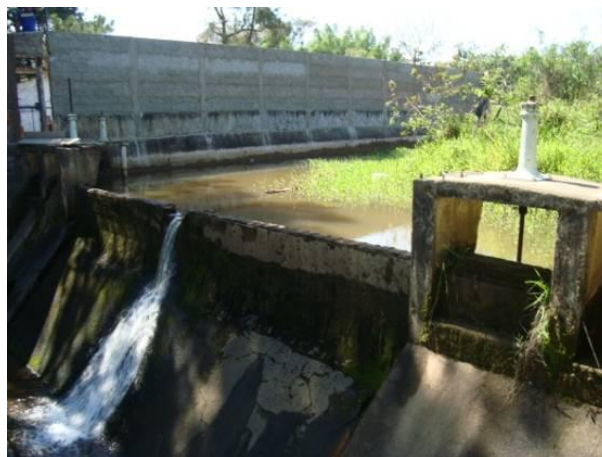
Figura 167 - Ponto de captação para o abastecimento doméstico e industrial da sede municipal de Lavras.
