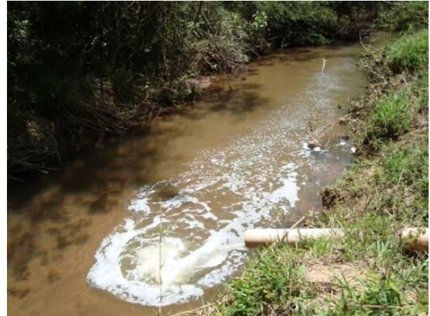
Figura 202 - Ponto de lançamento de efluentes tratados.
