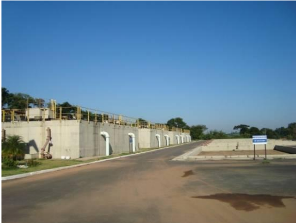
Figura 165 - Estação de tratamento de esgoto da sede municipal de Lavras.
